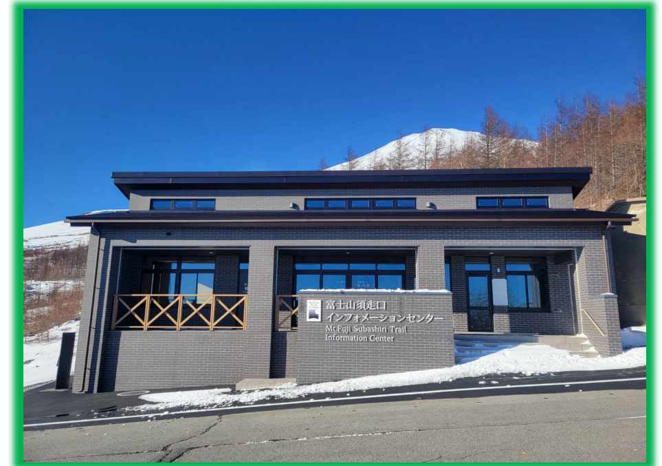
東側 南北敷地高低差1.9m
