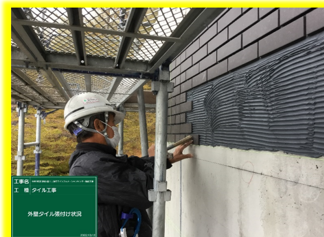
外壁タイル張り
