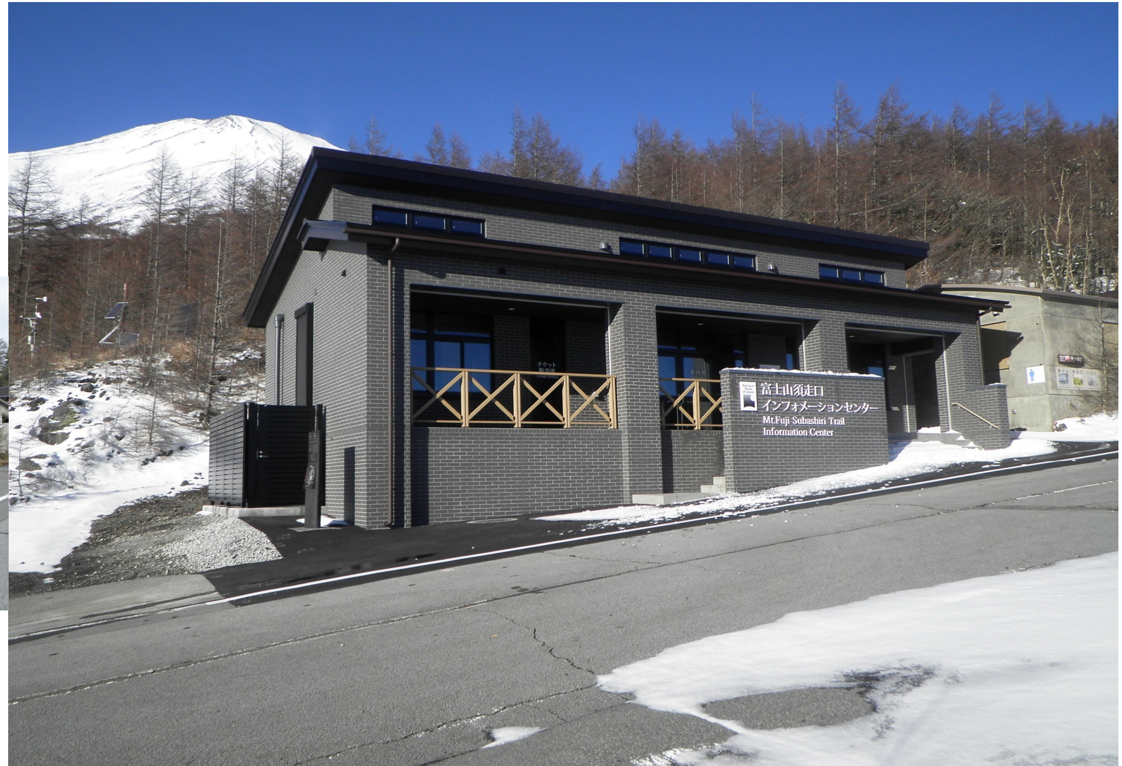
令和4年 11月 完成
