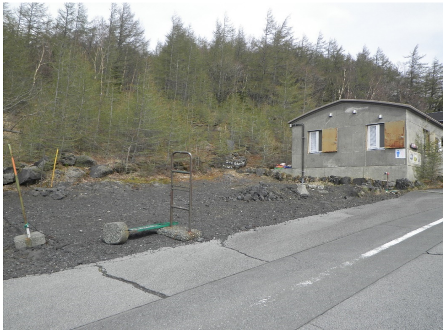
令和4年 5月 着工前
