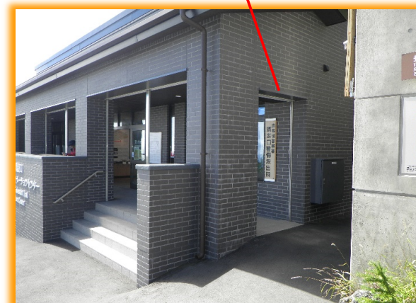
外廊下-スロープ入口 (変更提案箇所)
