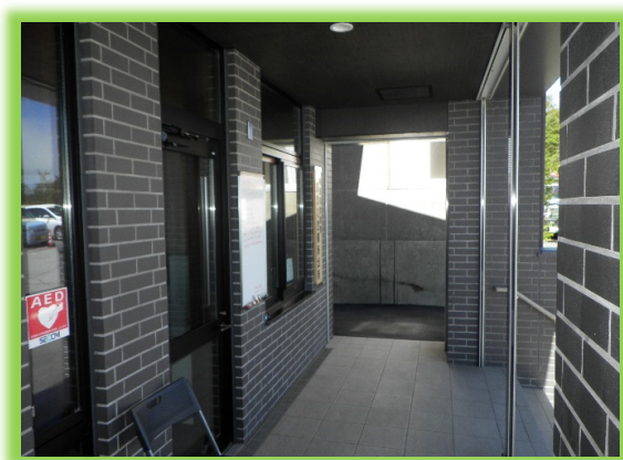
外廊下よりスロープ方向
