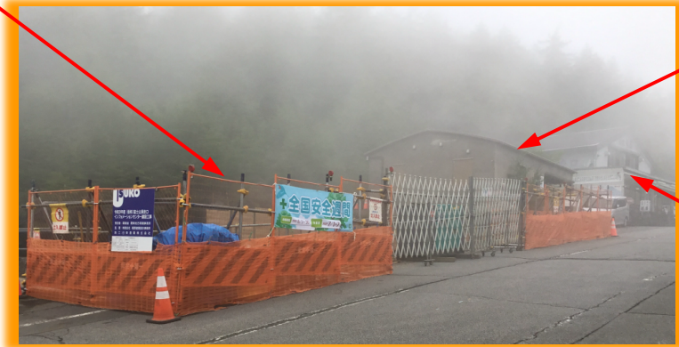
仮囲い設置状況
