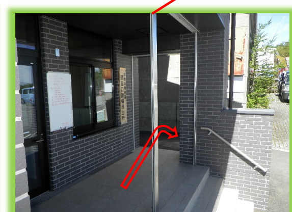
外廊下よりスロープ方向
