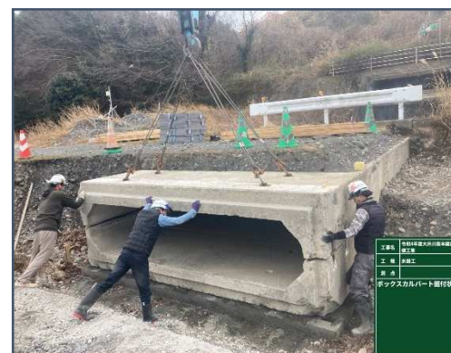
(12) ボックスカルバート据付
