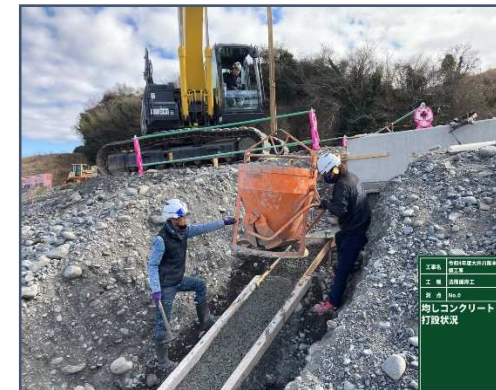
(7) 小口止め打設
