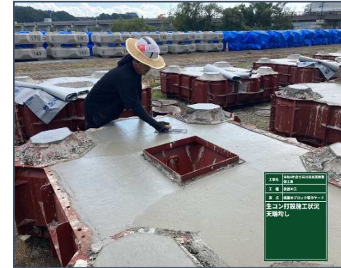
(3) 根固めブロック製作 385個+50個
