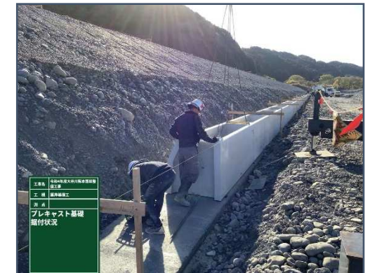
(8) プレキャスト基礎据付
