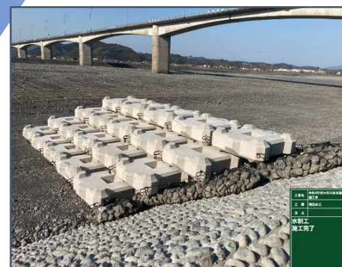
水制工ブロック据付完了
