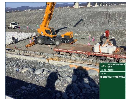
(11) 根固めブロック 水制工ブロック据付
