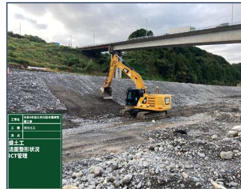
(6) ICT法面整形
