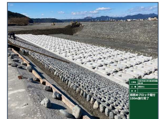
根固めブロック据付完了 →埋戻し
