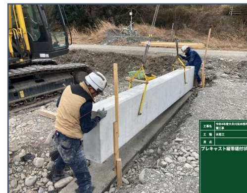
(9) プレキャスト縦帯据付
