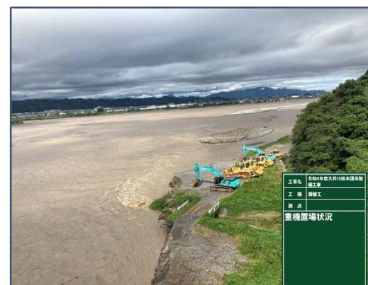
重機置き場状況
