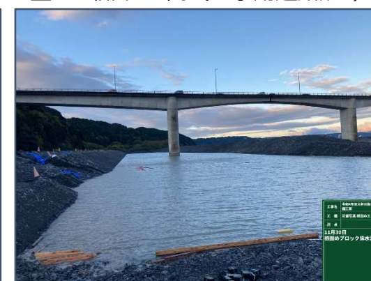
盛土と瀬替えの間（工事用道路から）
