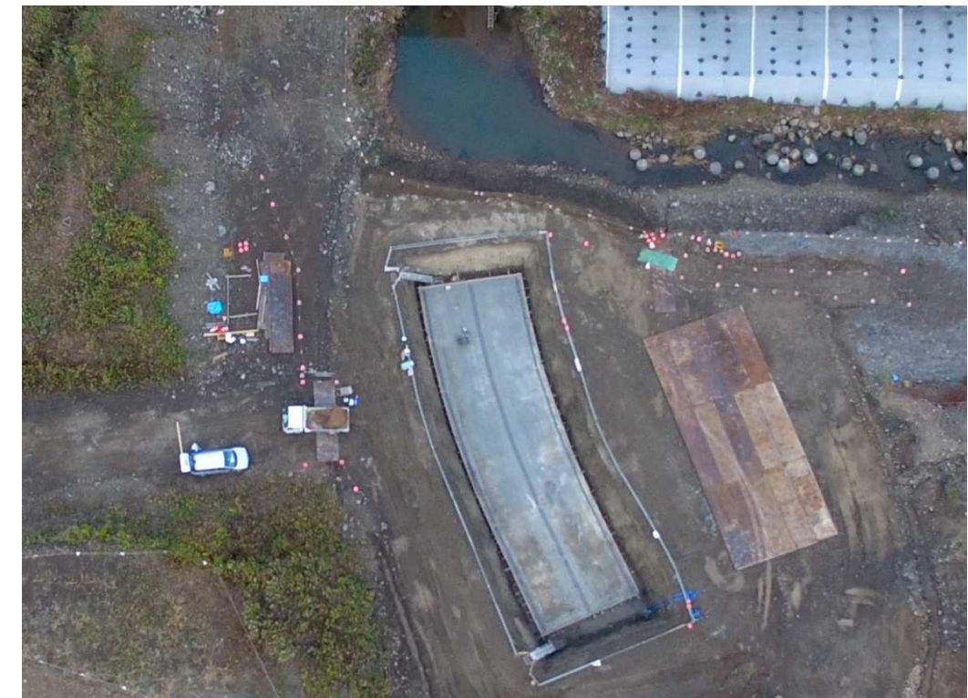
均しコンクリート打設完了 潮位の影響無し
