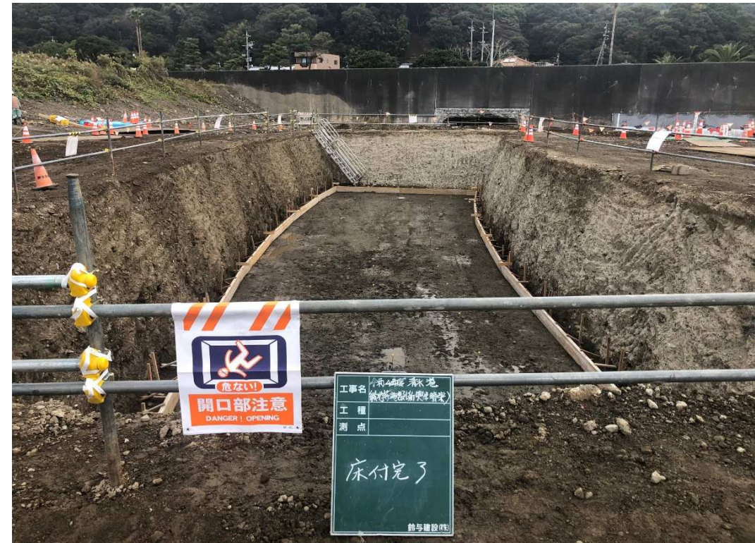
床付完了 潮位の影響無し
