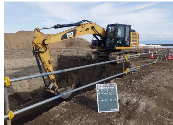
⑤ 均しコンクリート打設完了
