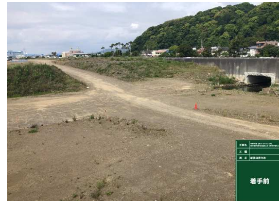
② 仮設道路工
