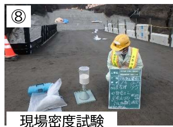
現場密度試験
