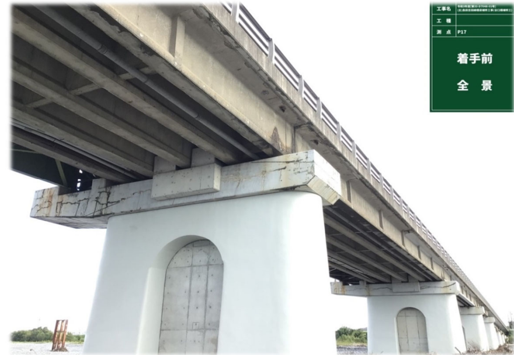
谷口橋補修 施工前(P17橋脚～)
