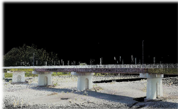
谷口橋施工箇所の3次元データ
