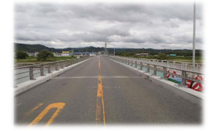
アルミ製高欄への取替え
