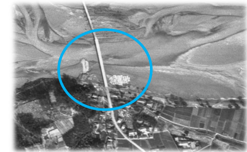
右岸側ゲルバー部
