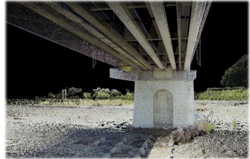
谷口橋施工箇所の3次元データ
