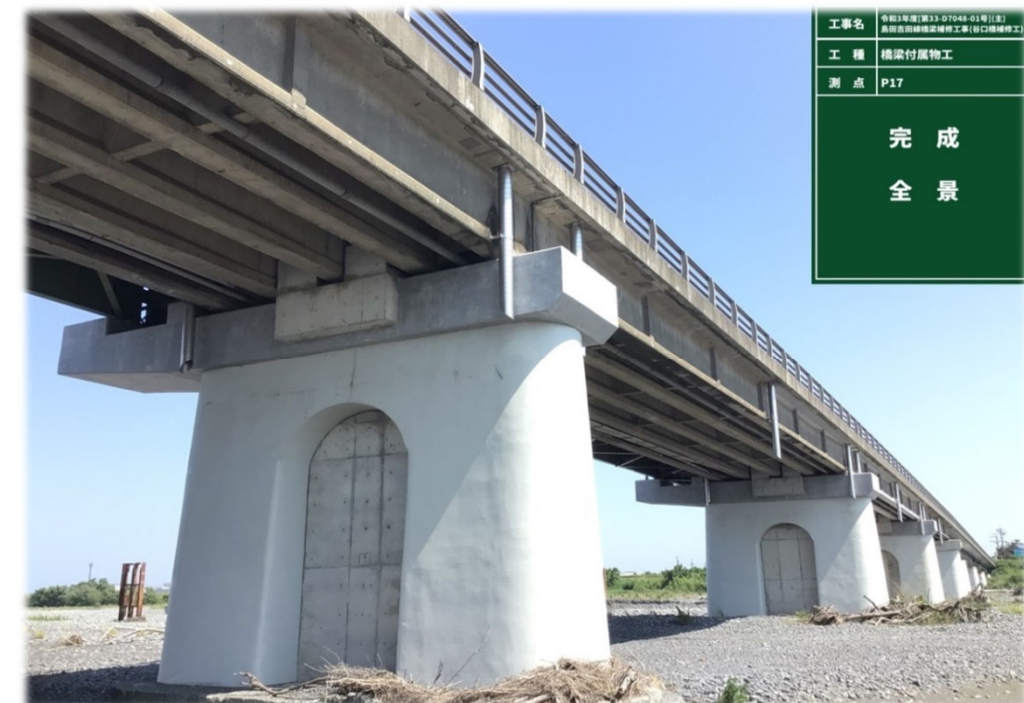
谷口橋補修 施工完了
