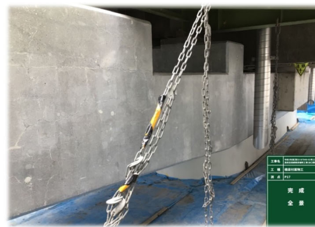
亜硝酸リチウム内部圧入工法施工完了
