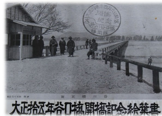
木橋完成時の様子(大正15年)
