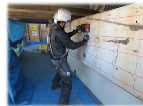
鉄筋探査実施状況
