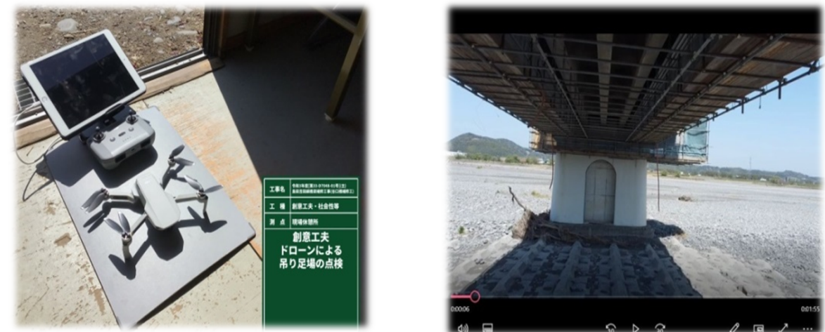
UAVによる河川からの外部足場点検実施状況
