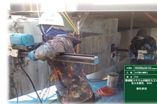
圧入工削孔状況
