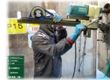
φ20コアドリル施工状況
