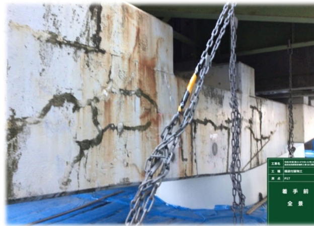
亜硝酸リチウム内部圧入工法施工前 (P17橋脚)
