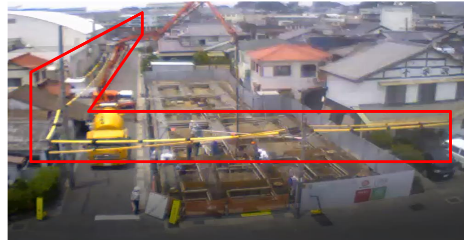
実際の施工状況
