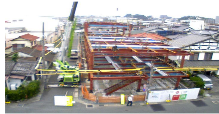
実際の施工状況
