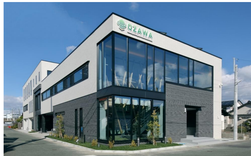
事務所新築工事
