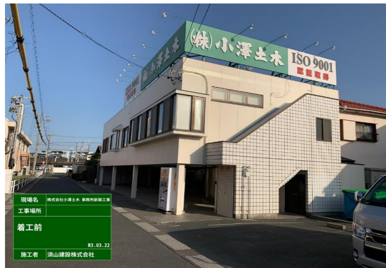
既設解体工事
