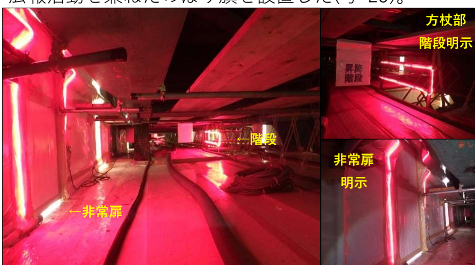
写-23. 吊足場内部(床版部)
