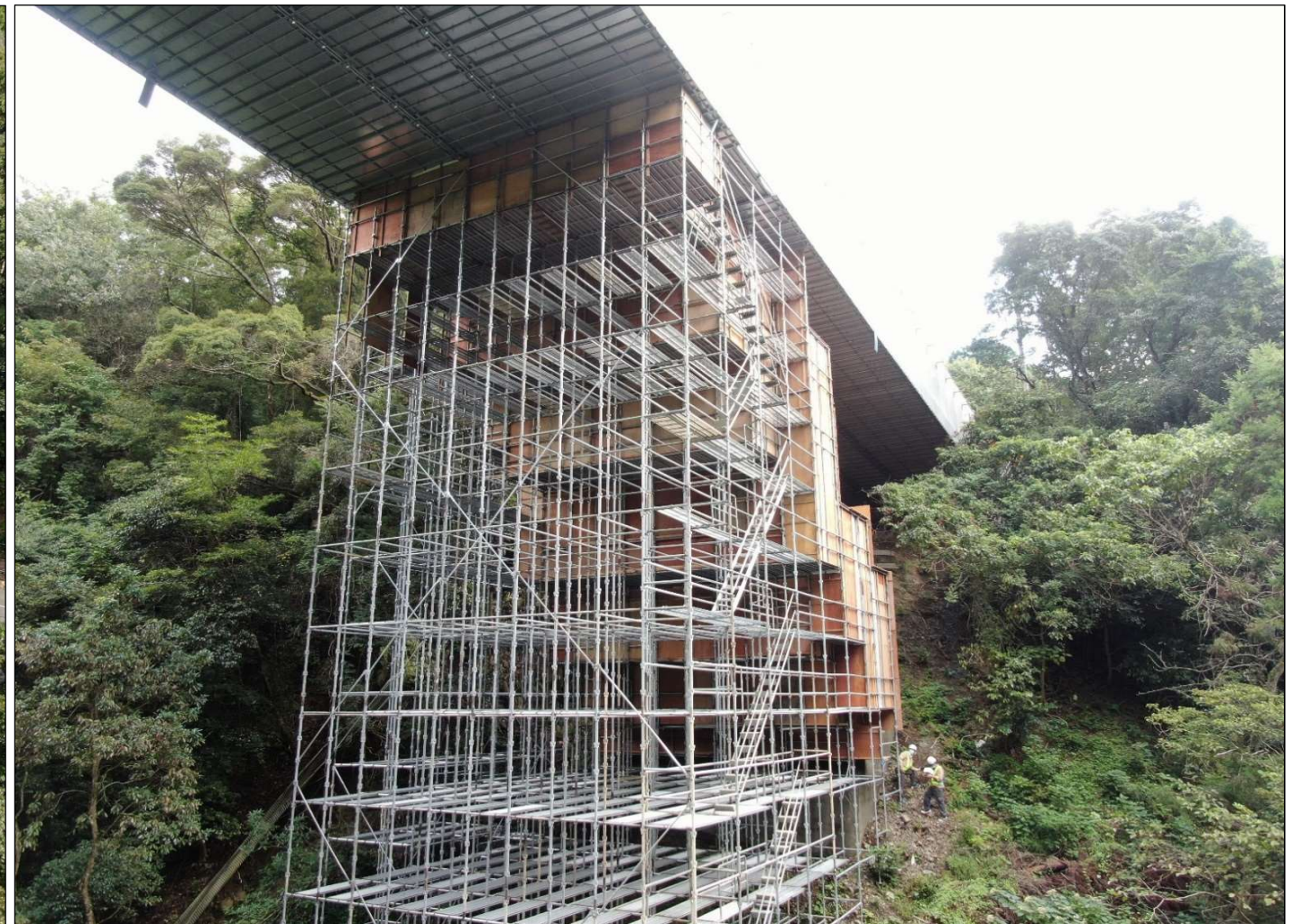
写-27. 足場近景(方杖部)
