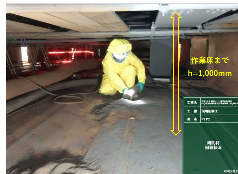
写-17. 桁下作業状況
