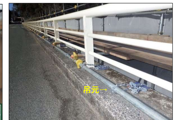
写-18. 高欄部吊元状況
