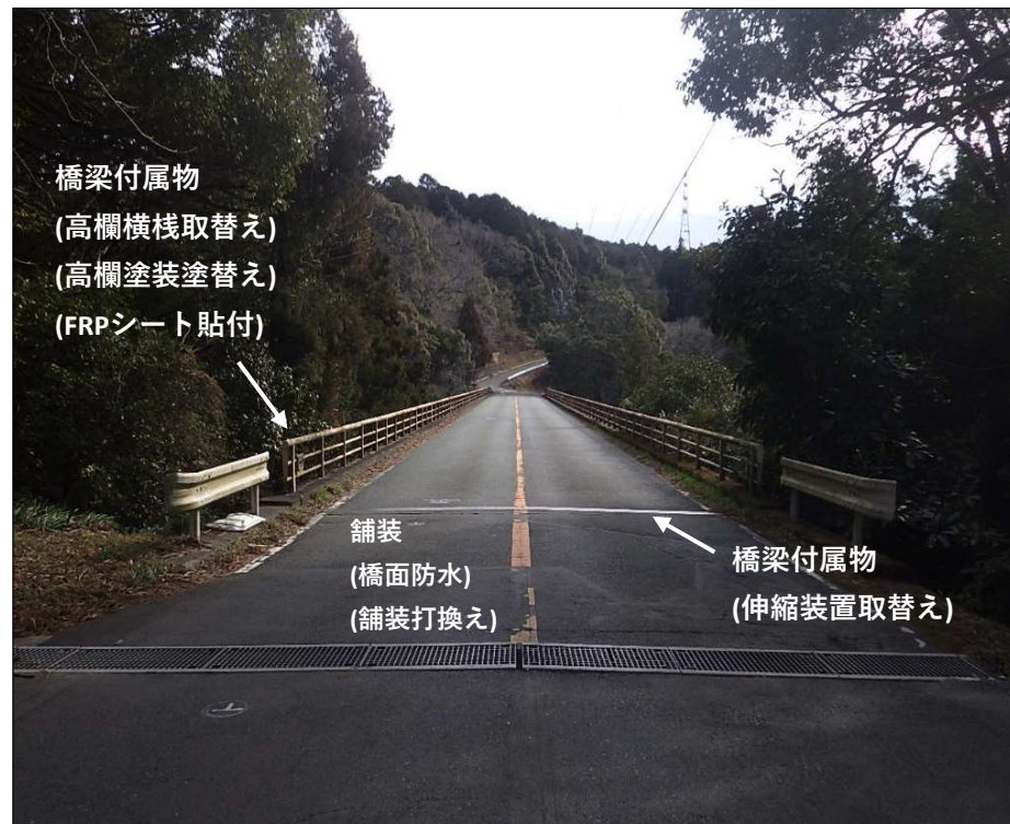
写-4. 橋梁上部における着手前
