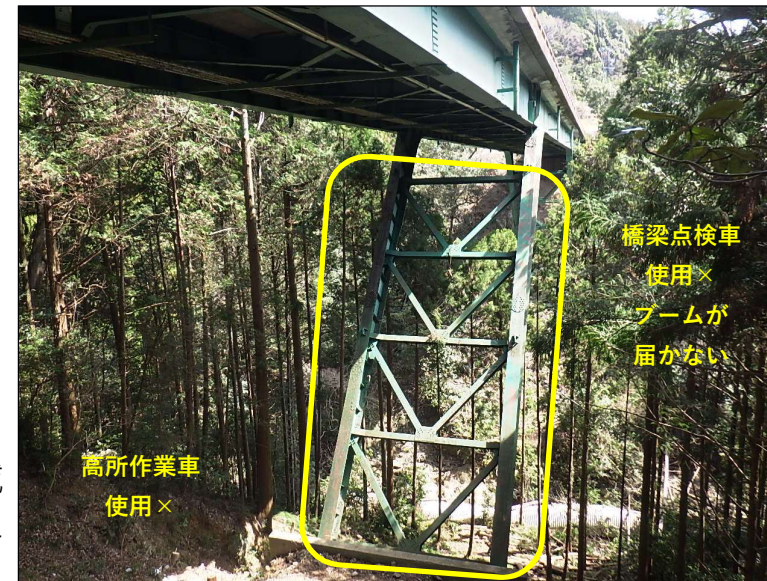
写-8. 方杖部現況
