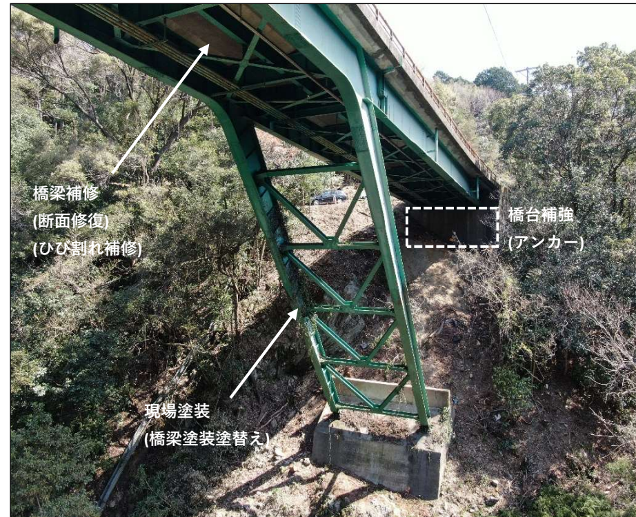
写-2. 橋梁下部における着手前
