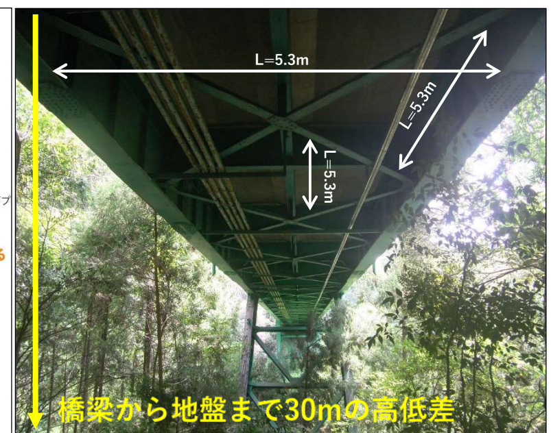
写-7. 床版下部現況
