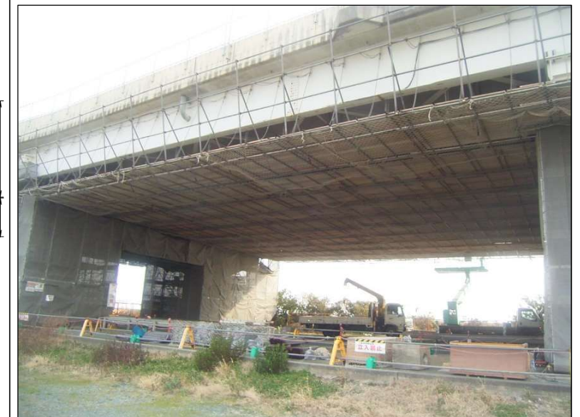
写-6. 【参考】在来工法による吊足場組立状況
