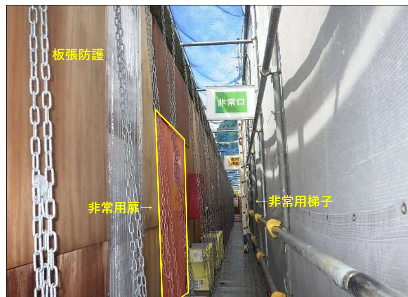
写-16. 塗替塗装時の避難通路
