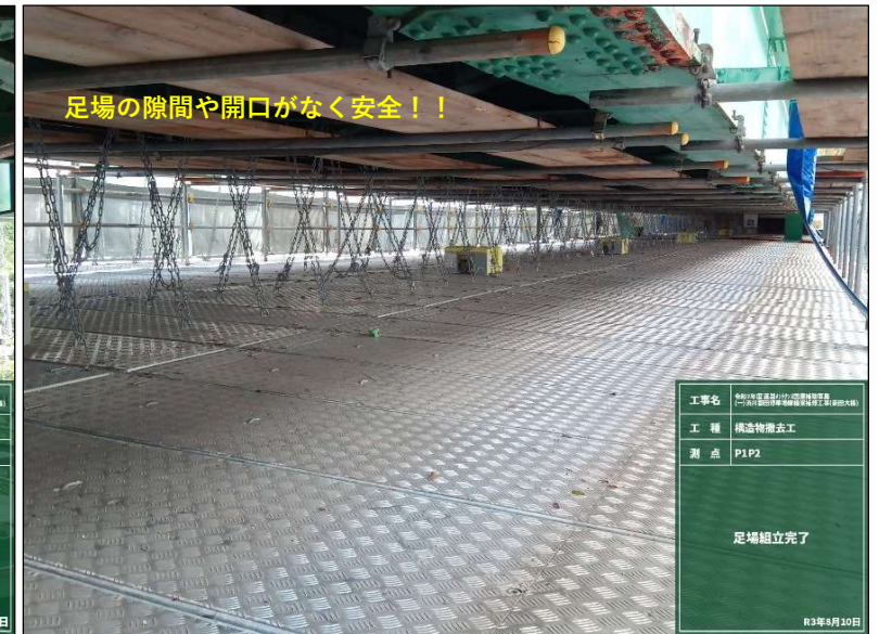
写-11. ①床版部足場組立完了
