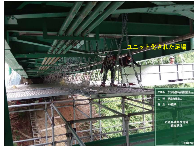
写-10. ①床版部足場組立状況
