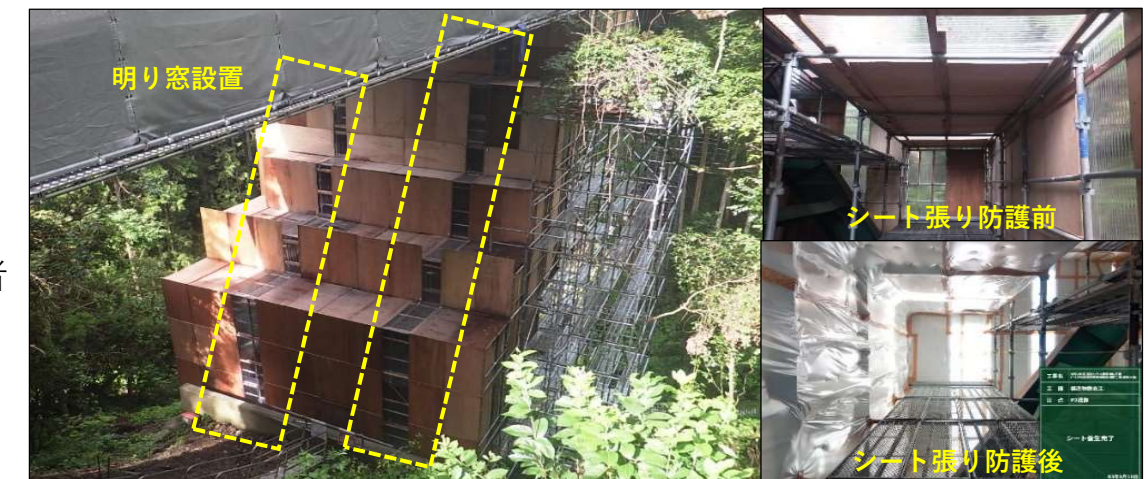
写-22. 板張り防護・シート張り防護(方杖部)
