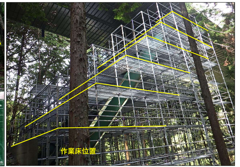
写-13. ②方杖部足場組立完了
