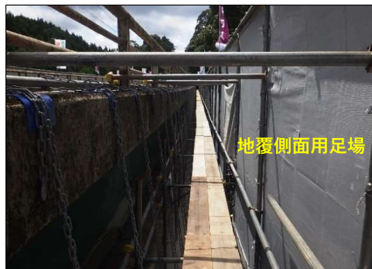
写-14. 地覆部補修足場(上段)
