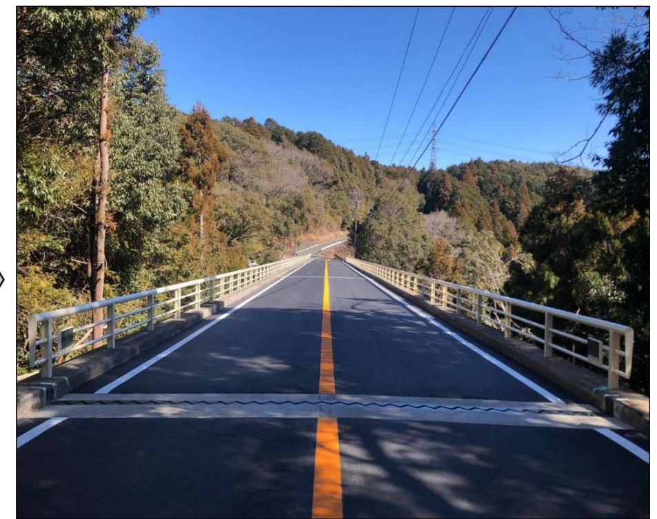
写-5. 橋梁上部における完成時
