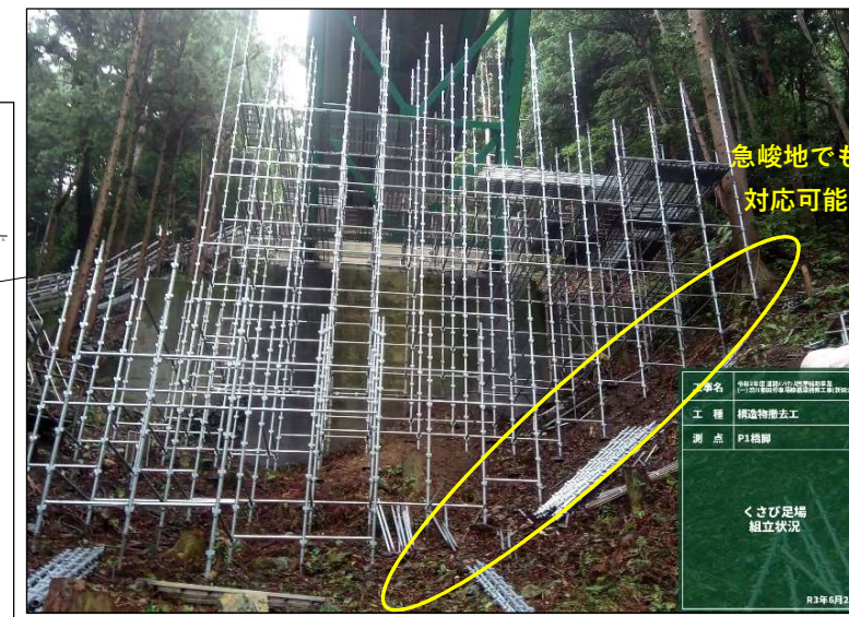
写-12. ②方杖部足場組立状況
