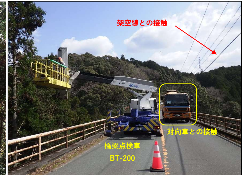
写-9. 橋面部現況
