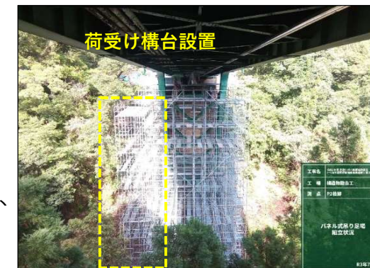
写-20. 足場組立時
