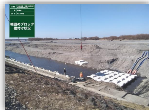
⑬ 根固め工
