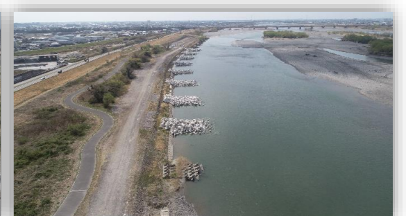
⑩ 別工事水制工完了(上流側~)
