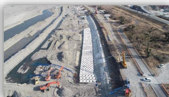
⑦ 護岸工 根固めブロック完了
