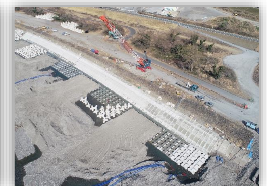
⑯ 法枠工完了
