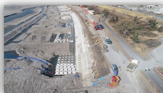
⑧ 護岸工 法枠工完了
