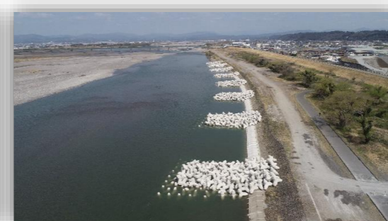
⑨ 別工事水制工完了(下流側~)
