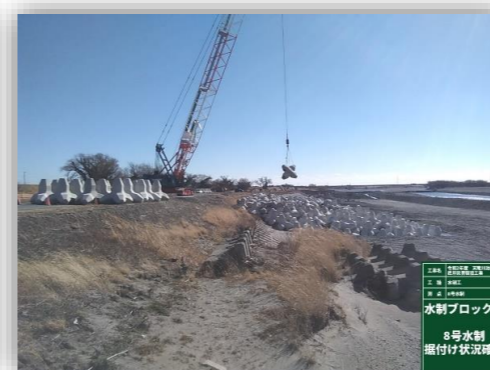
⑭ 水制ブロック据付
