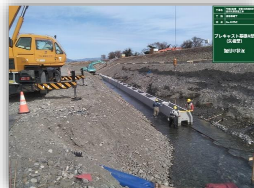
⑨ 護岸基礎工
