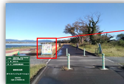
ボイスインフォメーション設置状況(遠景)
