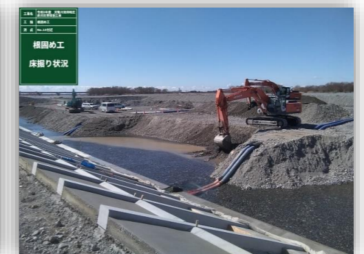
⑫ 床掘(根固め工)
