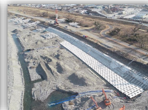
⑮ 根固め・水制ブロック据付完了
