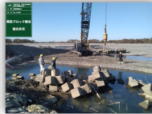
⑥ 既設ブロック撤去
