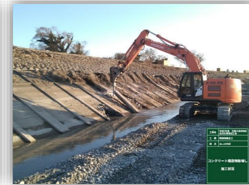
⑦ 構造物撤去工
