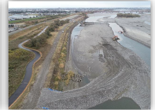
④ 仮締切工、仮設道路工
