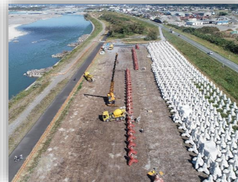
② 根固め、水制ブロック製作
