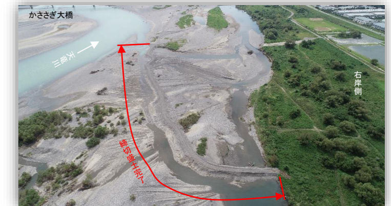
締切盛土 施工完了
