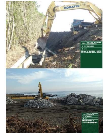
写真-7: 取壊し〜小割状況
