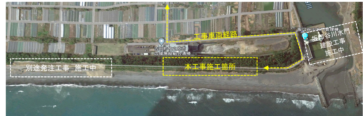
写真-4:施工箇所平面写真
