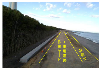
写真-5: 海側へ設置の工事用道路と土砂仮置
