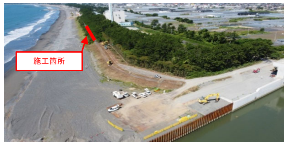
写真-1:坂口谷川右岸
