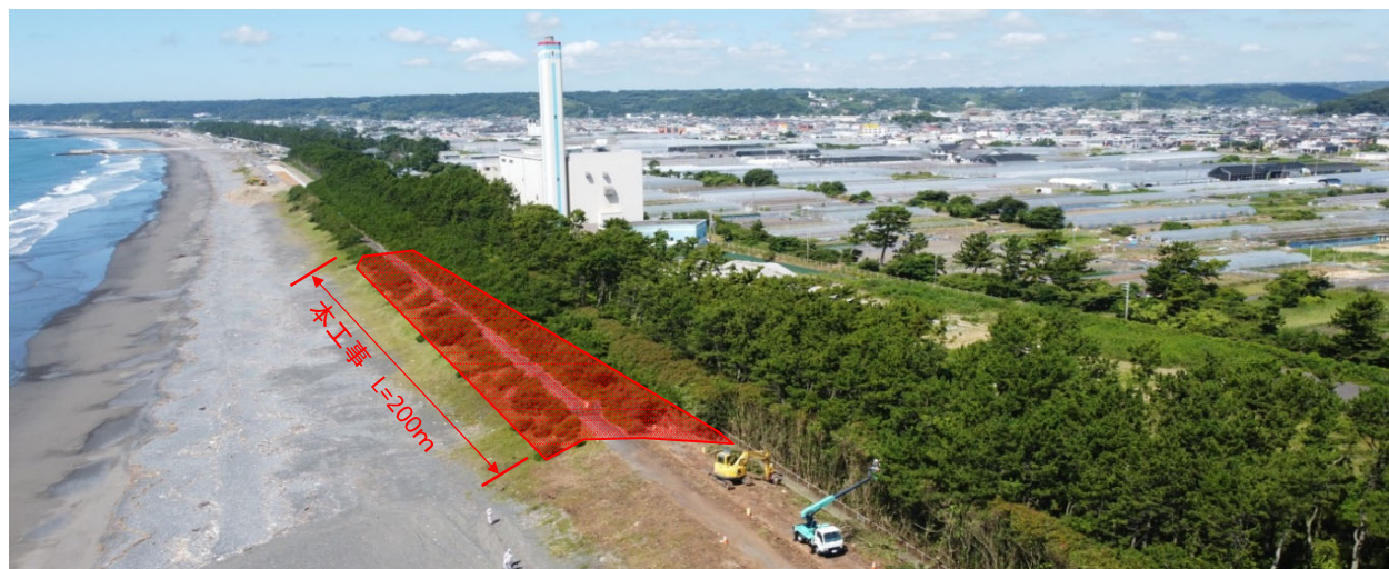
写真-3:施工箇所
