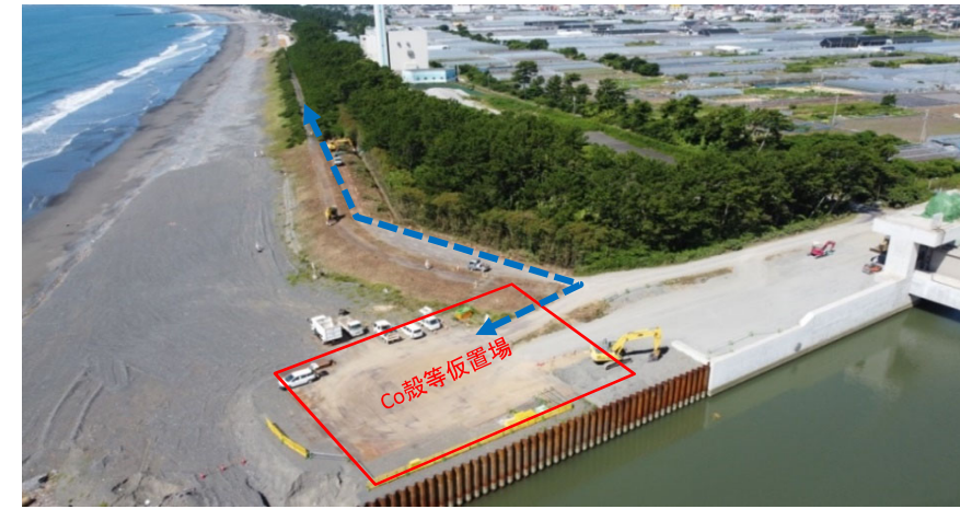
写真-6: Co殻等仮置場
