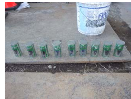
供試体を多く採取し、所定強度が得られる養生期間を確認
