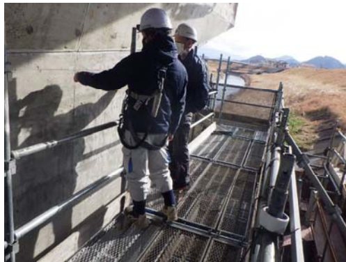
コンクリート診断士による確認
