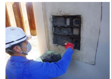
スルーサー部のポリマーセメントの充填
