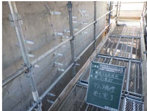
ひび割れ補修状況
