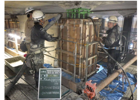
支柱コンクリート打設
