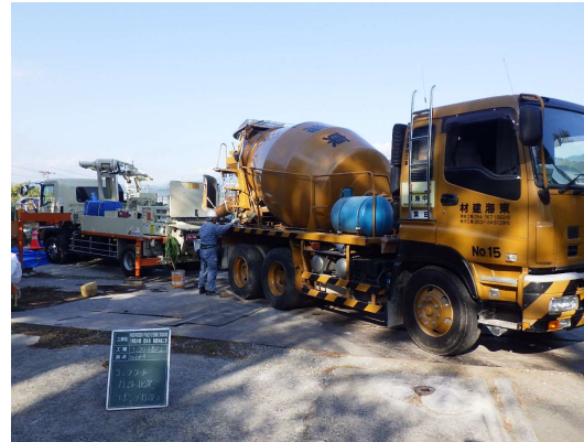
コンクリートポンプ車設置状況
