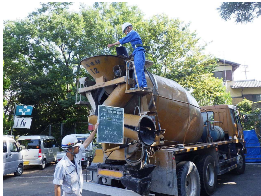
モアークリート投入状況
