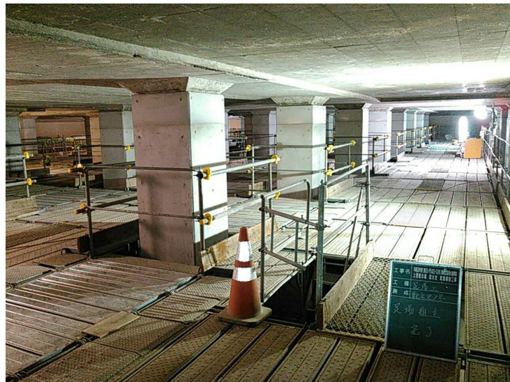
全面ステージ足場
