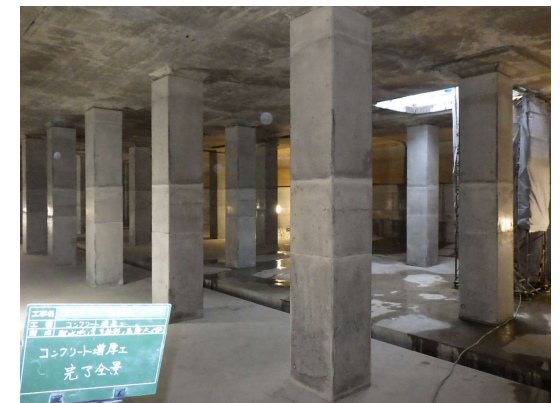
支柱コンクリート打設完了
