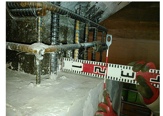
鉄筋かぶり確保の状況
