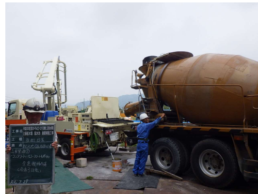
モアークリート撹拌状況
