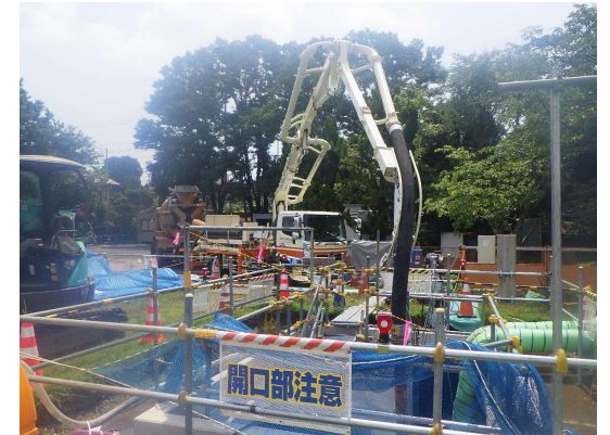
コンクリートポンプ車設置状況
