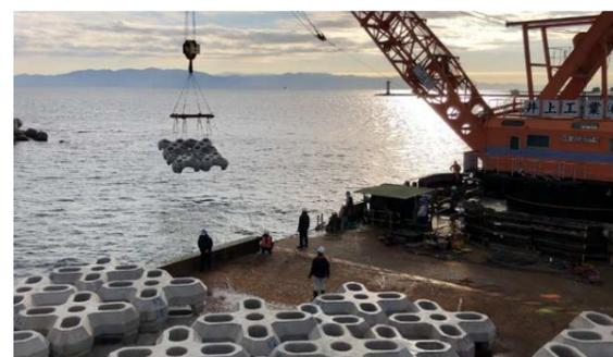
写真18 4個吊吊具による据付状況
