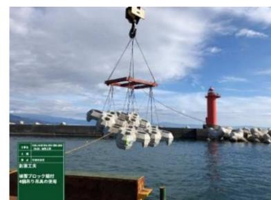
写真16 4個吊吊具使用状況
