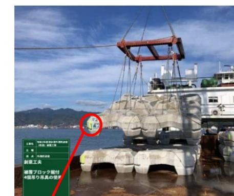
斜面部では、吊った際にその向き(上下)が水中でも容易に分かるよう、下側になるブロックの角を蛍光塗料で明示した。
