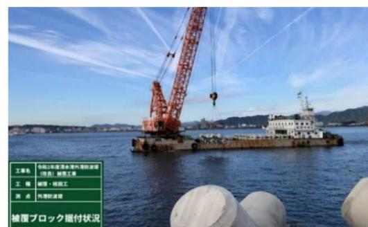
写真17 4個吊吊具による据付状況
