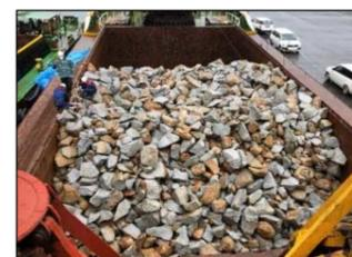
写真4 捨石の搬入検査状況
