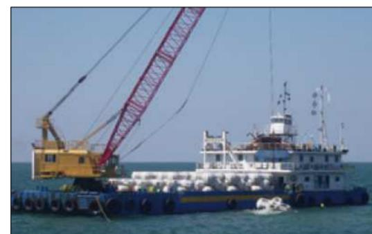
写真13 一般的な被覆ブロック(ペルメックス4t型)の据付状況(写真はブロックのカタログより抜粋)
