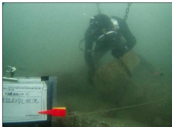
写真8 チェーンを使用した間詰石の移動状況
