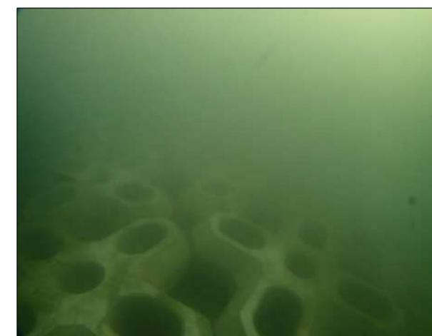
写真6 腐泥堆積部(法尻部分)の据付状況
