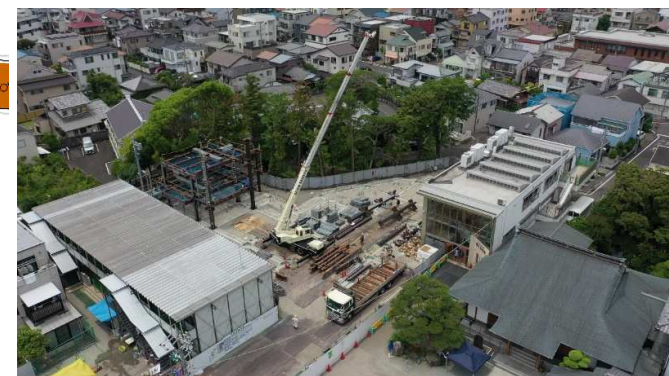
鉄骨建て方状況：材料搬入は早朝に行い、登園を終えた時間に出ていく計画としました。
