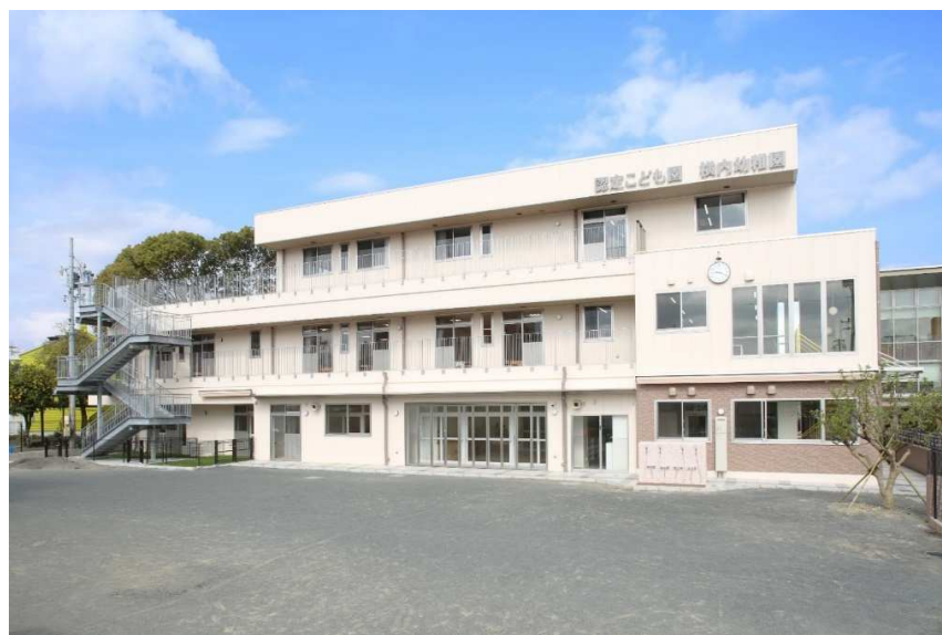
外観（南側園庭より）
