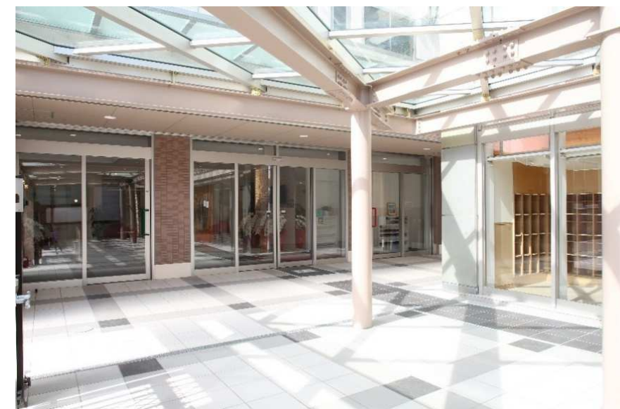
ガラス屋根（既設園舎と新園舎をつなぐ）
