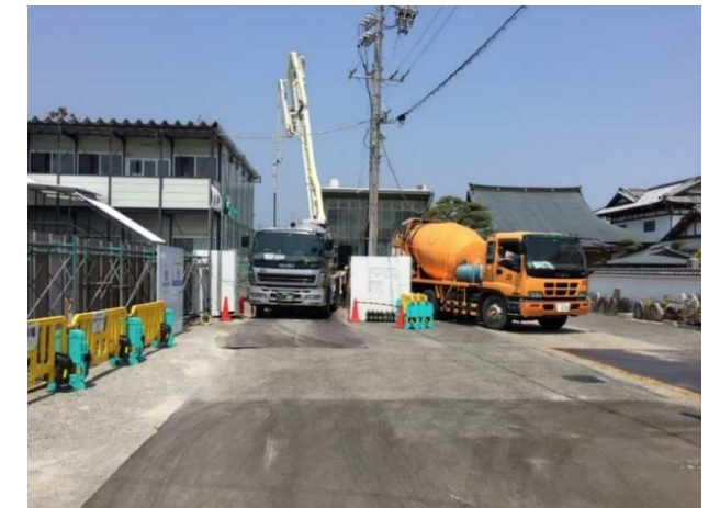
基礎コンクリート打設状況：ミキサー車駐車位置に引込電柱があるため、ゲートを2カ所設け、休園日のみ開門させ、2台付けを可能にしました。
