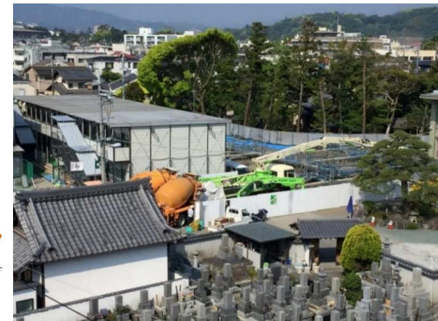
基礎コンクリート打設状況：ミキサー車駐車位置に引込電柱があるため、ゲートを2カ所設け、休園日のみ開門させ、2台付けを可能にしました。
