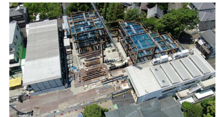
鉄骨建て方状況：材料搬入は早朝に行い、登園を終えた時間に出ていく計画としました。
