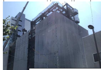
鉄骨施工時飛散対策(垂直ネット)
