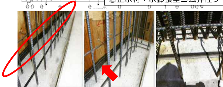
②止水材：水膨張型ゴム弾性シール材
