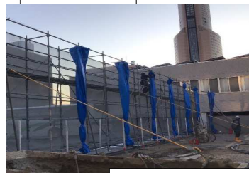
SMW施工時飛散対策(南側)
