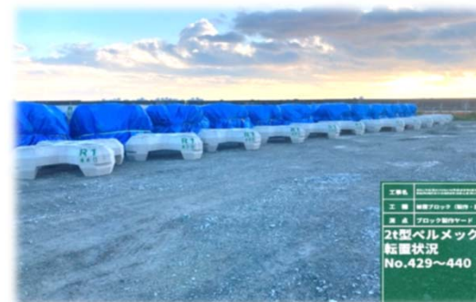
2t型被覆ブロック製作
