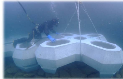
被覆ブロック据付
