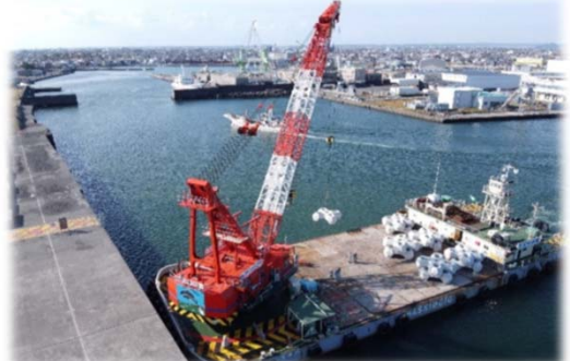
被覆ブロック据付
