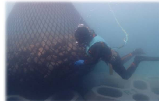
12t型袋詰玉石据付
