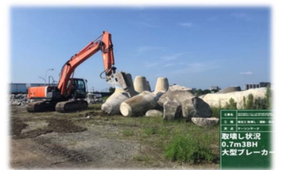
撤去ブロック破碎
