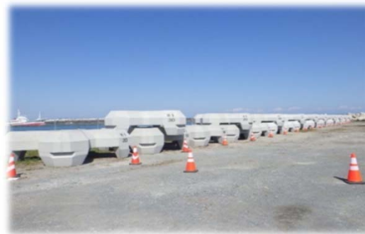
16t型被覆ブロック製作
