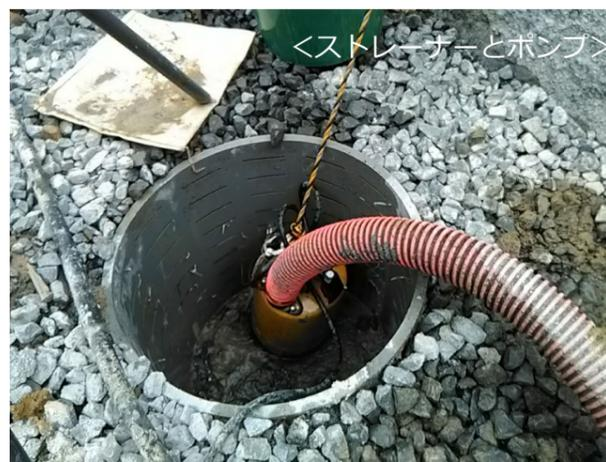
このストレーナーは線状のスリットが上向きに設けられおり、スリットに泥水が取り込まれる際、比重の大きい土粒子は下へ落ち、水分のみが内部に取り込まれる仕組みをイメージして作成した。
