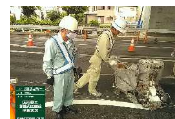
㉔区画線工
