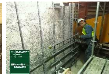
⑫鉄筋組立
