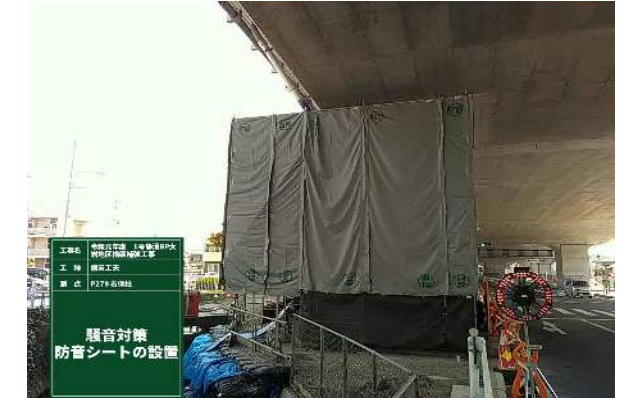
写真14 防音シートの設置
