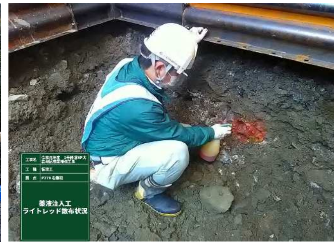
写真5 注入材浸透確認（色素判別法）
