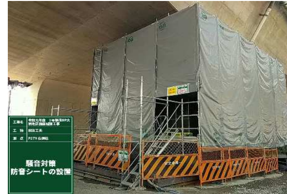
写真13 防音シートの設置
