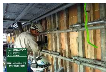
⑭コンクリート打設
