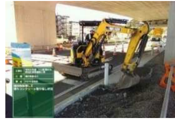
②構造物撤去工
