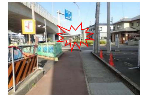
写真15 仮設通路の設置
