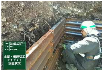
⑦ライナープレート設置
