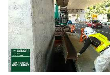
⑰補強リング撤去
