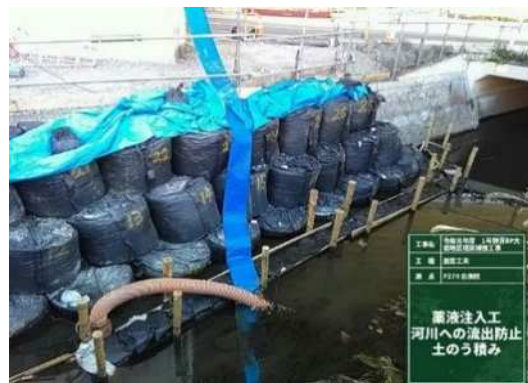
写真12 仮締切・水中ポンプ設置
