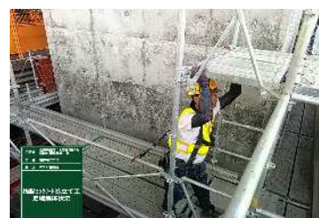
⑮足場解体
