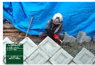
⑲ブロック積工
