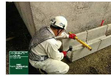
⑳排水構造物工
