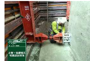
⑨切梁設置
