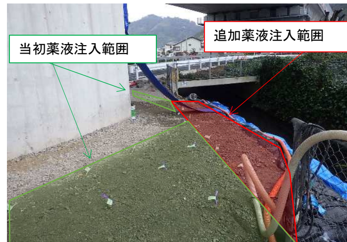
写真4 薬液注入 変更範囲
