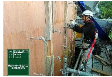
⑬型枠組立
