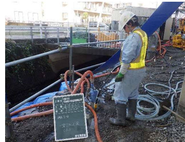
写真6 河川部1次注入（瞬結材）状況
