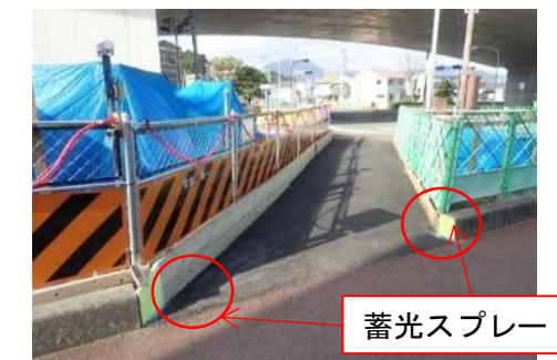
写真16 蓄光スプレーの塗布
