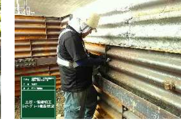
⑱ライナープレート撤去
