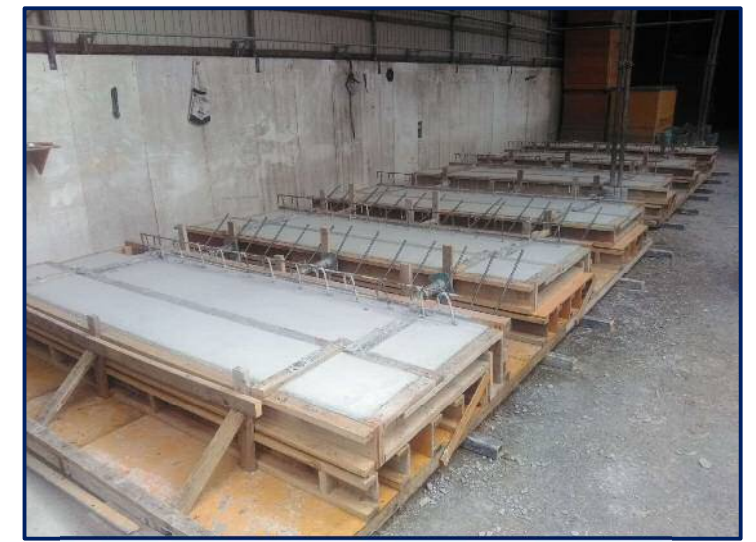
【 サイトPC板 養生状況 】
