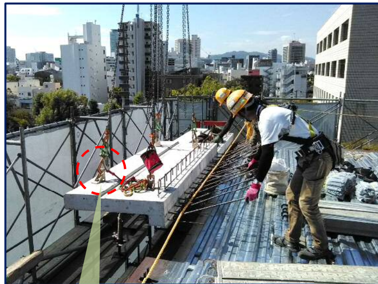
【 PC板 据付状況 】
