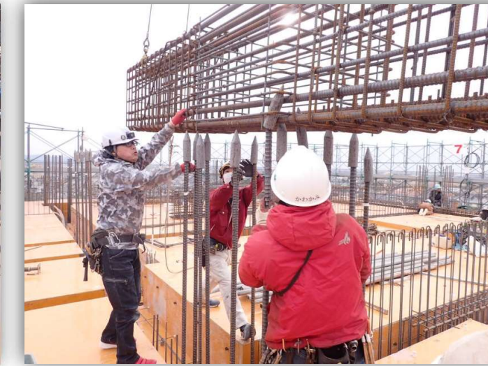
↑ 鉄筋組立材設置状況
