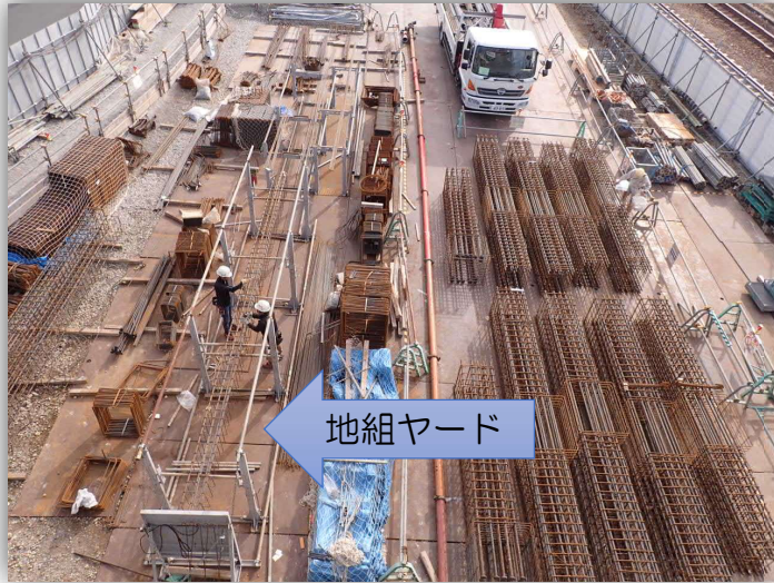
↑ 鉄筋組立加工場状況
