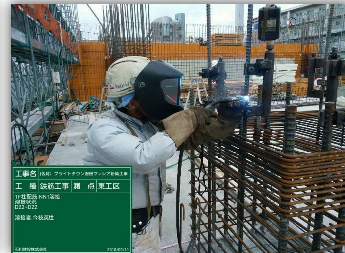
↑ 鉄筋柱継手溶接状況
