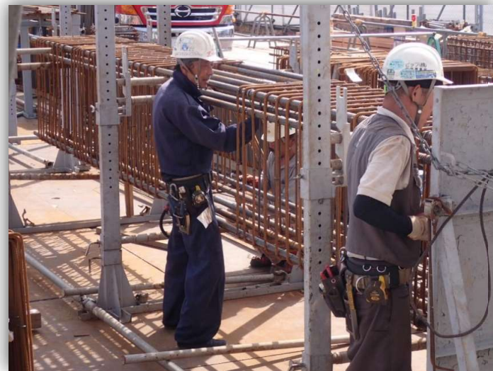
↑ 鉄筋組立加工場状況
