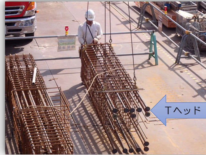
↑ 鉄筋組立材吊荷状況
