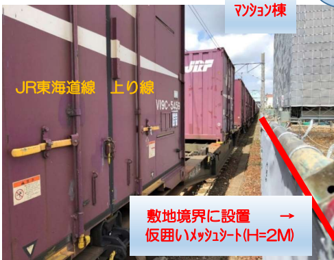
↑ 地上付近での線路近接状況
