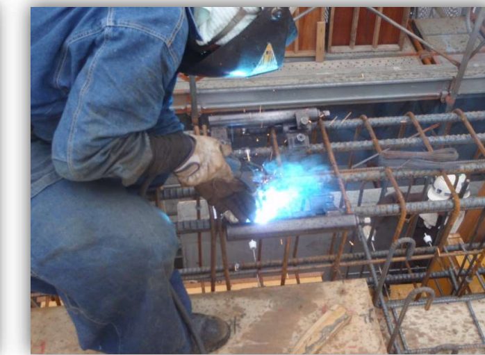
↑ 鉄筋梁継手溶接完了状況
