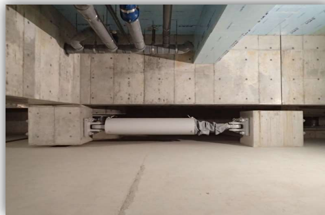
↑ オイルダンパー設置状況
