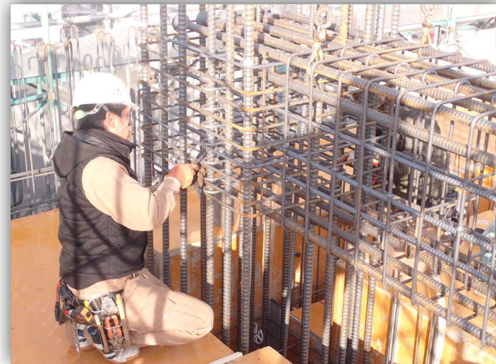
↑ 鉄筋組立材設置状況
