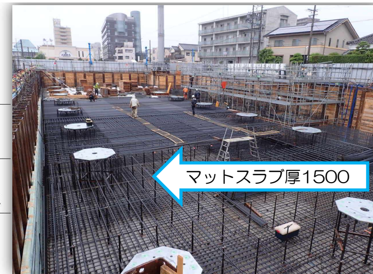
基礎マットスラブ（厚1500）配筋・免震装置アウター設置状況
