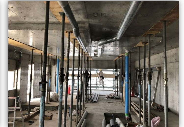
↑ 次工程作業状況
