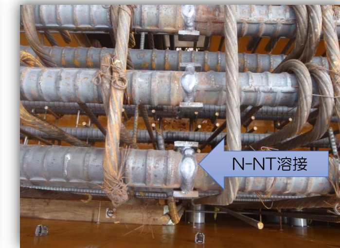
↑ 鉄筋梁継手溶接完了状況
