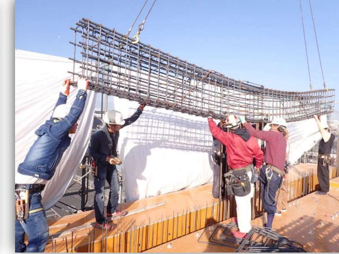
↑ 鉄筋組立材設置状況
