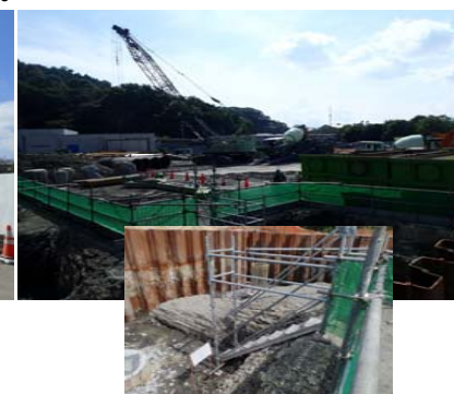
流動的な掘削工事中における安全対策(手摺の設置)
