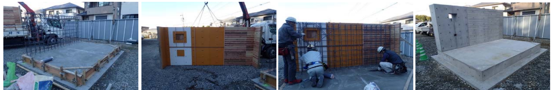
①ベース躯体・鉄筋組立完
