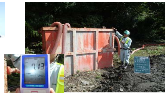
ノッチタンク内PH測定
