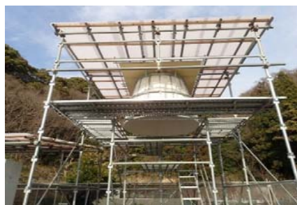
天井ボード組立 (モックアップ)
