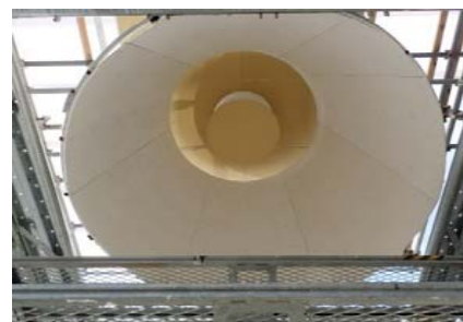
天井ボード組立 (モックアップ)
