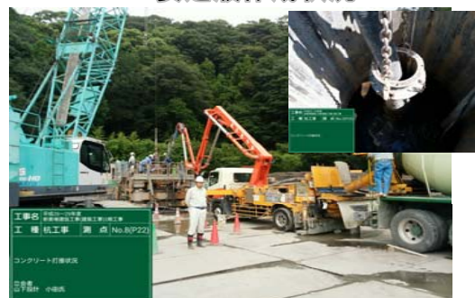
コンクリート打設状況
