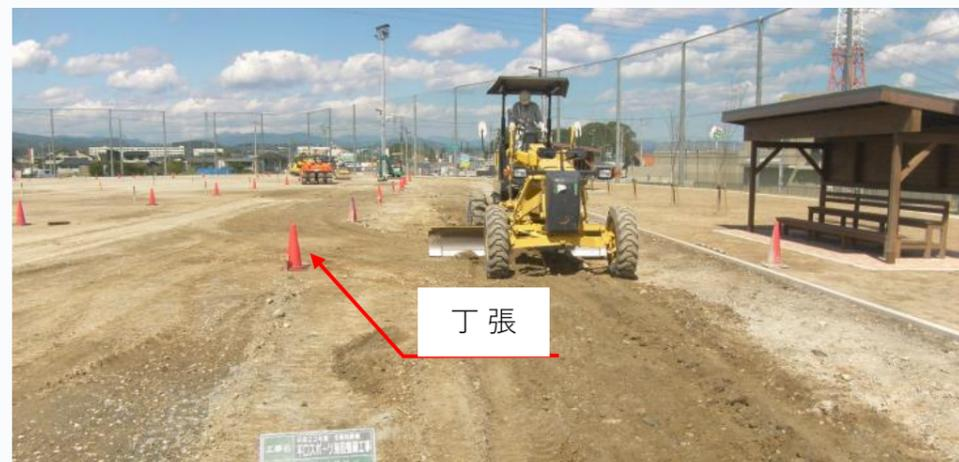
↑8年前同じグラウンドを施工している様子丁張が多数設置されており、苦勞して施工している様子がわかる
