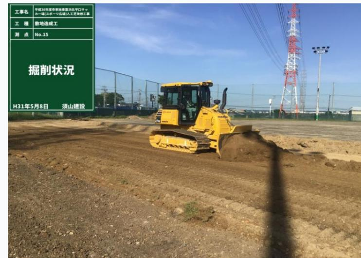
↑今回の施工では、丁張を一切設けずスマートな施工が実現。ブルドーザーのブレードは自動制御されているため、オペレーターは機械を前後させるだけで綺麗なグラウンドが仕上がる
