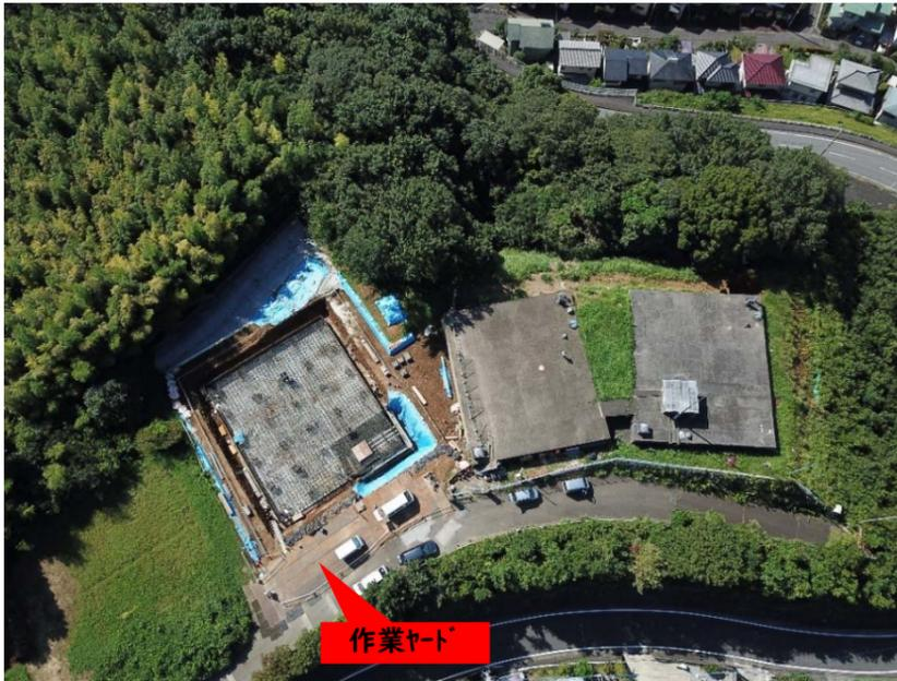
⑥課題 マスコンクリートによる温度ひび割れ発生が懸念された。(配水池基礎打設量 V=520m3/回)
