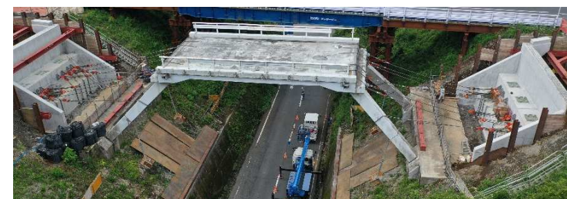
2-3.仮吊材設置完了
