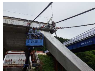
2-2.仮吊材取付 (中央径間)
