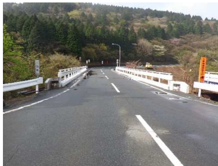
着手前（起点側）
