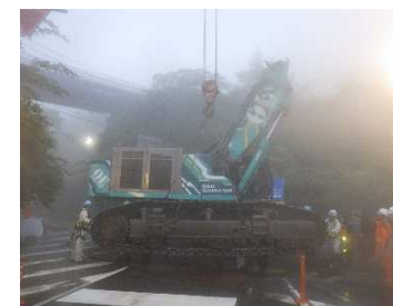
4-1.重機組立状況1
