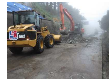
4-5.仮設撤去、片付
