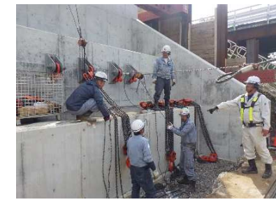
2-1.仮吊材取付 (橋台)
