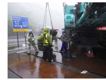
4-2.重機組立状況2
