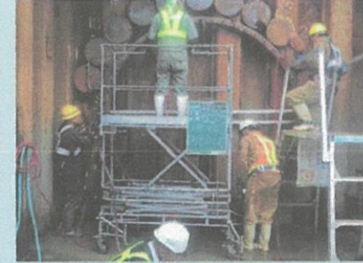
⑭到達坑口鏡切断
