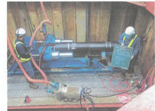
写真-6 Φ300鋼管推進状況
