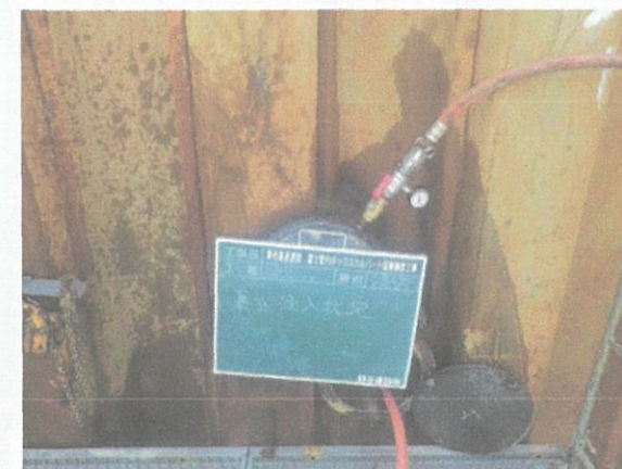
写真-7 遅効性滑材注入状況
