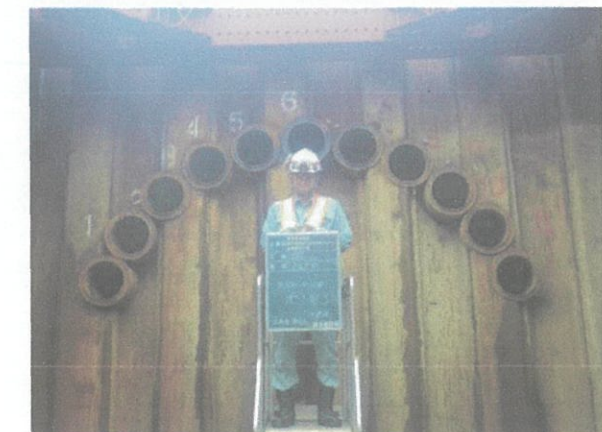
写真-8 パイプルーフ施工完了
