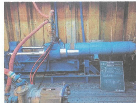
写真-5 先導体推進状況
