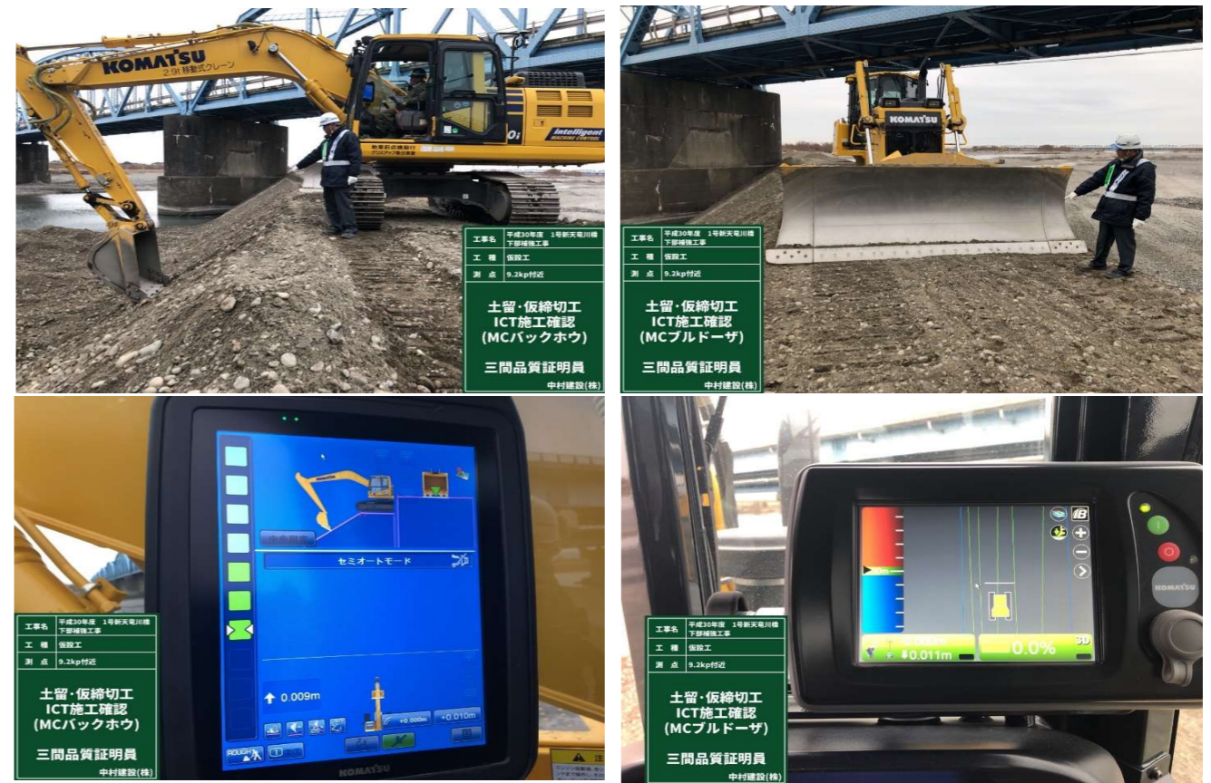
写真-7 MCバックホウ施工状況
