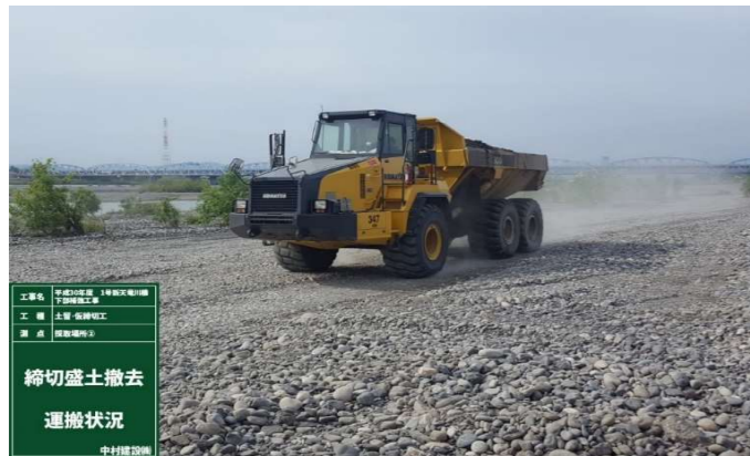
写真-9 アーキュリーダンプ運搬状況
