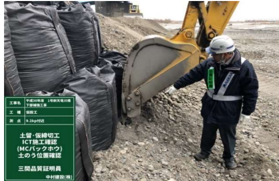
写真-12 土のう位置確認
