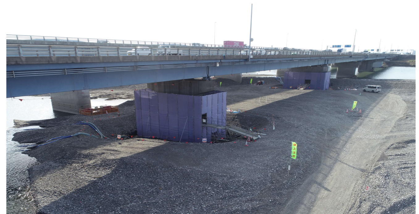
写真-11 施工状況写真
