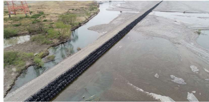
写真-13 大型土のう設置完了
