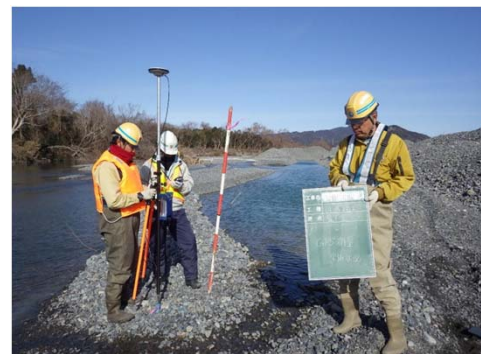
GPSによる延長管理 (施工範囲が広範囲のため)
