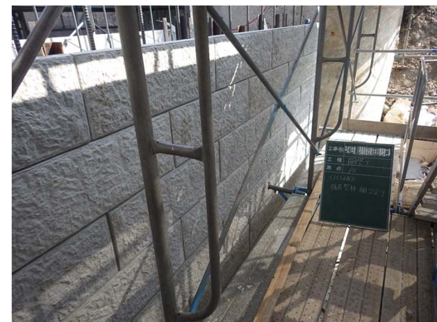
残存型枠組立状況
