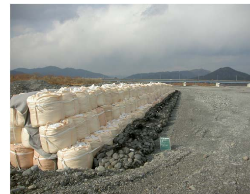
据付及び連結完了 全景
