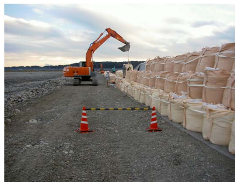
大型土のう設置状況
