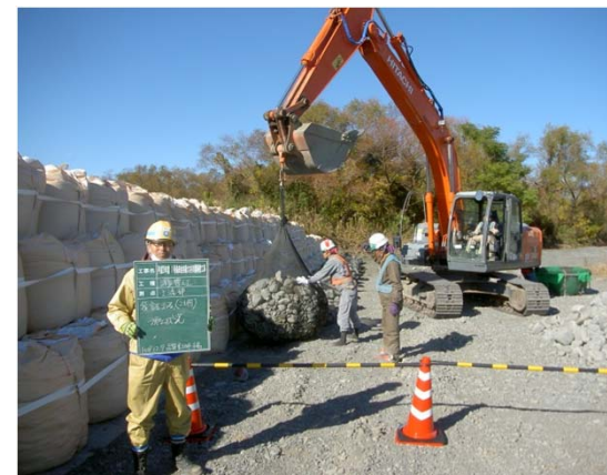
袋詰玉石(2t)据付状況
