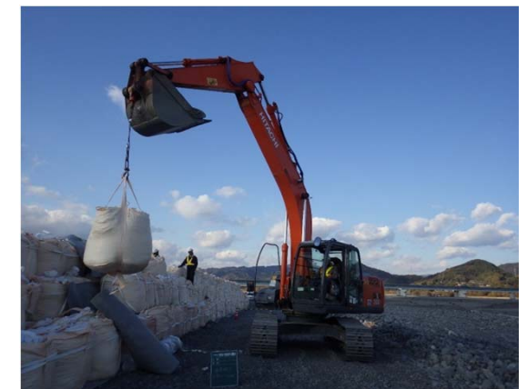
大型土のう(1t)据付状況
