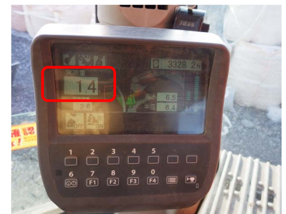
大型土のう(1t)の重量確認
