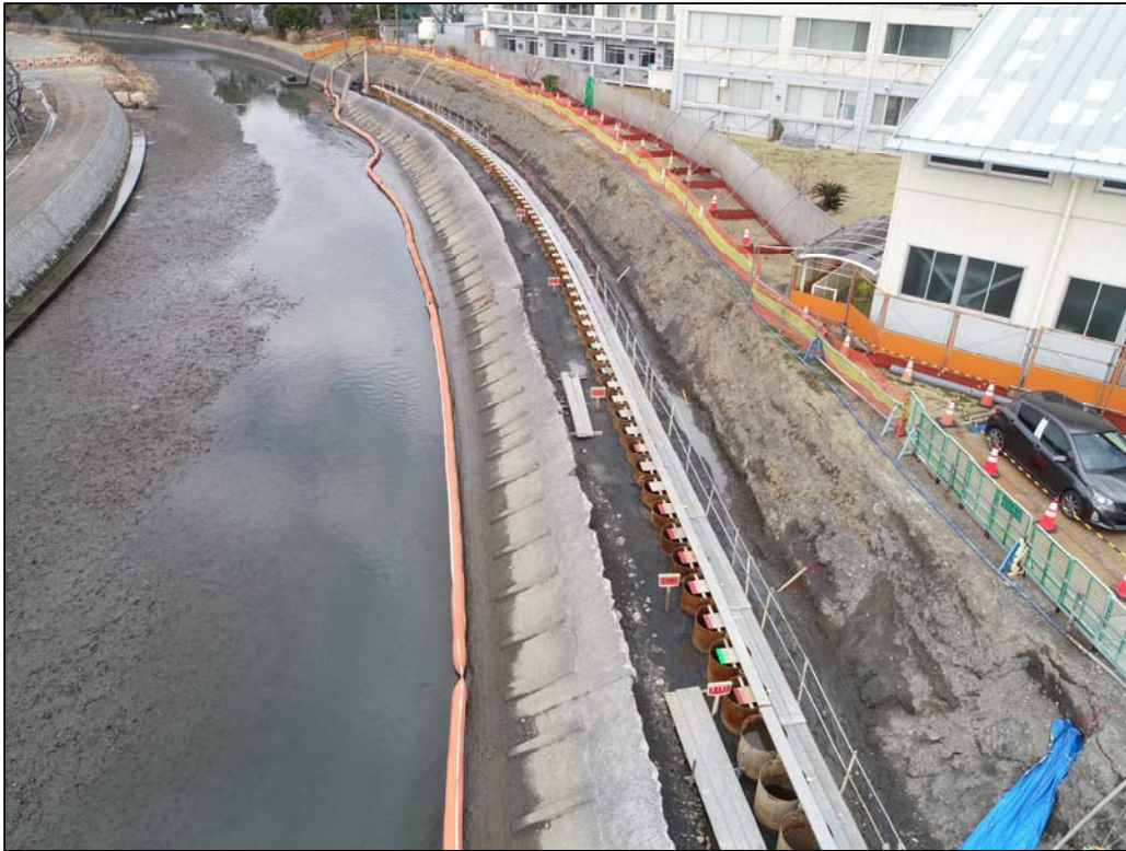
施工完了全景（鋼管杭φ800）
