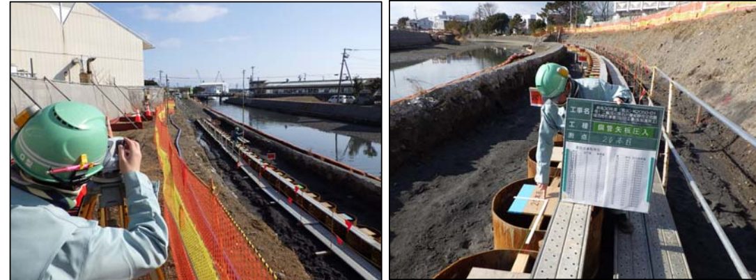
出来形管理（鋼管杭φ800）全数管理
