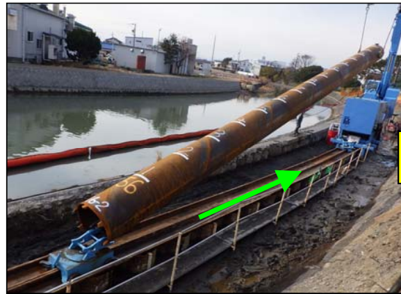
写真1 レール（鋼矢板）に沿ってスライドする。
