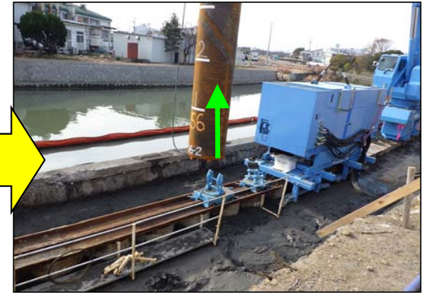
写真2 クレーンジブ直下で安全に吊り揚げ作業
