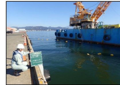
水中BHによる施工状況 構造物撤去状況
