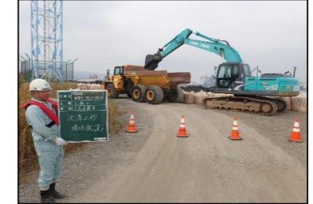
土砂等積込状況
