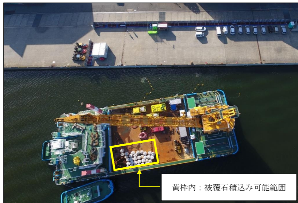
水中BH台船上艀装時の被覆石積み込み可能範囲
