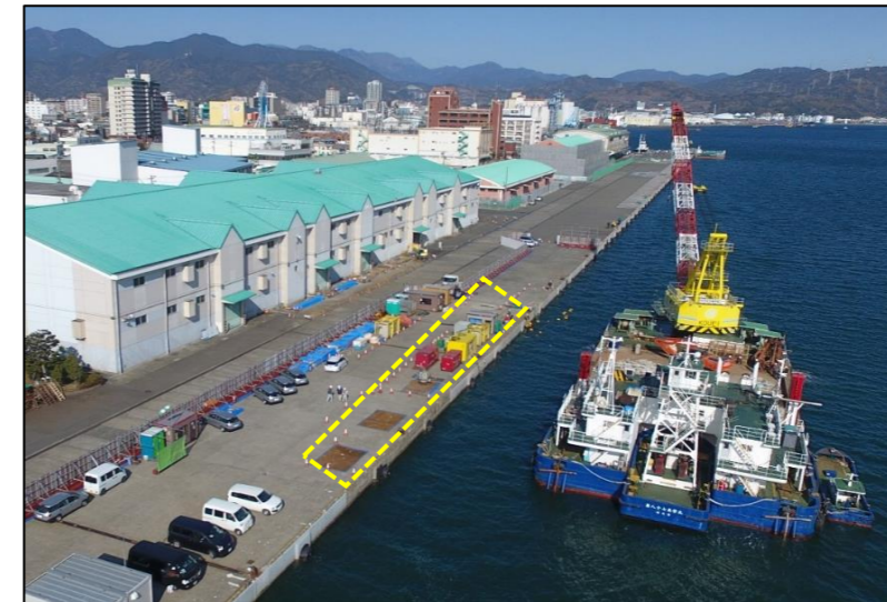
岸壁上への水中バックホウ艀装状況
