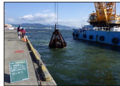
被覆石① 投入状況(左)、均し状況(右)
