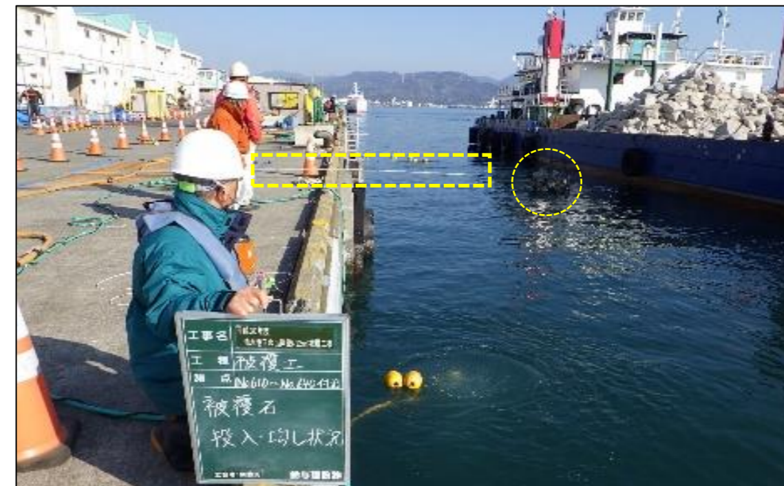
スタッフを利用したワイヤモック荷下ろし箇所の明示
