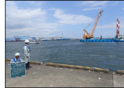
土運船運搬状況
