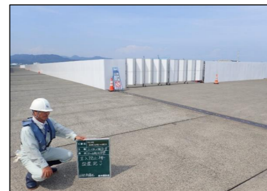
立入防止柵設置状況
