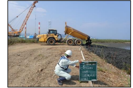
土砂等運搬状況
