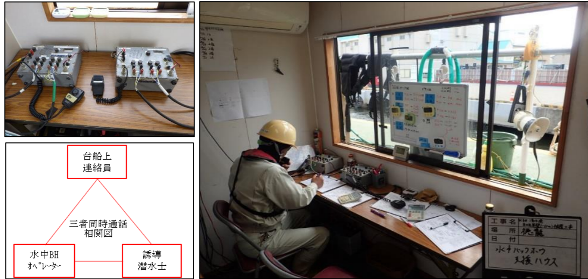
水中電話と三者同時通話相關図(左)と水中バックホウ支援室(陸上連絡員詰所)
