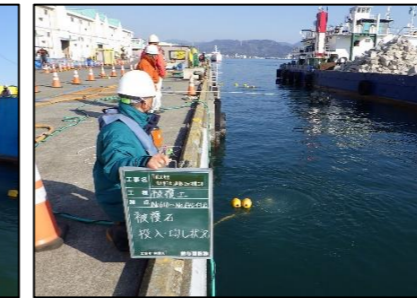
被覆石②、③投入均し状況
