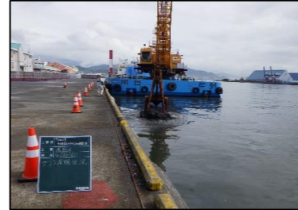
浚渫・床掘状況
