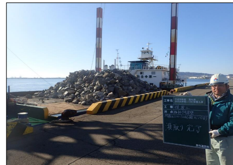
台船上への被覆石積み込み状況
