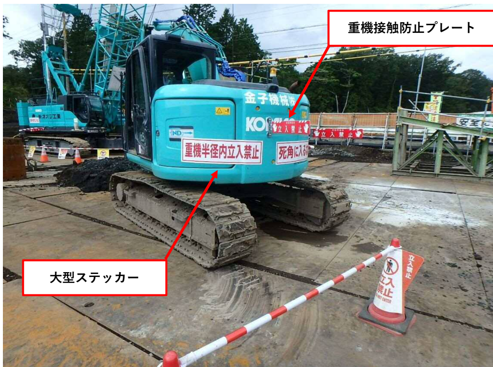
重機立入禁止処置の明確化
