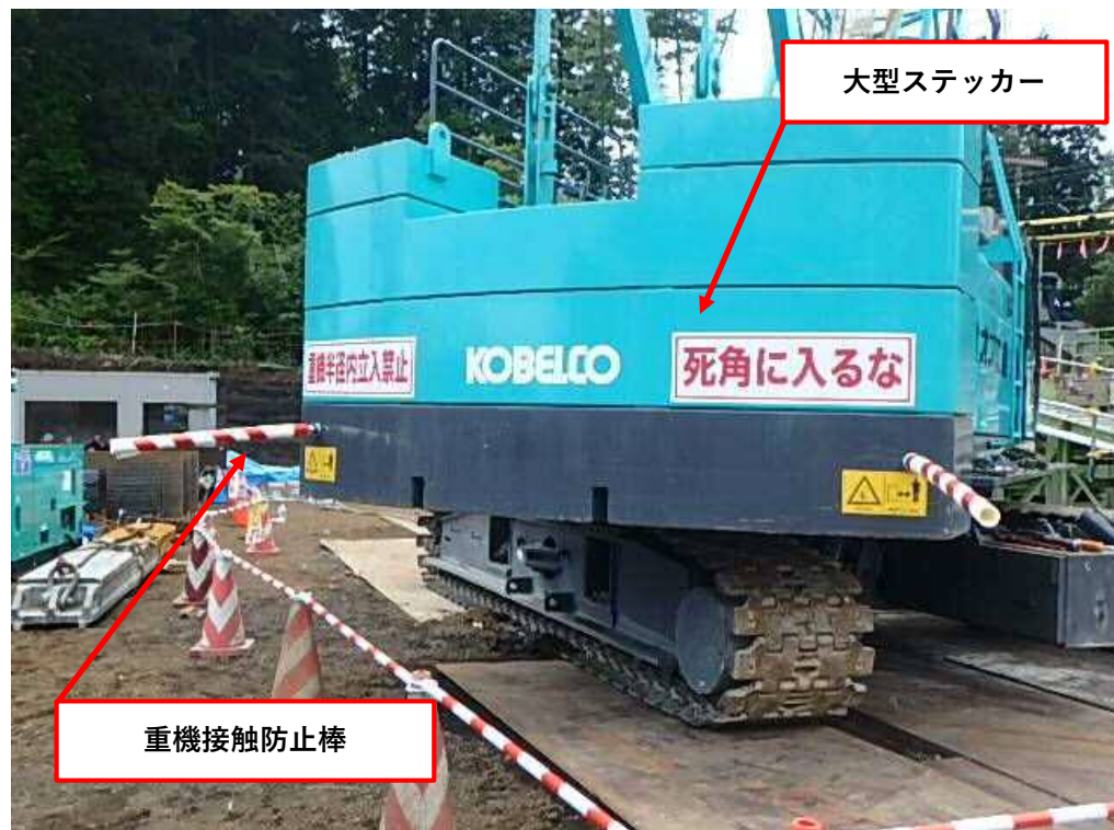
重機立入禁止処置の明確化
