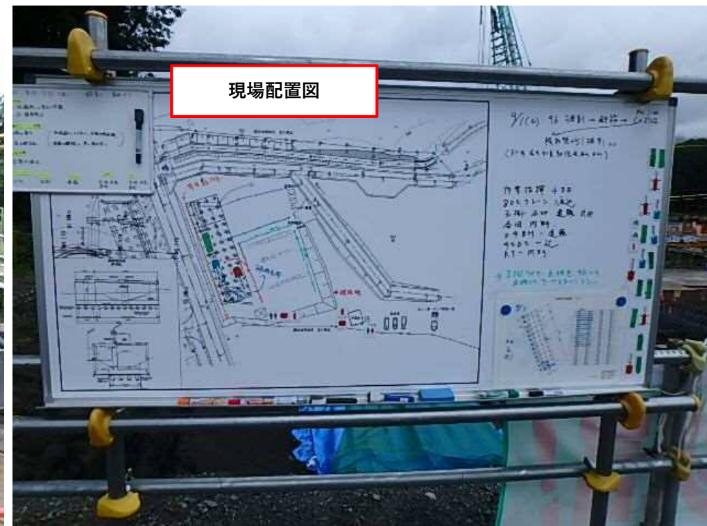
ホワイトボードを活用したTBM
