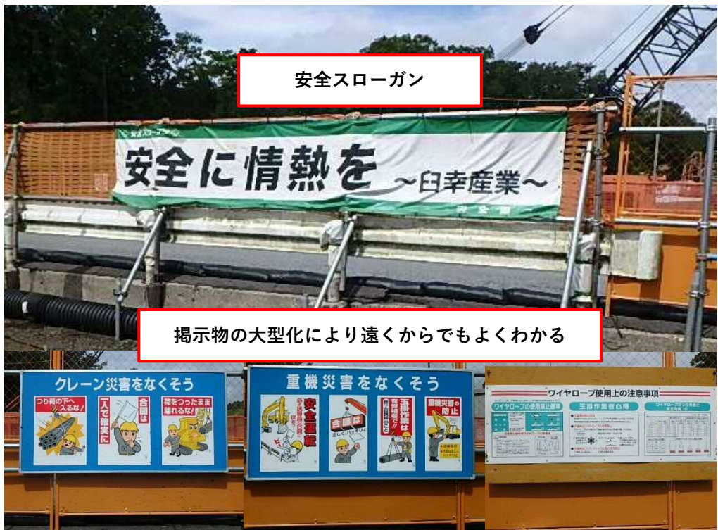
現場掲示物による安全意識の向上
