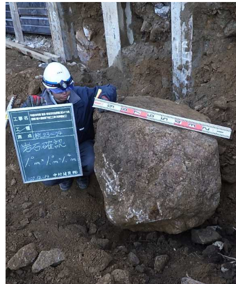
写真-2 巨石確認
