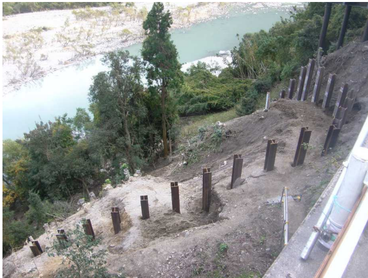
写真-1 土留親杭完了(H鋼の谷側が掘削範囲)
