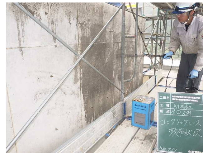
写真-10 被膜養生材
