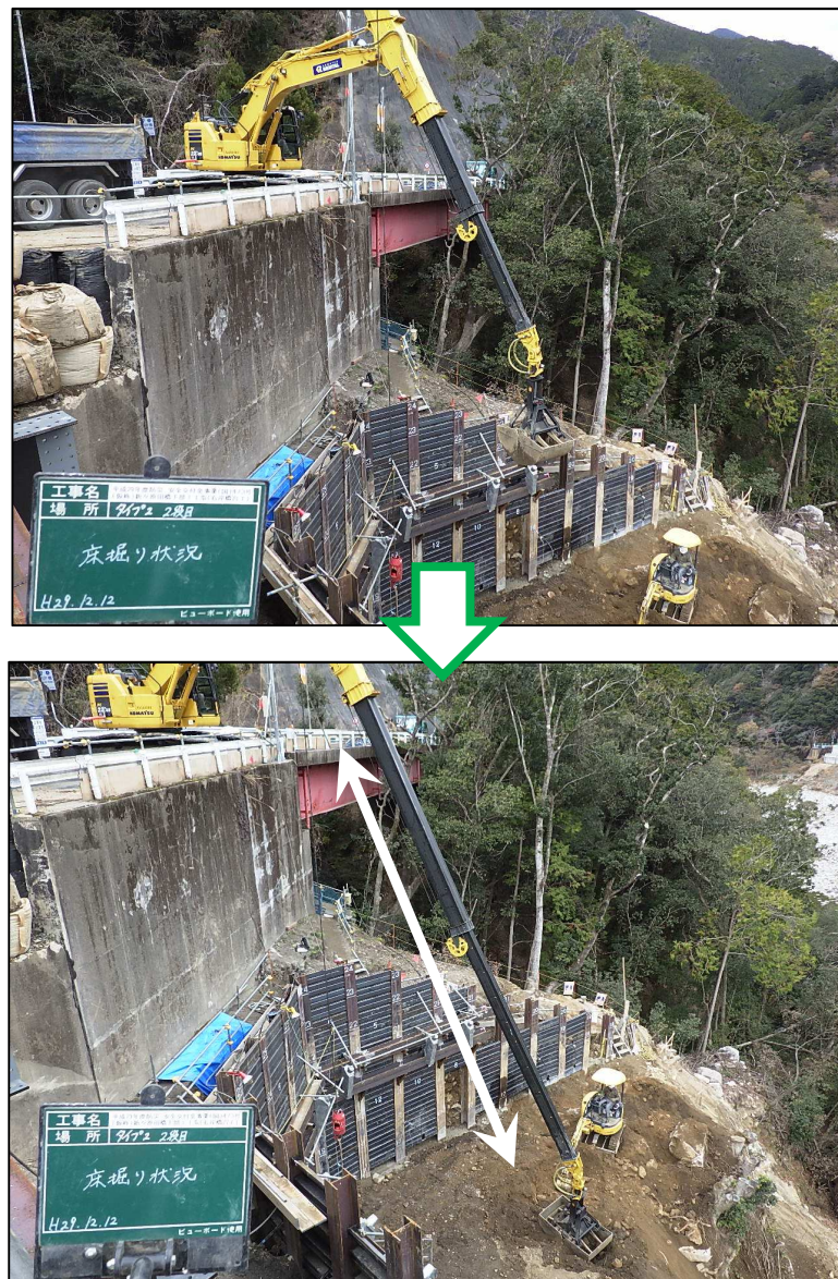
写真-4 スライドアーム式クラムシェル型バックホウ
