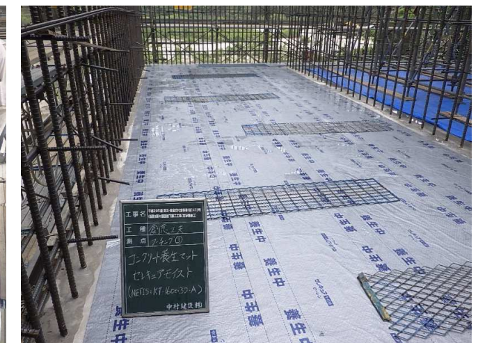
写真-11 二重養生マット
