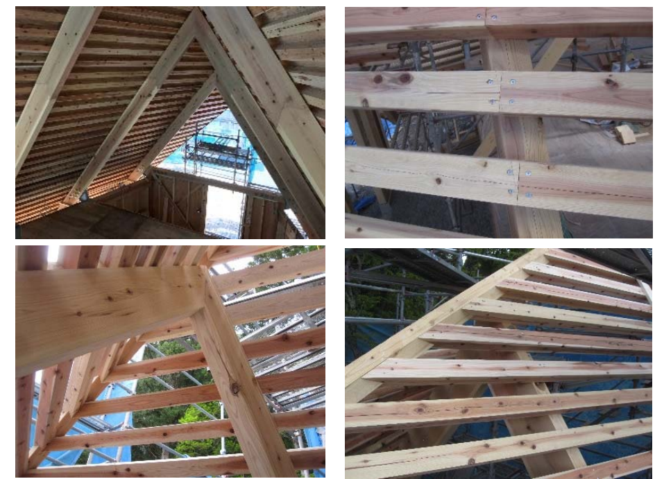
現場での実際の納まり。スケッチアップのイメージが再現された。垂木と棟の取付けは大工手加工。
