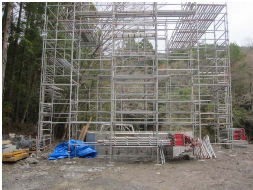
木建方時の足場全景。
