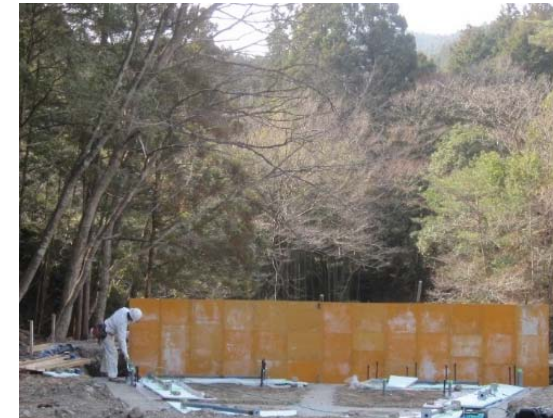
①型枠設置
