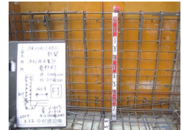
②鉄筋工事
