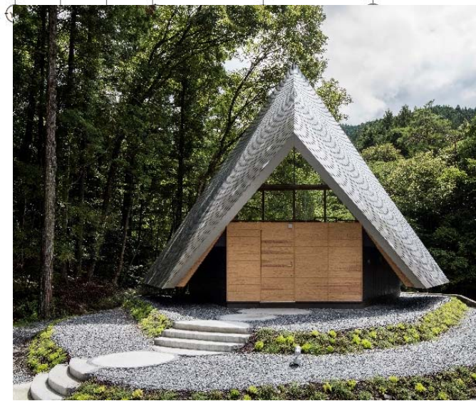
庭越しに建物を見る。天竜杉材張りの玄関正面。
