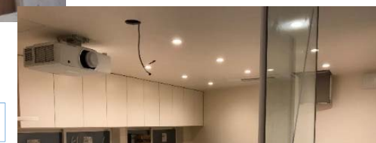
天井の仕上がり
