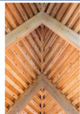
野地板と破風の施工後状況(室内側から)
