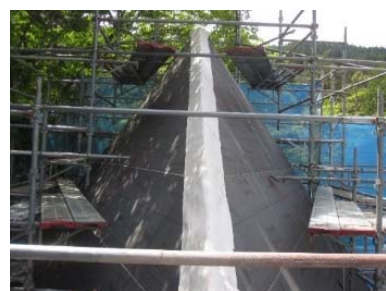
屋根まわりの持ち出し足場設置状況。
