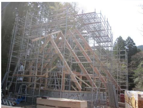
合掌梁の施工状況
