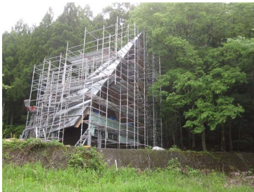
屋根工事時の足場、木建て時より複雑となっている。
