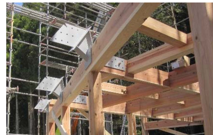
ジョイント金物施工状況と、合掌梁とのボルト接合施工状況。
