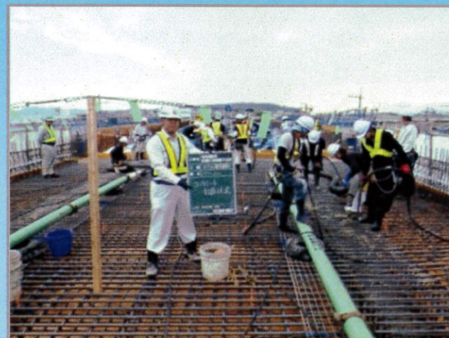
（写真-7 打設状況）
