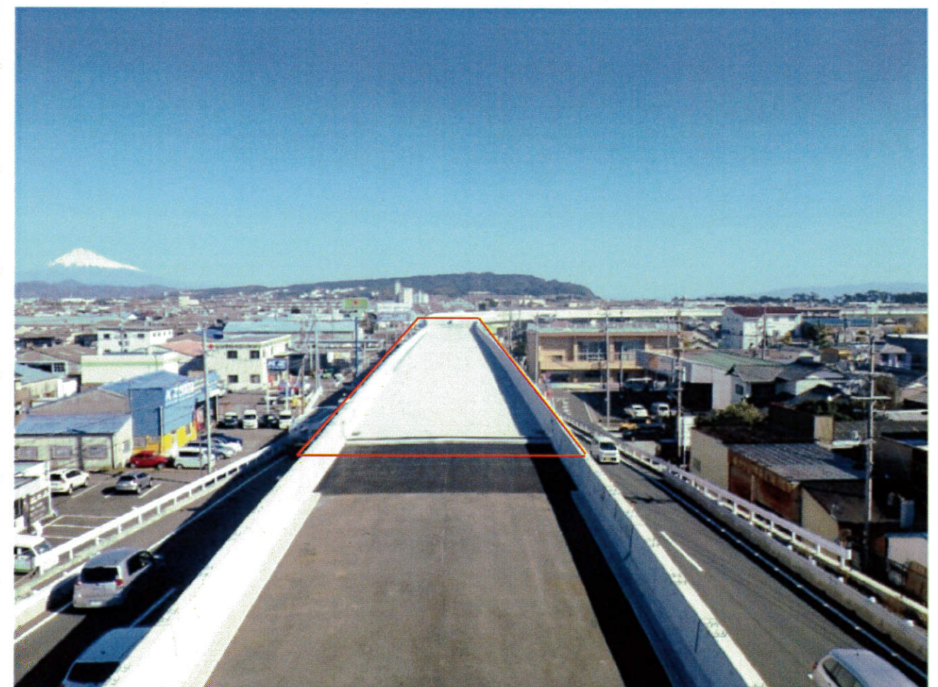
(写真-15完成・終点側)
