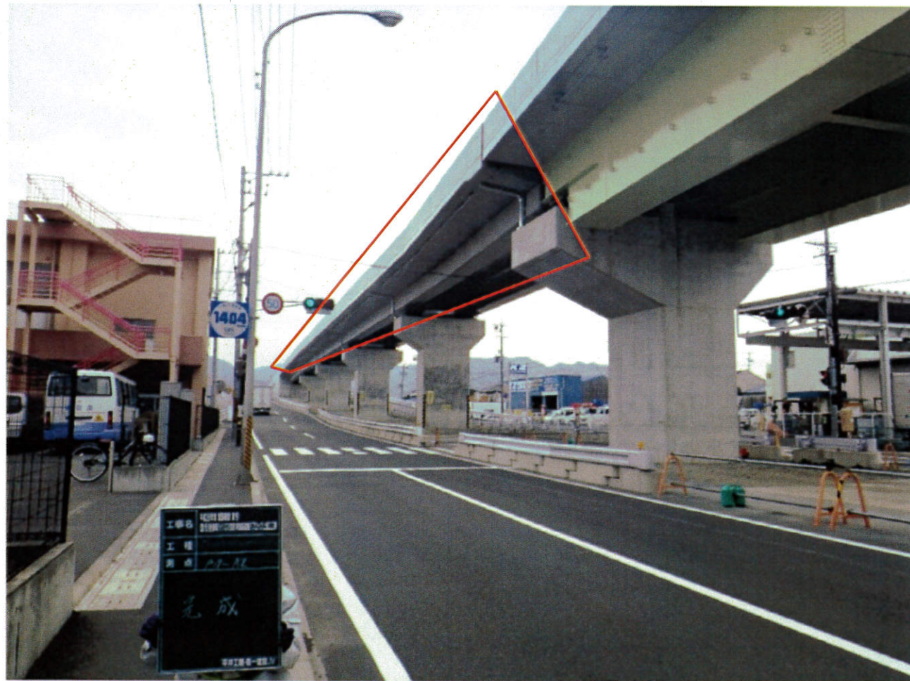
(写真-14完成・起点側)
