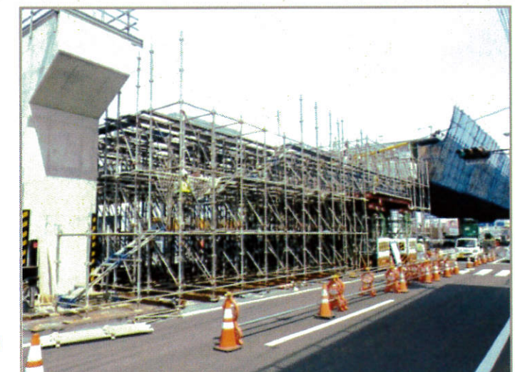
（写真-3 くさび支保工施工状況）
