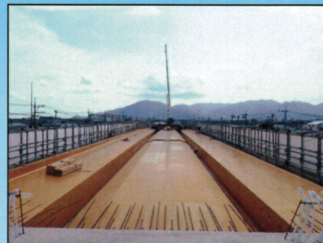
⑤型枠工組立
