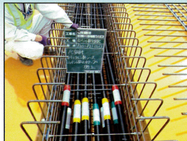
⑥PCケーブル工設置
