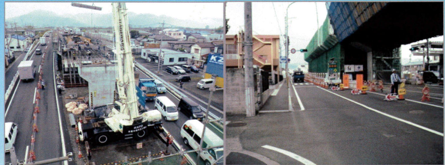
(写真-13 車線減少規制状況)
