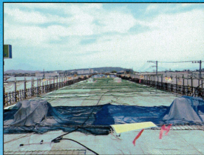
⑨コンクリート工養生
