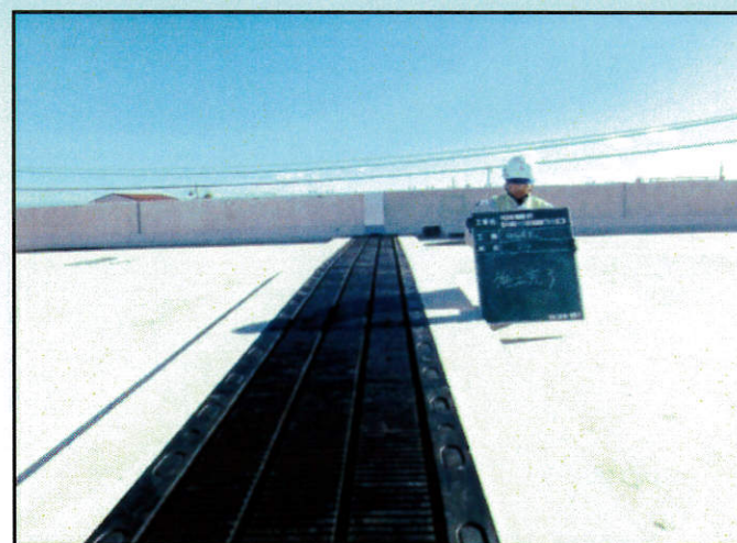
⑭伸縮装置工
