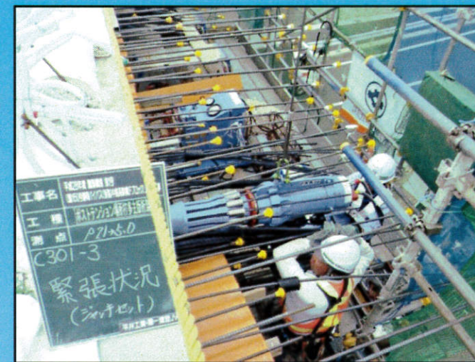
⑩PC鋼線緊張工
