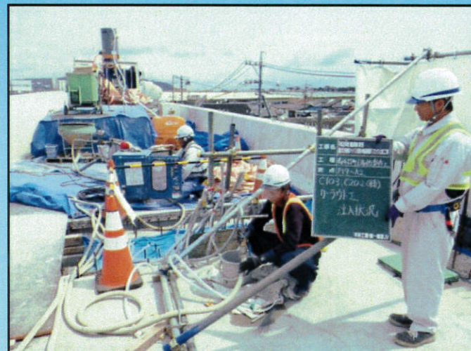
⑪PC鋼線グラウト注入
