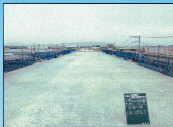
⑫コンクリート工打設完了
