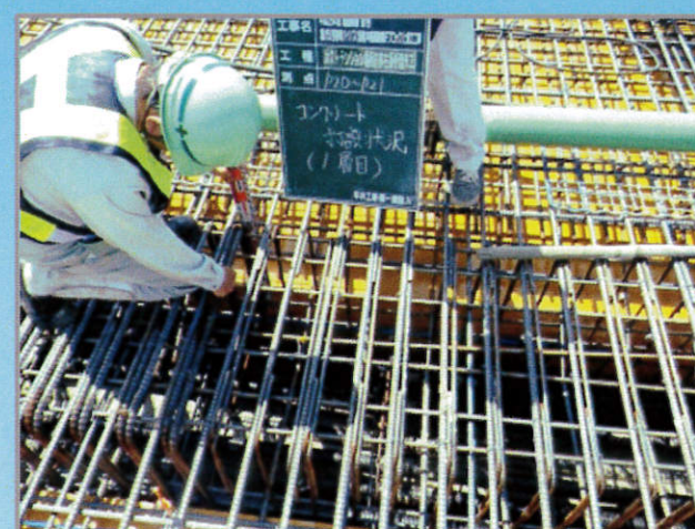
（写真-8 コンクリート打上げ高確認）
