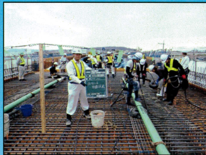
⑧コンクリート工打設
