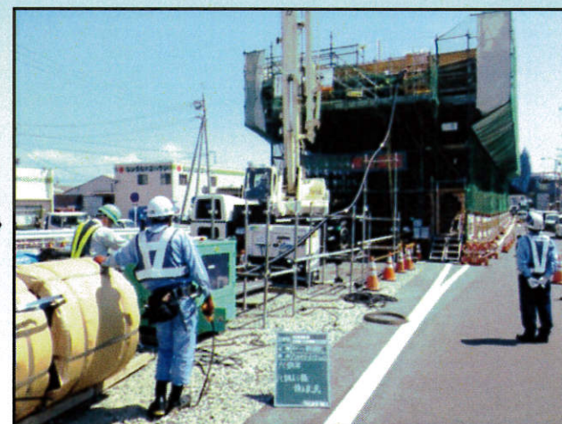
⑦-1PC鋼線挿入工
