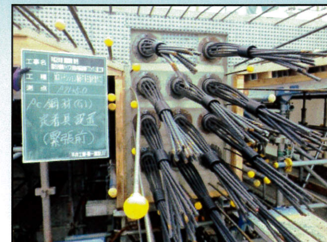
⑦-2PC鋼線挿入工
