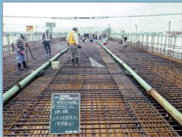
（写真-6 打設状況）
