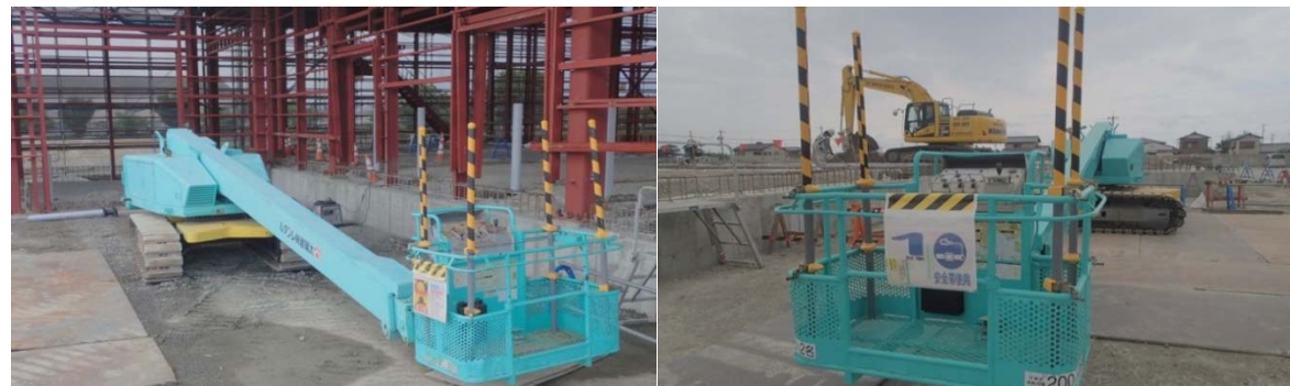
高所作業車:上部挟まれ防止用のハイフの設置
