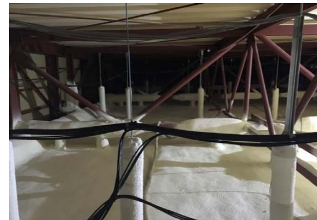
冷蔵庫天井裏防熱
