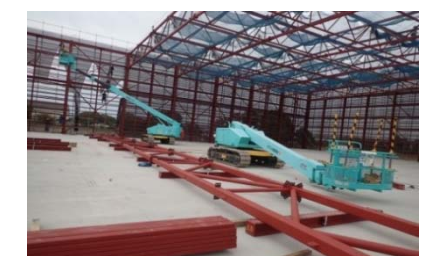
トラス梁地組状況
