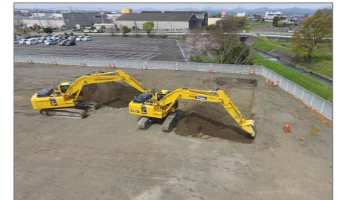
実際の施工状況(手元作業員不要)
