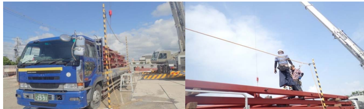
荷卸し時ルール:親網支柱の使用・荷台へは立馬の使用・運転手の荷台での作業の禁止
