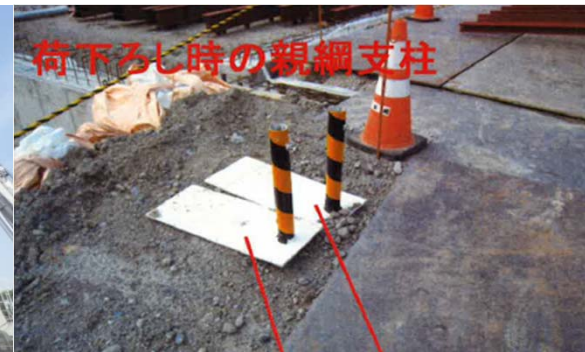
荷卸し時ルール:親網支柱の使用・荷台へは立馬の使用・運転手の荷台での作業の禁止
