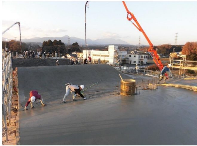
屋根スラブコンクリート打設状況(1)
