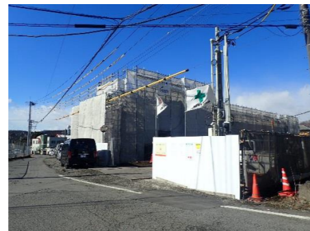
外部足場と仮囲い
