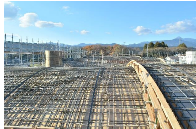
3種類のR曲面も、Lアンクルにてコンクリート天端の精度とコンクリートかぶり厚を確保しました。
