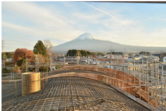
3種類のR曲面も、Lアンクルにてコンクリート天端の精度とコンクリートかぶり厚を確保しました。
