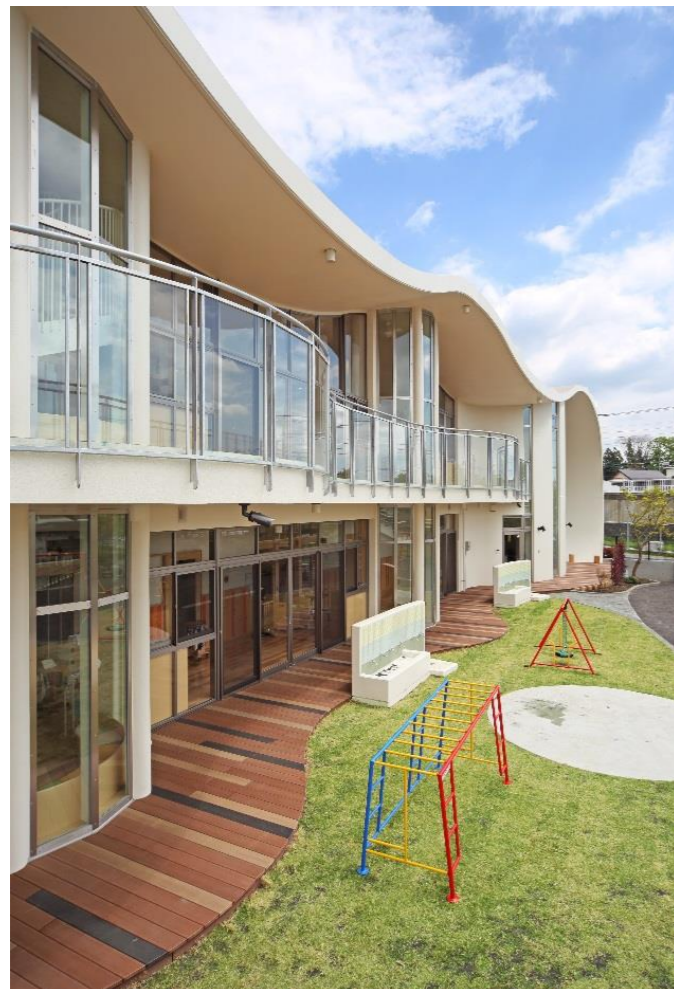
南面外観写真
