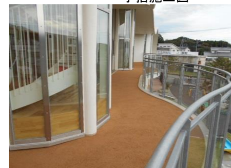
手摺取付完成状況
