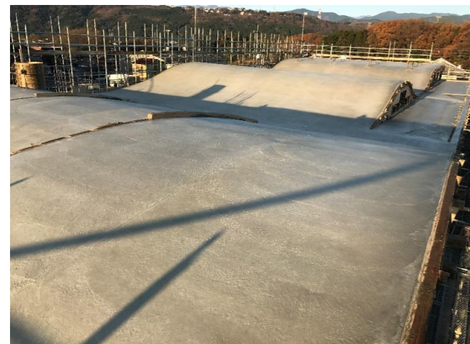
屋根スラブコンクリート打設完了
