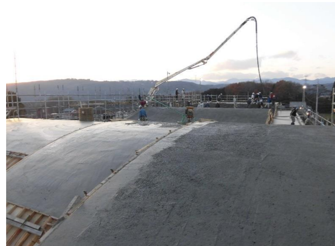
屋根スラブコンクリート打設状況(2)
