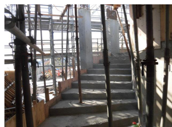
螺旋階段躯体 型枠解体完了
