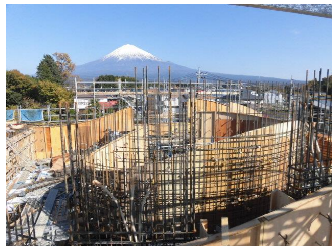
①壁型枠施工状況
