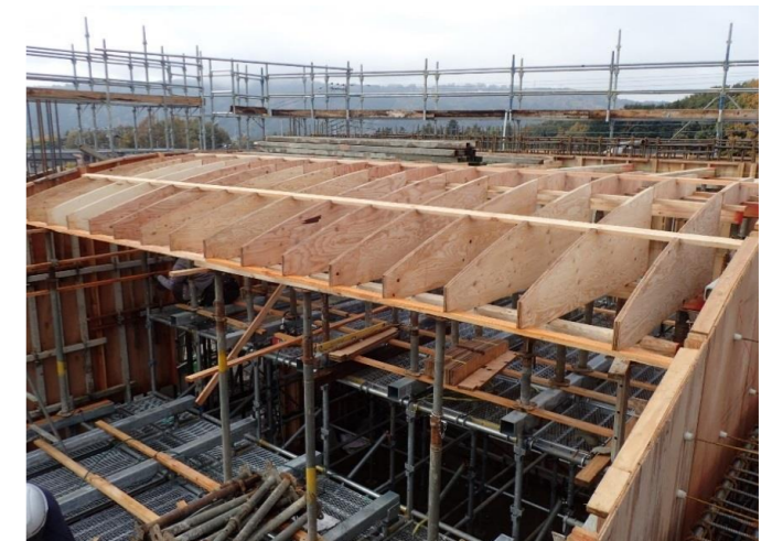
④特殊加工型枠による根太組立て
