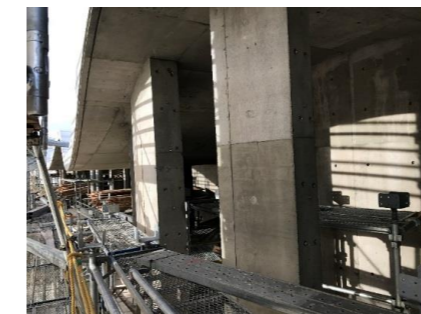
取付前躯体状況
