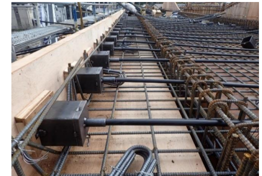
PC鋼線(緊張端) 配置状況
