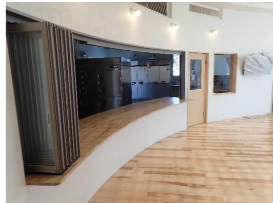
サッシ取付完成状況
