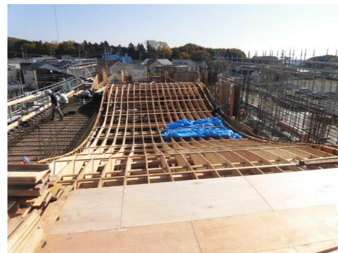
⑤特殊加工型枠による根太組立て
