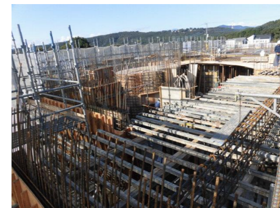
壁・スラブ型枠施工状況
