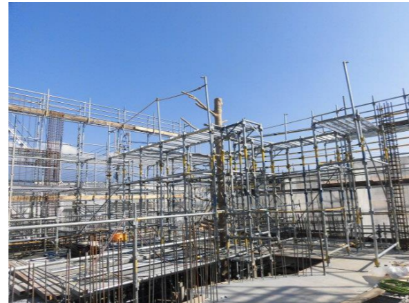
躯体施工途中に設置
