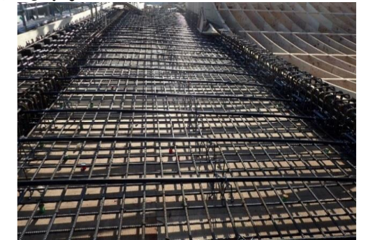
PC鋼線 配置状況
