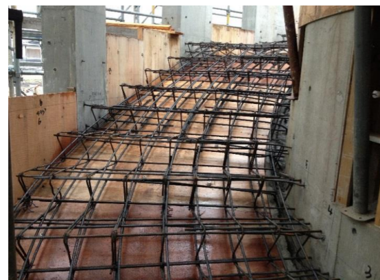
階段配筋状況
