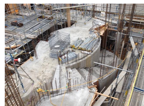
楕円壁・正円壁・螺旋階段躯体の外観
