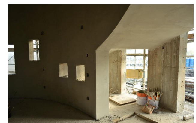
楕円壁・正円壁・螺旋階段躯体の内観
