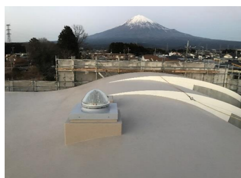
トップライト設置状況
