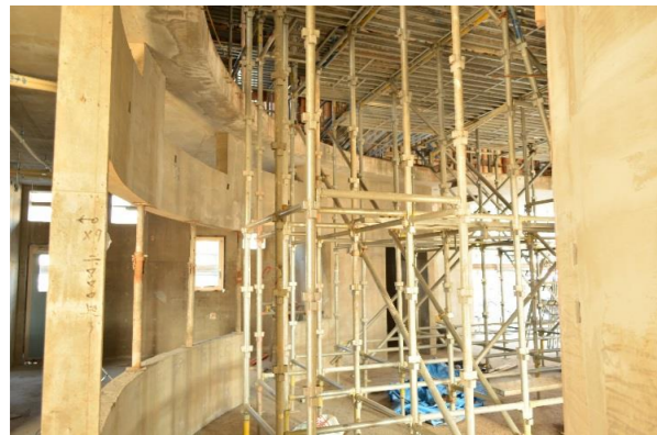
サッシ取付前の躯体状況
