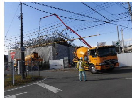
交通誘導員の配置状況
