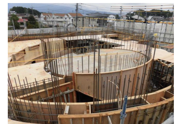
壁・スラブ型枠施工状況
