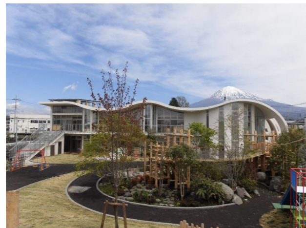
南面外観写真
