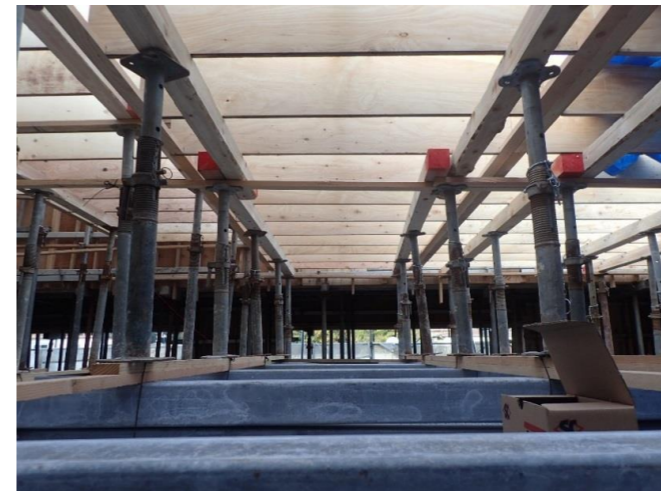
③スラブ型枠支保工組立
