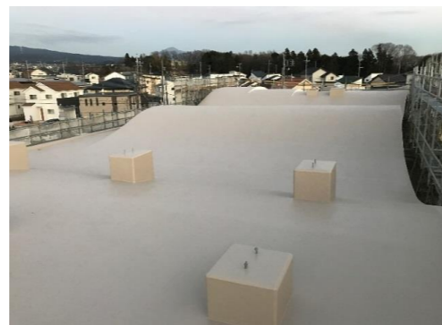
トップコート施工完了 躯体ラインがきれいに出た。
