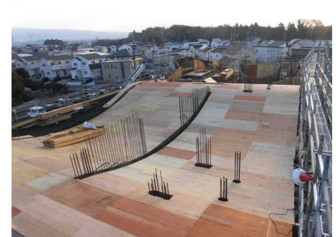
⑦スラブ型枠施工完了(屋根全体)
