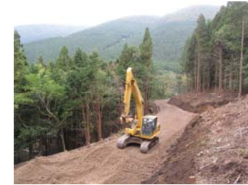
1-2. 仮設道路設置
