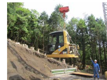
3-1. 重機解体吊り込み
