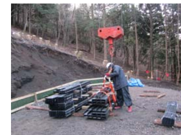
3-4. 使用材料吊り込み
