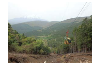
3-2. 重機解体運搬
