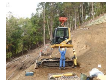
3-3. 重機搬入組立
