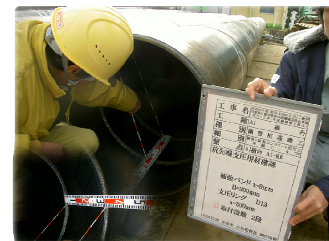
杭先端支圧用材確認写真②
