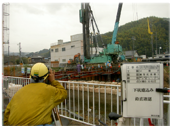
トランシットによる鉛直確認①
