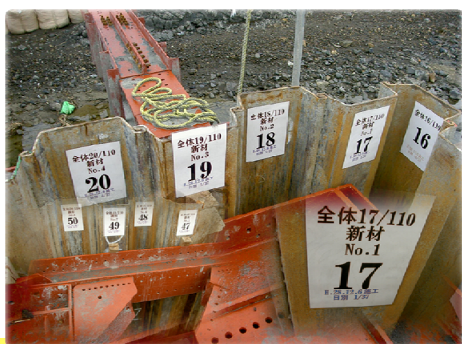
鋼矢板Ⅲ型新材明示写真
