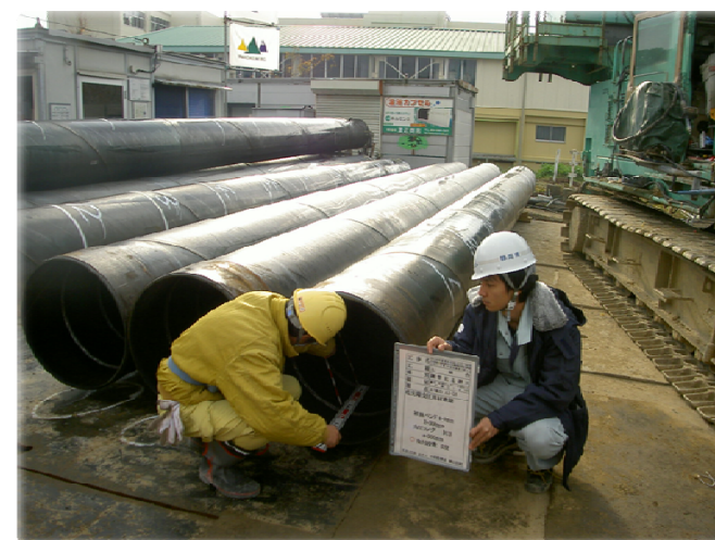
杭先端支圧用材確認写真①
