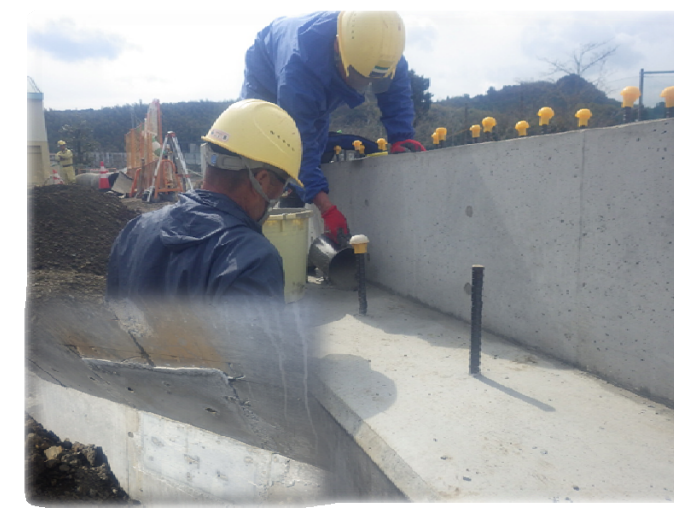
無収縮モルタル充填写真
