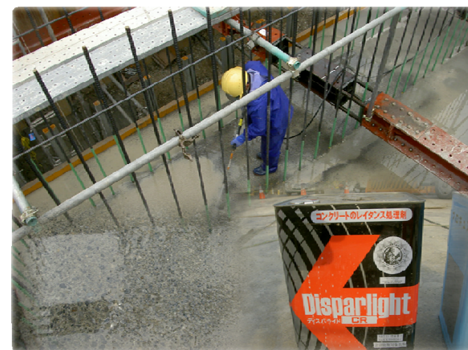
ディスパライト使用によるレイタンス処理写真
