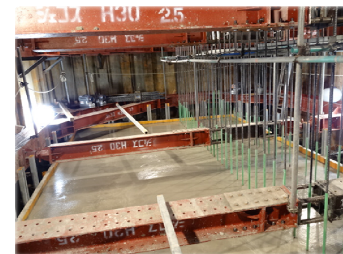
底版コンクリート天端仕上げ写真
