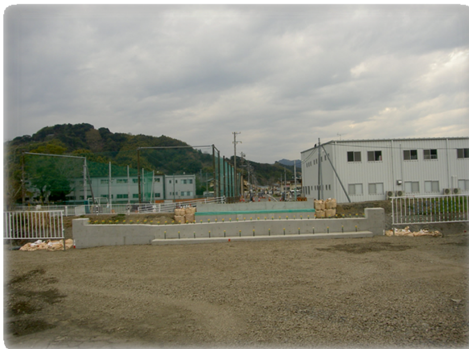
A1橋台完成写真
