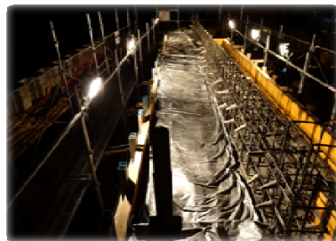
A2橋台堅壁天端養生写真
