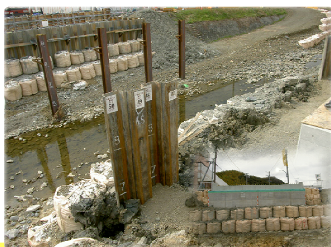
鋼矢板Ⅲ型残置圧入完了写真
