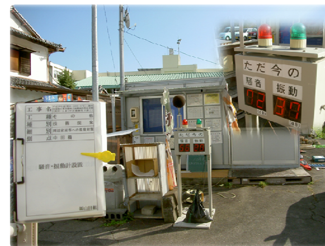
騒音振動計設置写真
