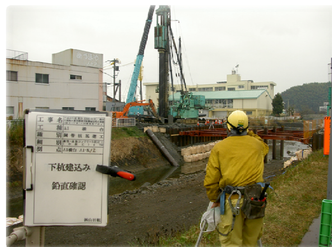
トランシットによる鉛直確認②
