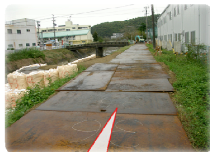
堤防道路鉄板設置写真
