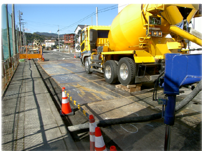
輸止付架台使用写真①
