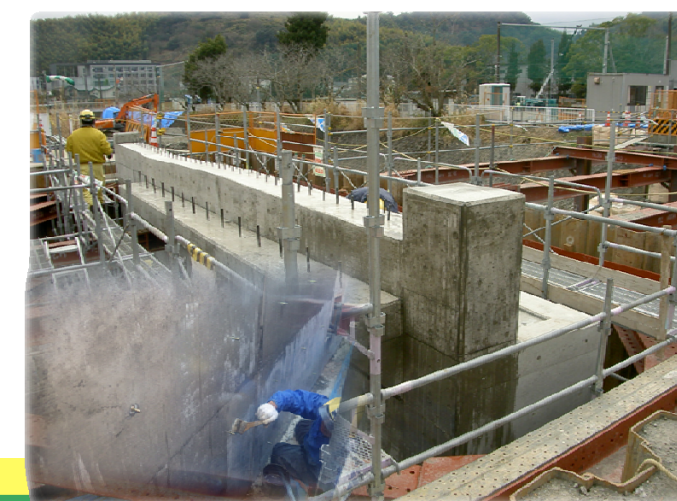
浸透型コンクリート表面養生剤塗布写真②
