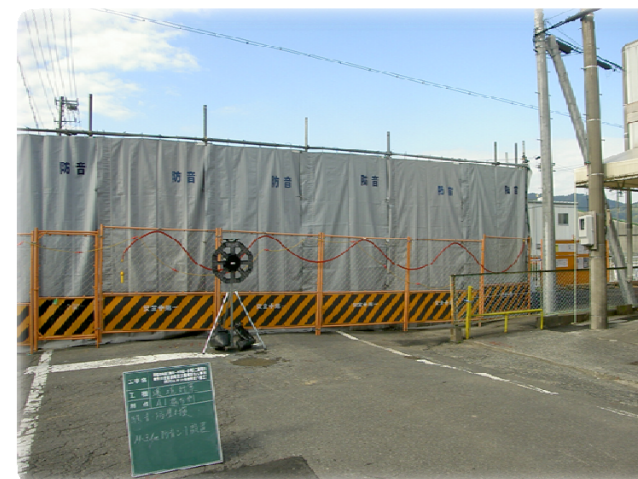
防音シート設置写真
