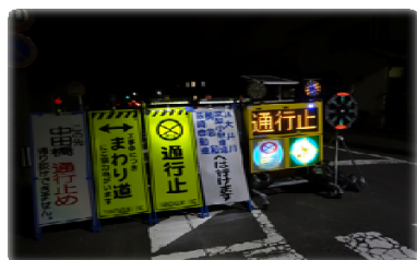
ソーラー式LED表示盤写真②
