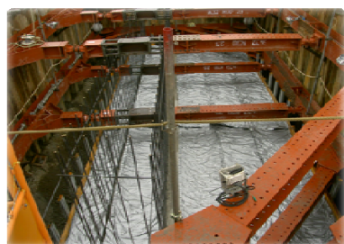
A1橋台底板側面養生写真
