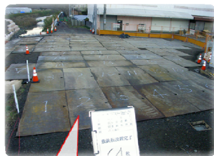
A1鉄板設置写真
