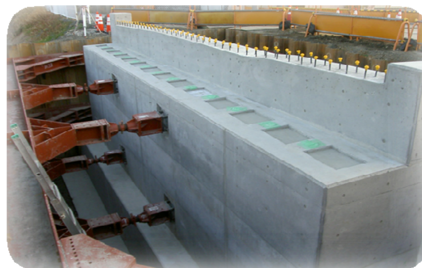
A1橋台完了写真
