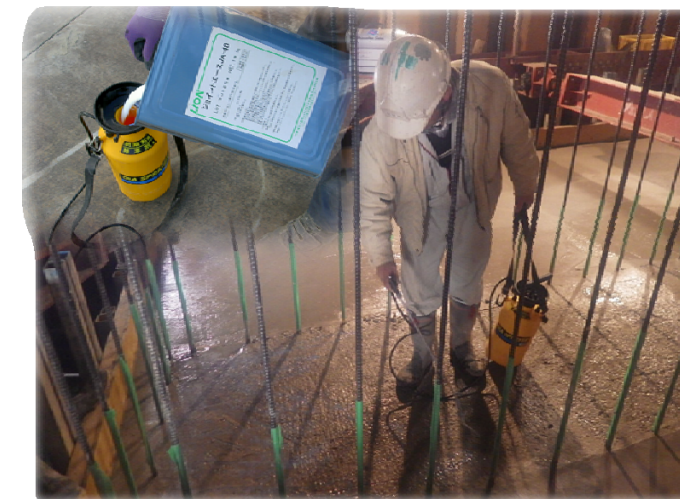
ジョイントエース使用による打継処理写真
