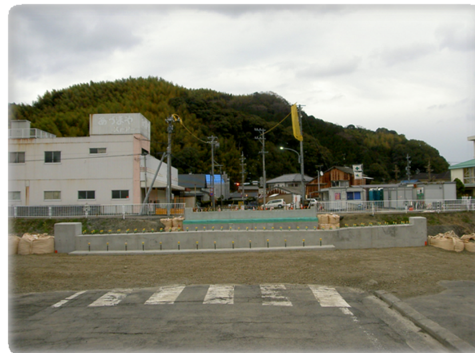
A2橋台完成写真
