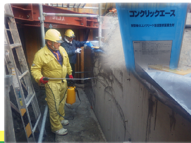
浸透型コンクリート表面養生剤塗布写真①
