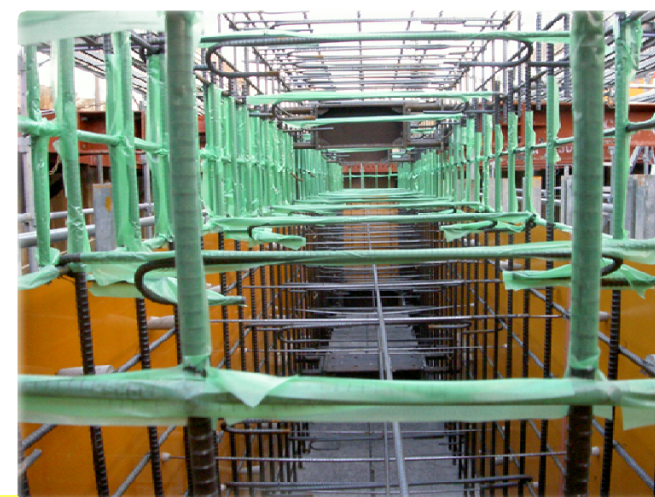
壁壁部鉄筋養生写真
