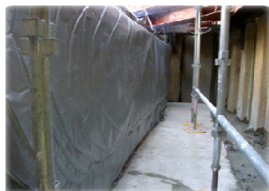
A1橋台底板側面養生写真
