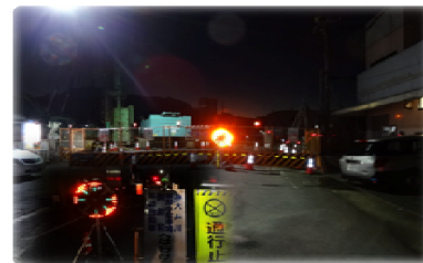
ソーラー式LED警告灯写真②
