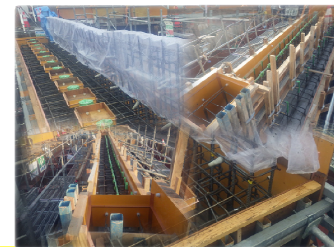
バラベット部・伸縮装置部・踏掛け受部鉄筋養生写真
