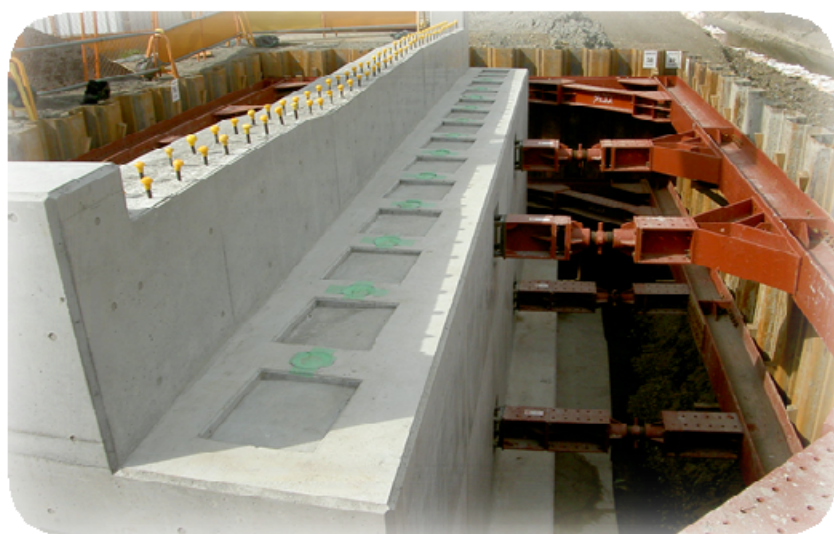
A2橋台完了写真
