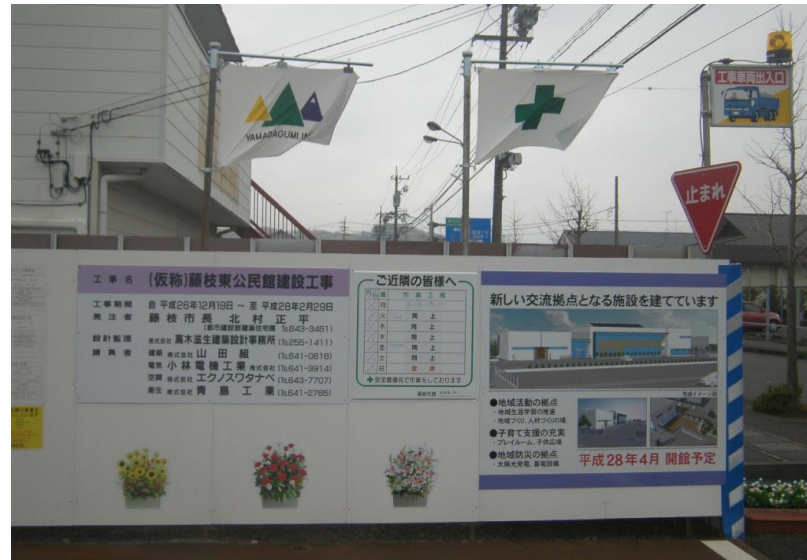
(現場入り口部分看板設置状況)
