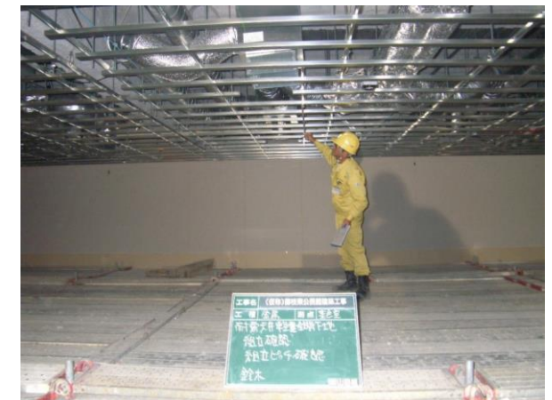
(耐震天井施工状況) ・施工状況確認実施
