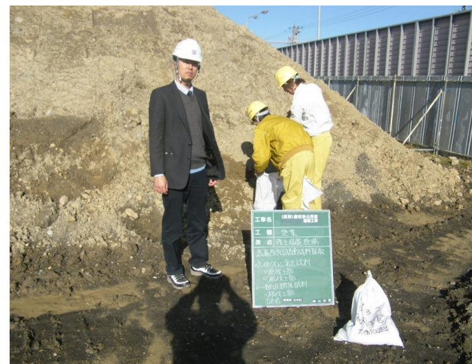
(杭残土施工前試験サンプル採取)
