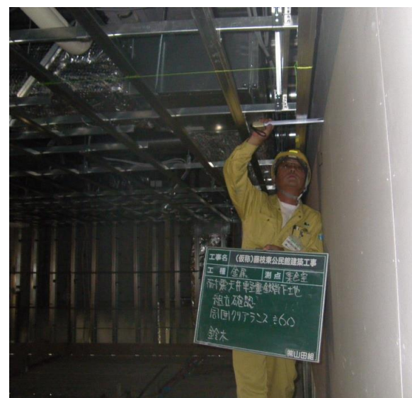
(組み立て状況確認) ・周辺クリアランス確認
