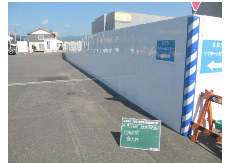
(実施施工状況)
