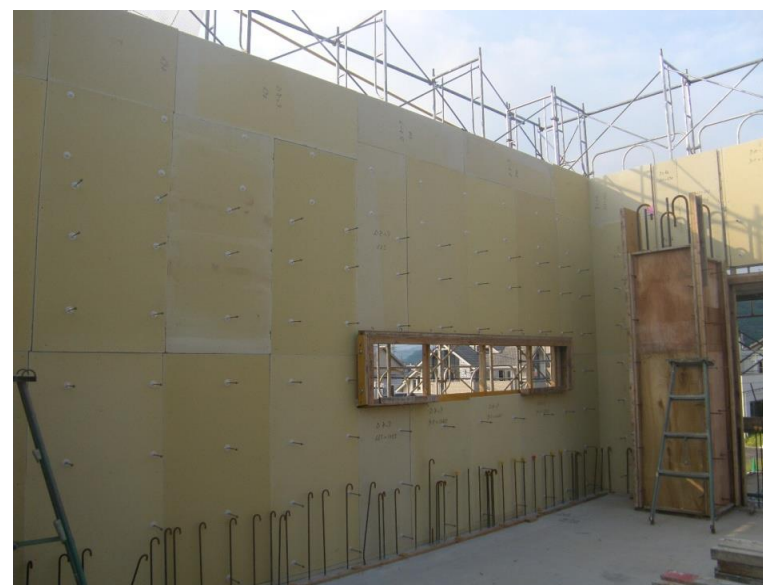
(断熱材取り付け型枠組み立て状況)
