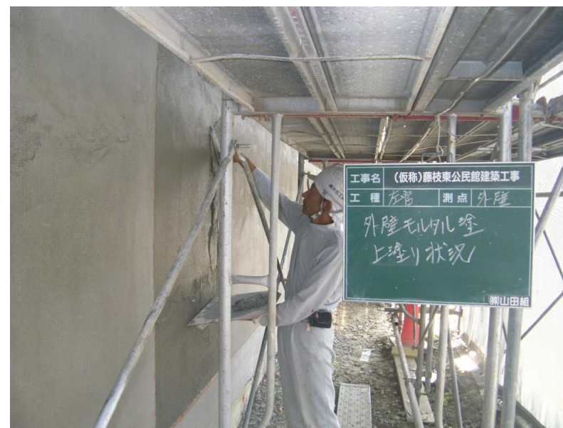
(下地モルタル施工状況)
