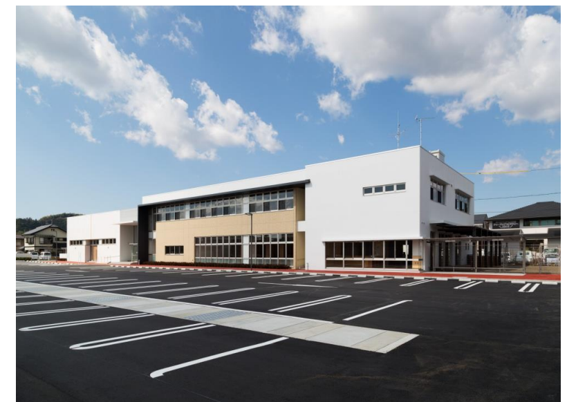
(外装仕上げ完了状況)
