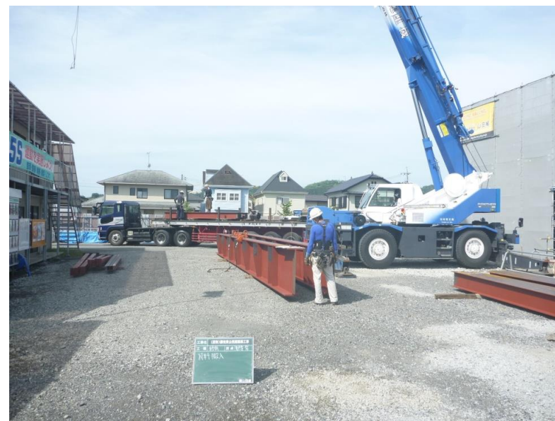
(鉄骨材料搬入時の状況)
