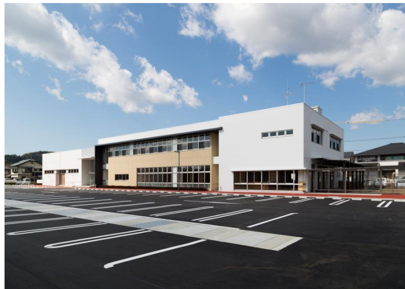
(外観・駐車場側より)
