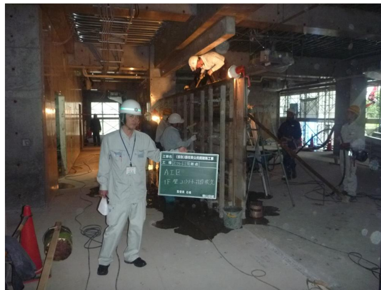
(後施工壁コンクリート施工)
