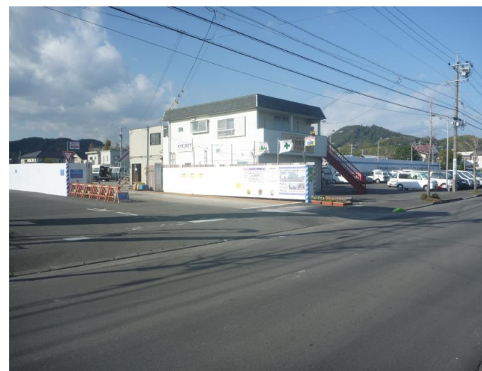
(実施施工状況)
