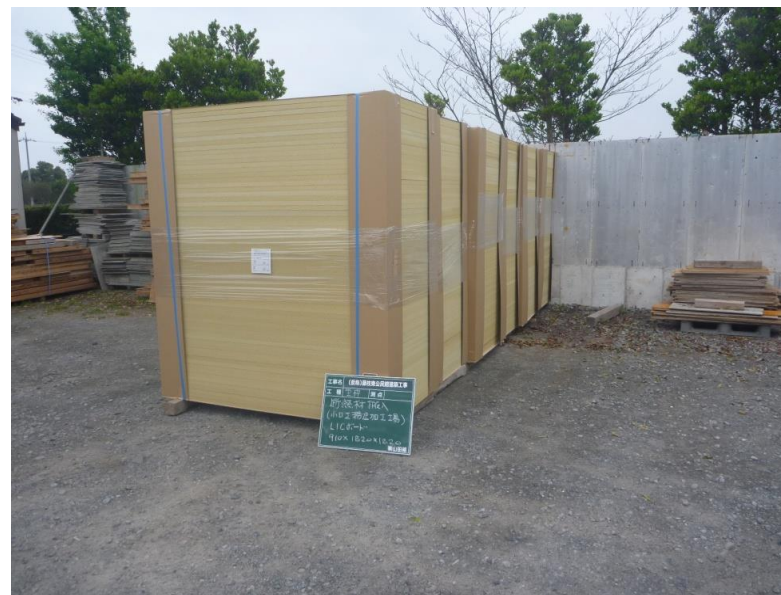
(断熱材型枠加工場搬入状況)
