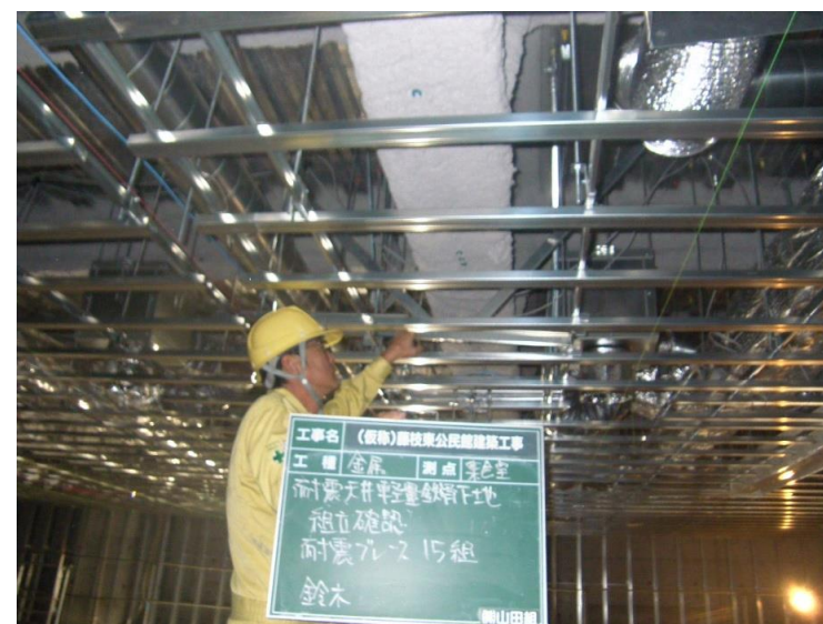
(組み立て状況確認) ・耐震ブレース取り付け状況確認
