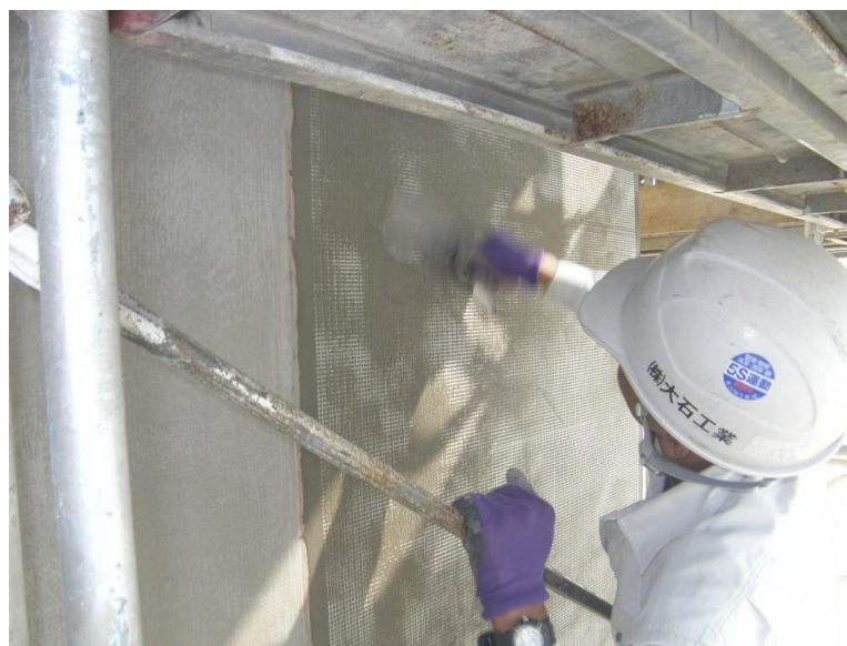
(硝子クロス繊維貼り込み状況)
