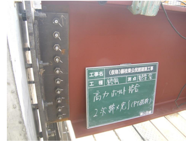
(コンクリート躯体部接続部分)
