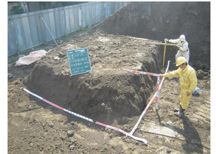
(地盤改良材添加確認状況)
