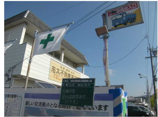
(ソーラー式照明灯の設置)
