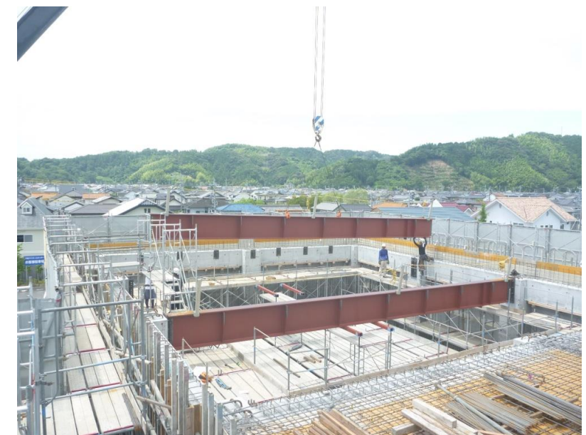
(集会室鉄骨架設状況)
