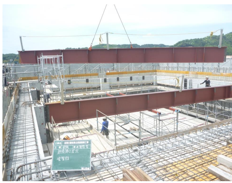
(鉄骨大梁の架設状況)
