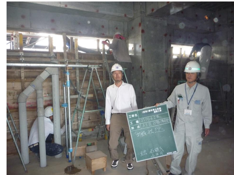
(後施工壁コンクリート施工)
