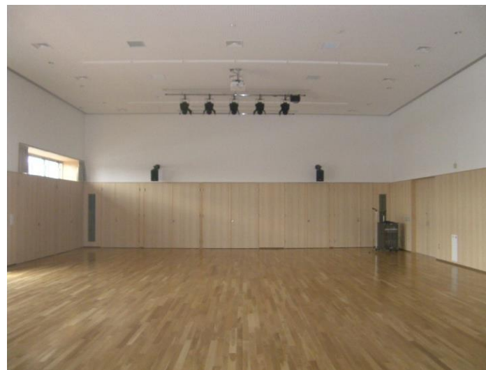
(集会室完成状況)
