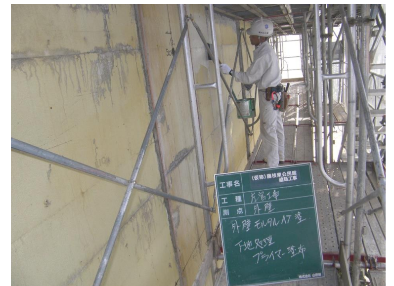
(外断熱材打ち込み型枠脱型後状況)
