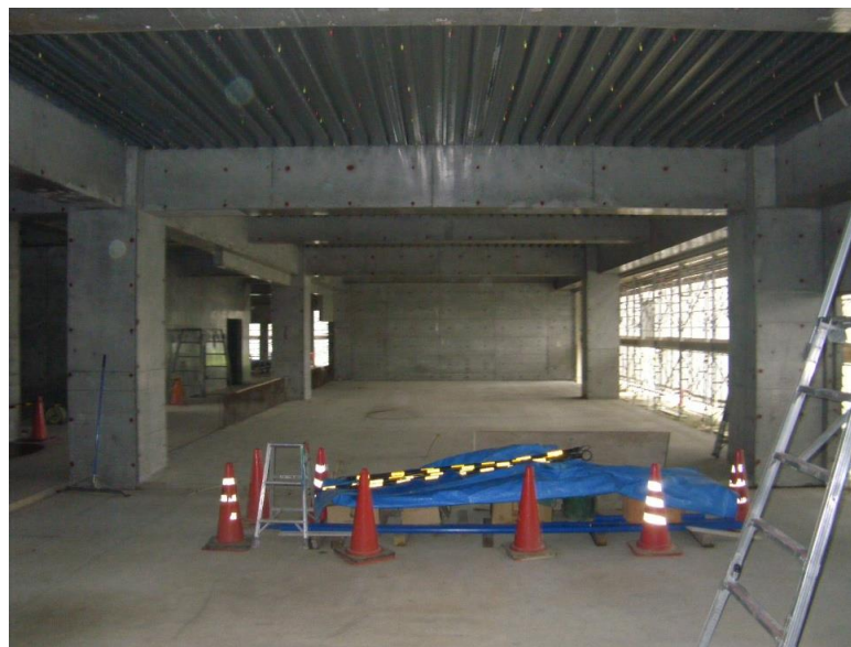
(型枠解体完了時の状況)
