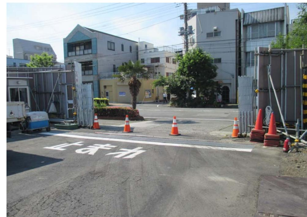
【 敷地内仮舗装（タイヤ洗浄用）、仮側溝（泥水流出防止）及び注意表示 】
