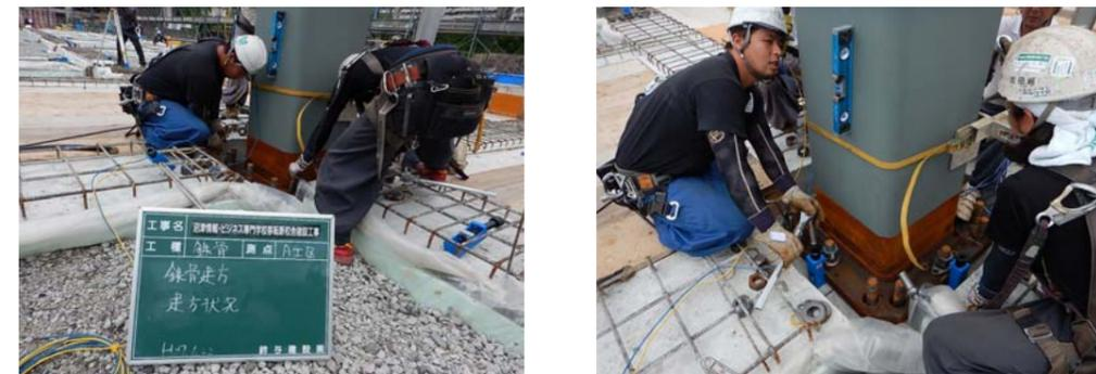
【柱脚冶具使用による鉄骨建方】
