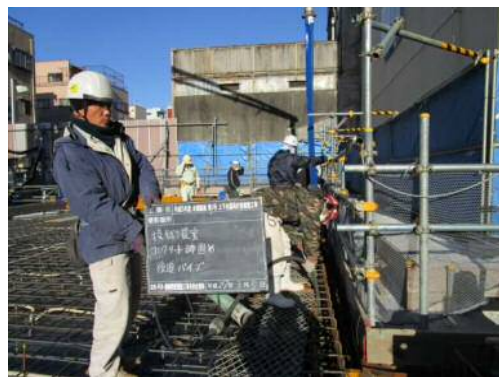
◀コンクリート打設状況（再振動による締固め）
