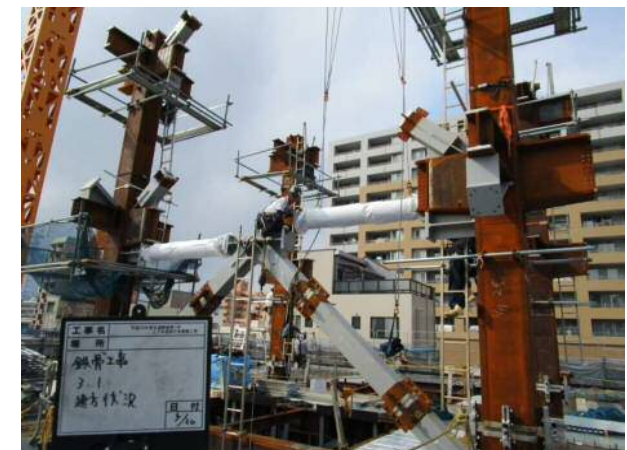
オイルダンパー取付状況（ダンパー養生済み）
