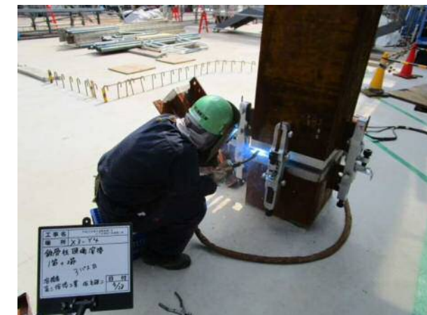
柱継手 現場溶接（板厚60mm）
