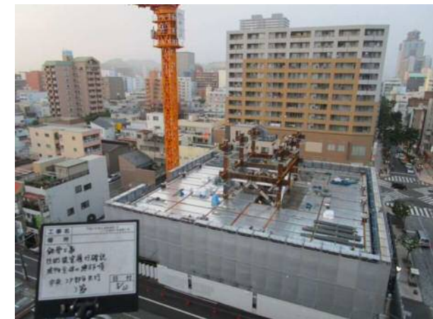
鉄骨建方状況（中央部先行）
