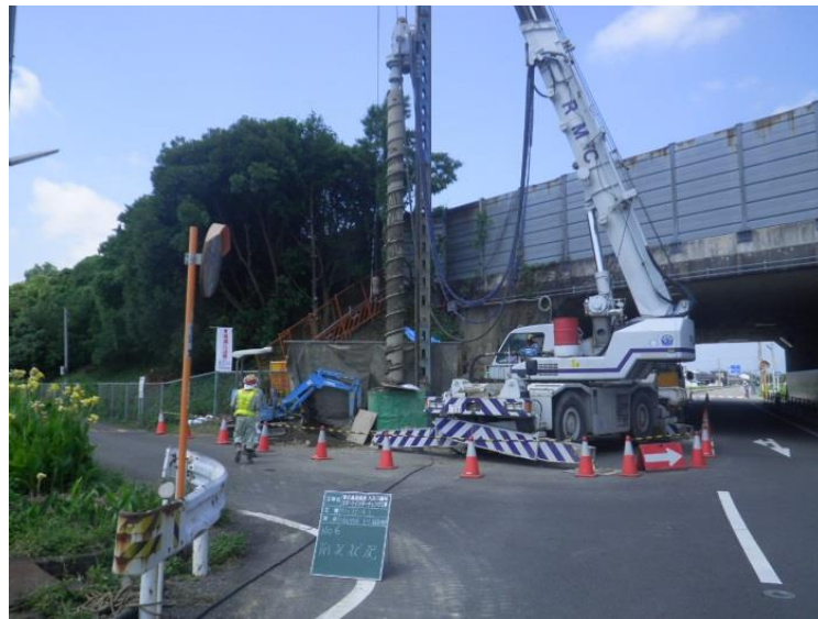
ダウンザホールハンマーにて削孔
