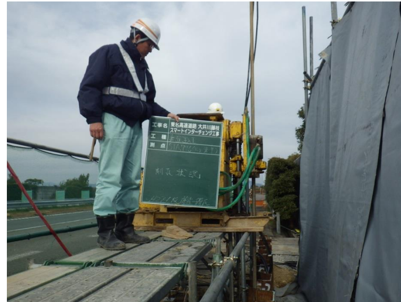
薬液注入工施工状況
