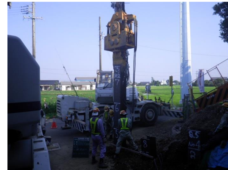
バイプロハンマーにて追加打設
