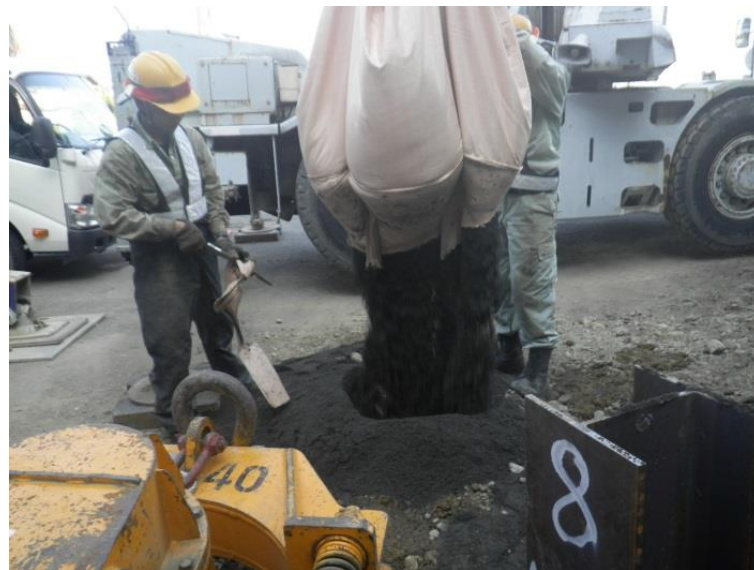
孔内砂充填にて完了
