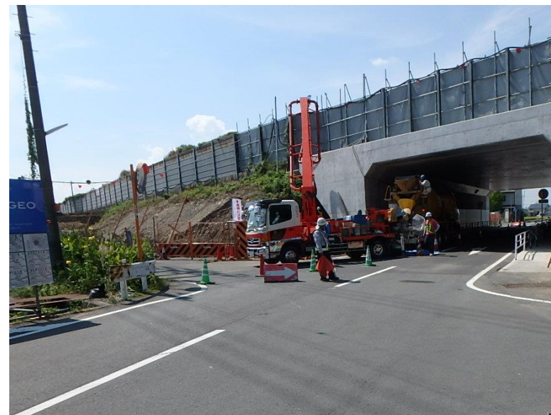
流動化处理土打設状況
