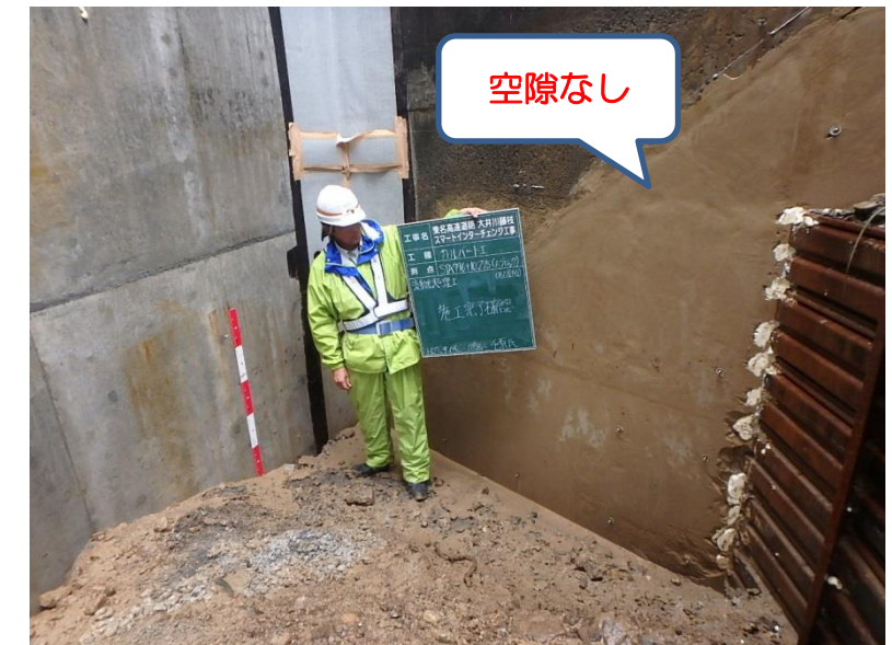
流動化处理土充填完了
