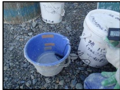
③ 攪拌完了後、PHを図り基準値に満たしていれば上水のみを処理し、沈殿した残コンは産廃処理を行った。
