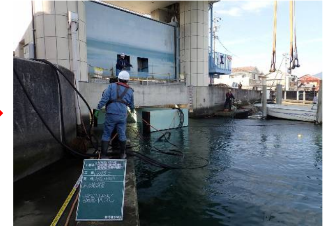
⑧(止水箱設置状況)
