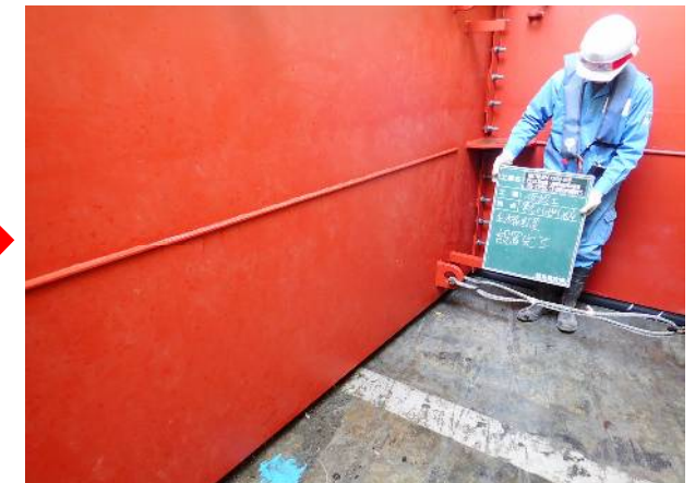
⑫(止水箱設置完了)
