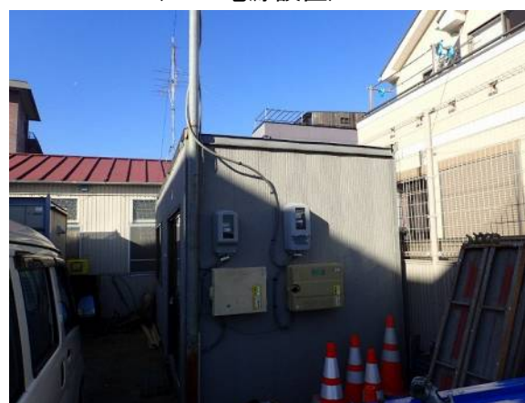
(200V電源設置)
