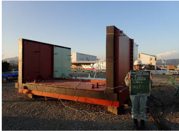
①(止水箱組立完了)
