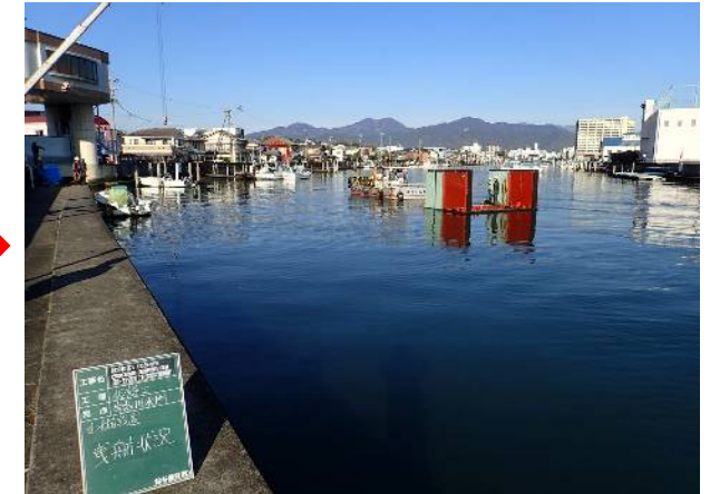
④(止水箱曳航状況)
