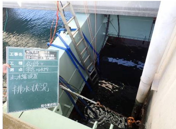
⑩(止水箱排水状況)
