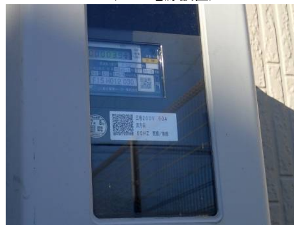
(200V電源設置)
