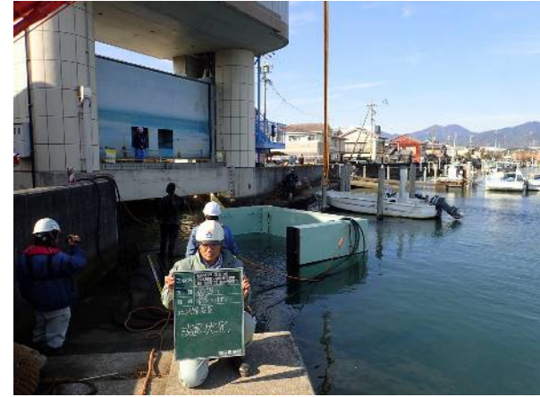
⑦(止水箱立起し完了)
