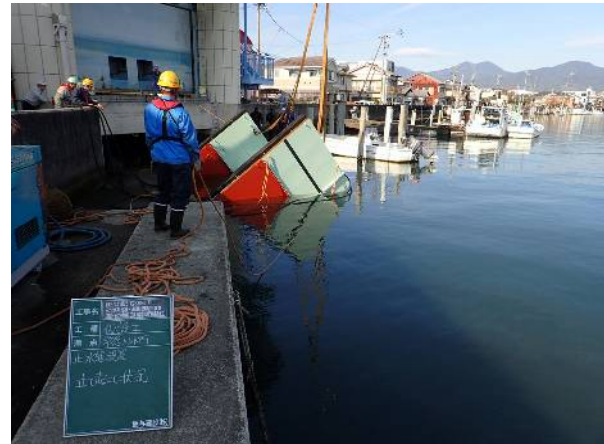
⑥(止水箱立起し状況)
