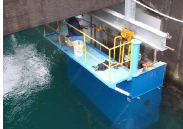
(従来工法の設置状況)
