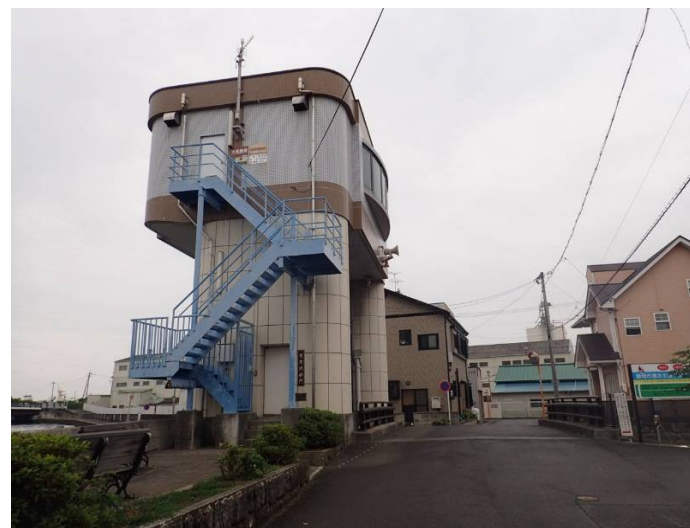
(施工箇所状況写真)
