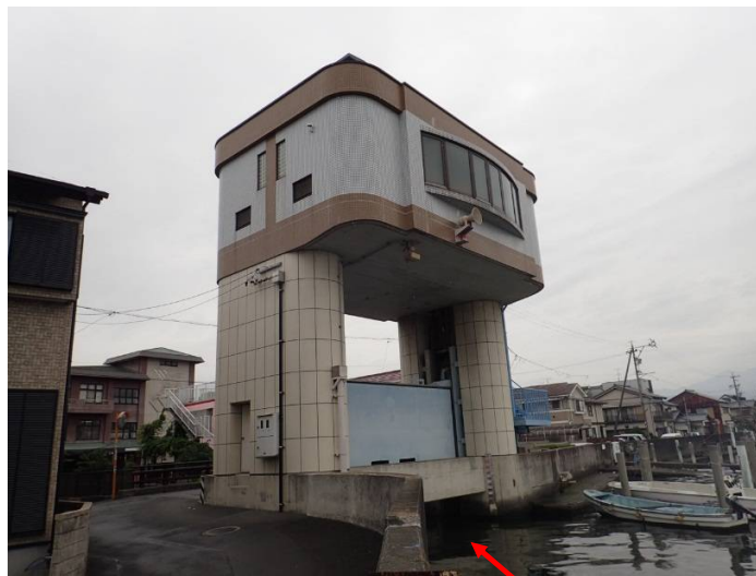
(施工箇所状況写真)
