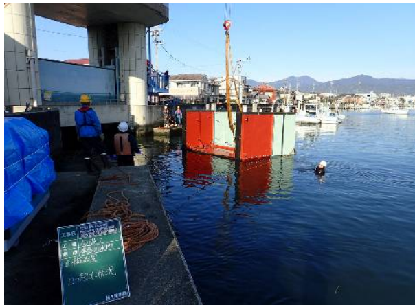
⑤(止水箱曳航完了)
