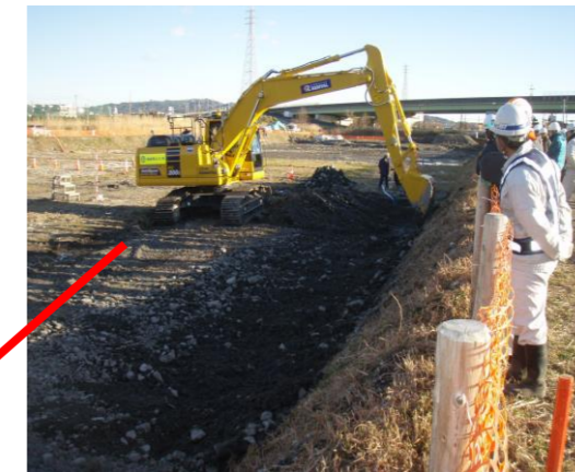
写真-8 MCバックホウ掘削作業
