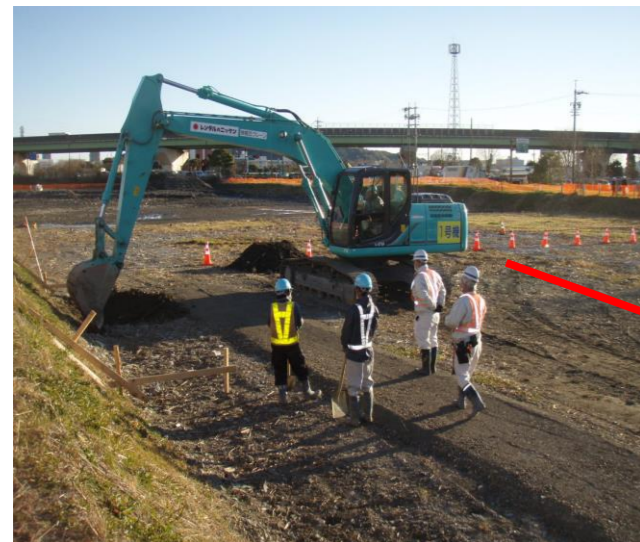
写真-9 ノーマルバックホウによる通常作業
