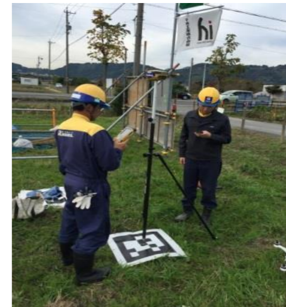
写真-5 GCP設置状況
