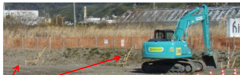
法丁張 写真-10 法丁張設置状況
