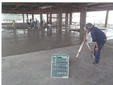
墨出工による高さの目視確認
