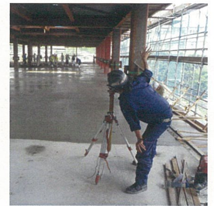
3階コンクリート打設 4階底枠工事済・上部スラブ工事中
