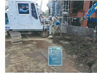
柱状改良施工状況
