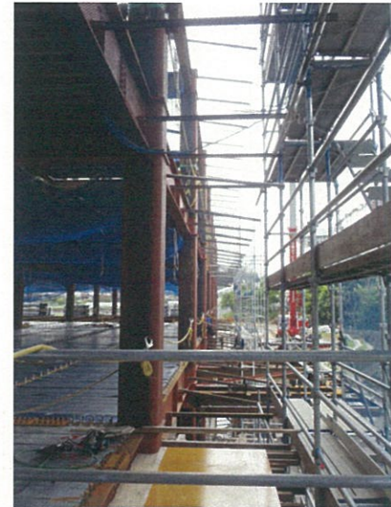
底枠先行施工状況
