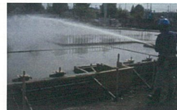
床スラブへの散水状況
