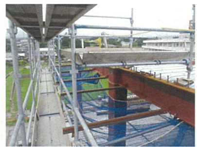
底受けアングル取付状況
