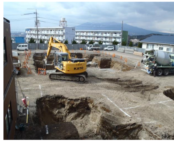
②基礎掘削状況
