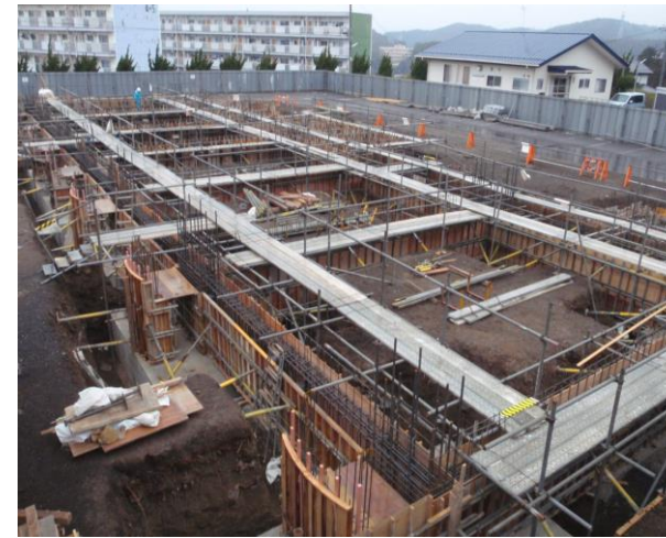
③地足場組立
