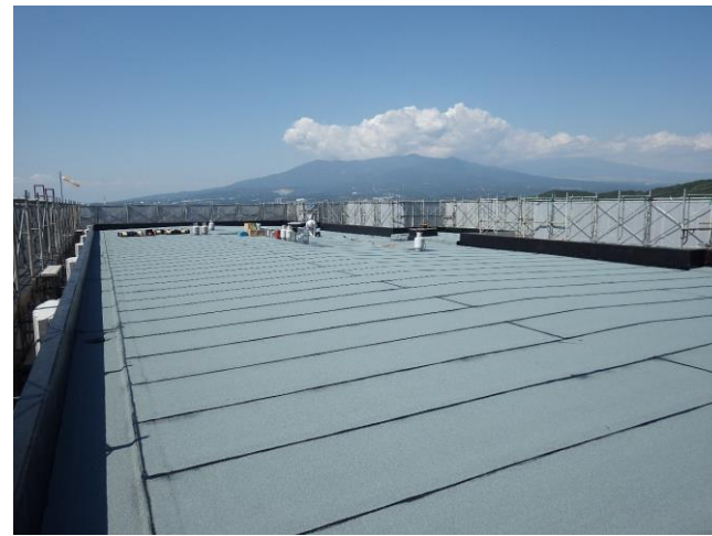
⑩屋上防水
