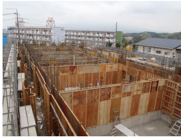
⑥躯体施工
