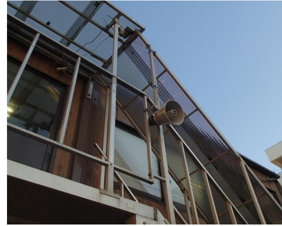
放送設備の設置(パソコン連動)
