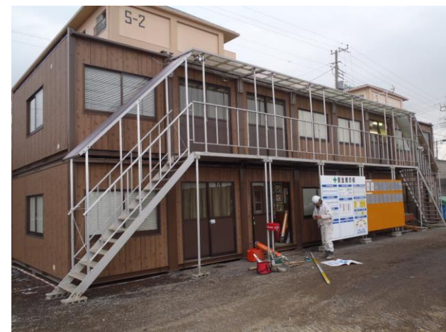
現場事務所(8連棟2階建て)
