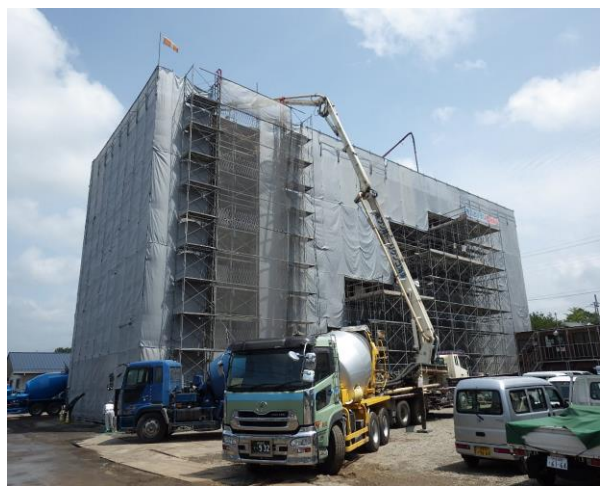
⑨コンクリート打設
