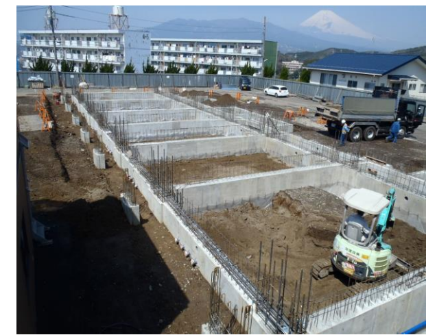
④基礎完了
