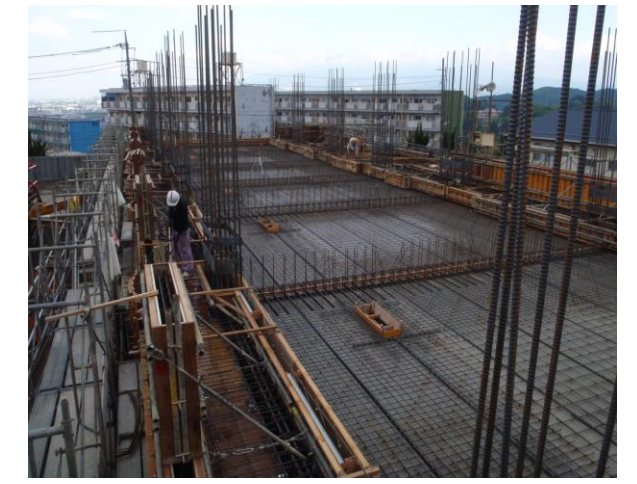
⑧コンクリート打設前
