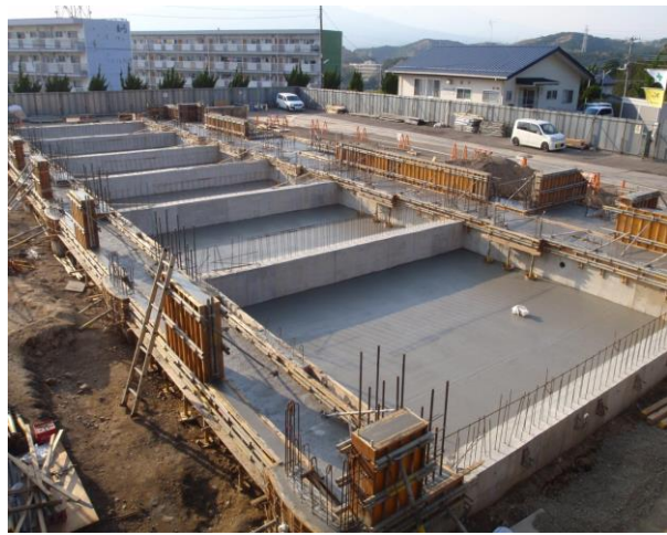
⑤1階土間完了
