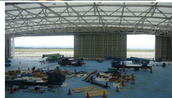
⑦この間に土間上での作業車作業を全て完了させ、後に続く塗床工事の施工期間を確保した。
