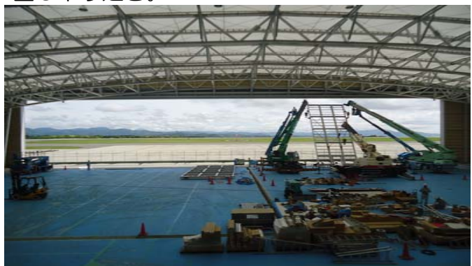
⑤大扉吊込み ※2台で上部を吊り、1台で下部を吊り斜めに専用レールに吊り込む。
