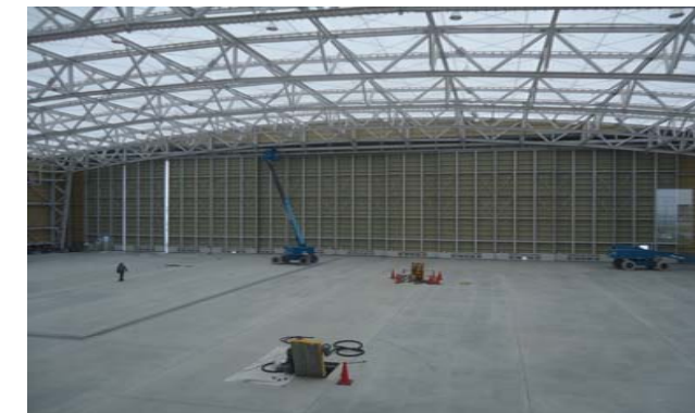
⑨角波貼り完了と同時に塗床工事に着手する。
