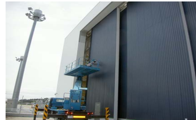
⑨角波張り（外側）
