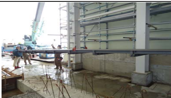
①専用レールの設置
