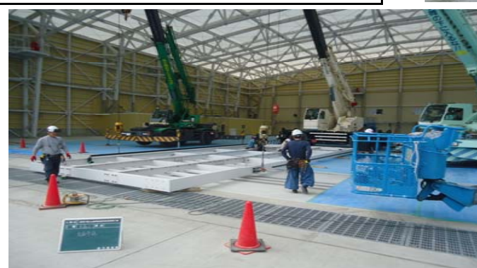
④大扉吊り込み ※隣が空港制限区域の為、室内に揚重機を設置し吊り込む。
