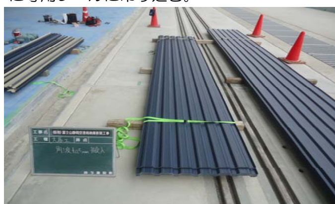
⑥強風による土間上重機作業の遅延を防ぐため、ガルバリウム鋼板は後付けとした。
