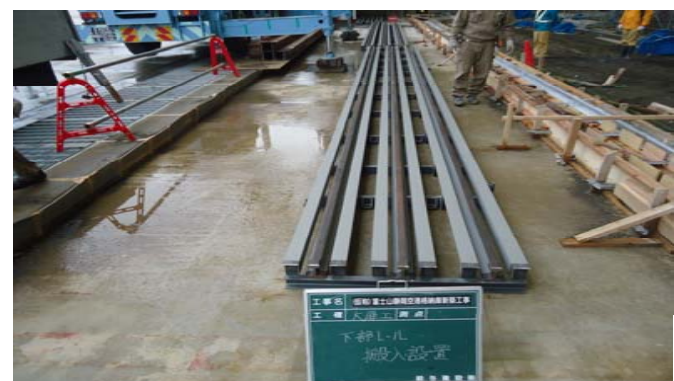
②レール設置完了
