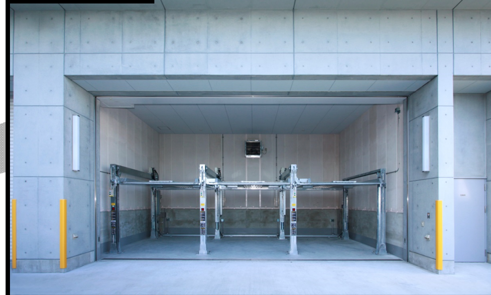
消防署車庫（耐震天井）
