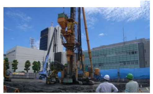
■サンドコンパクション工事(液状化防止対策)
