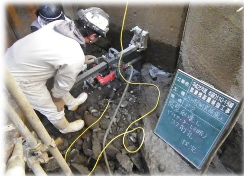
ワイヤーソーイング施工状況
