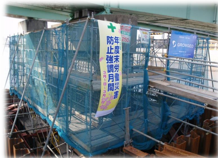
足場組立完了
