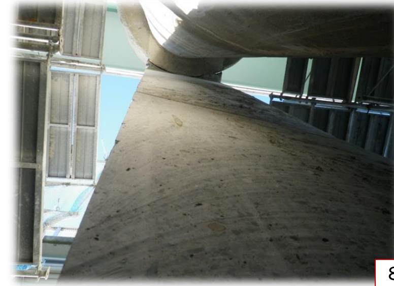
隔壁撤去完了 (下から撮影)
