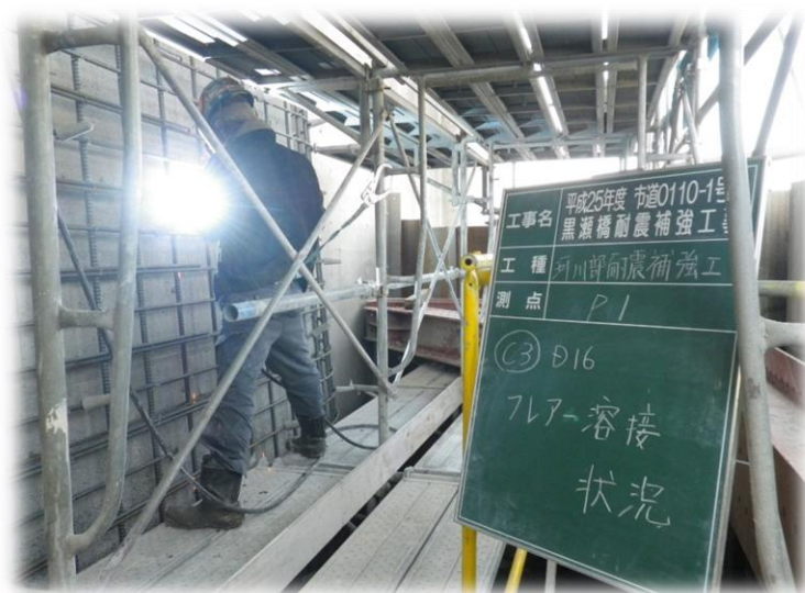
鉄筋組立 フレア溶接状況
