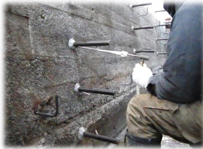
中間貫通棒定着状況 (可動支承のP2橋脚で施工)
