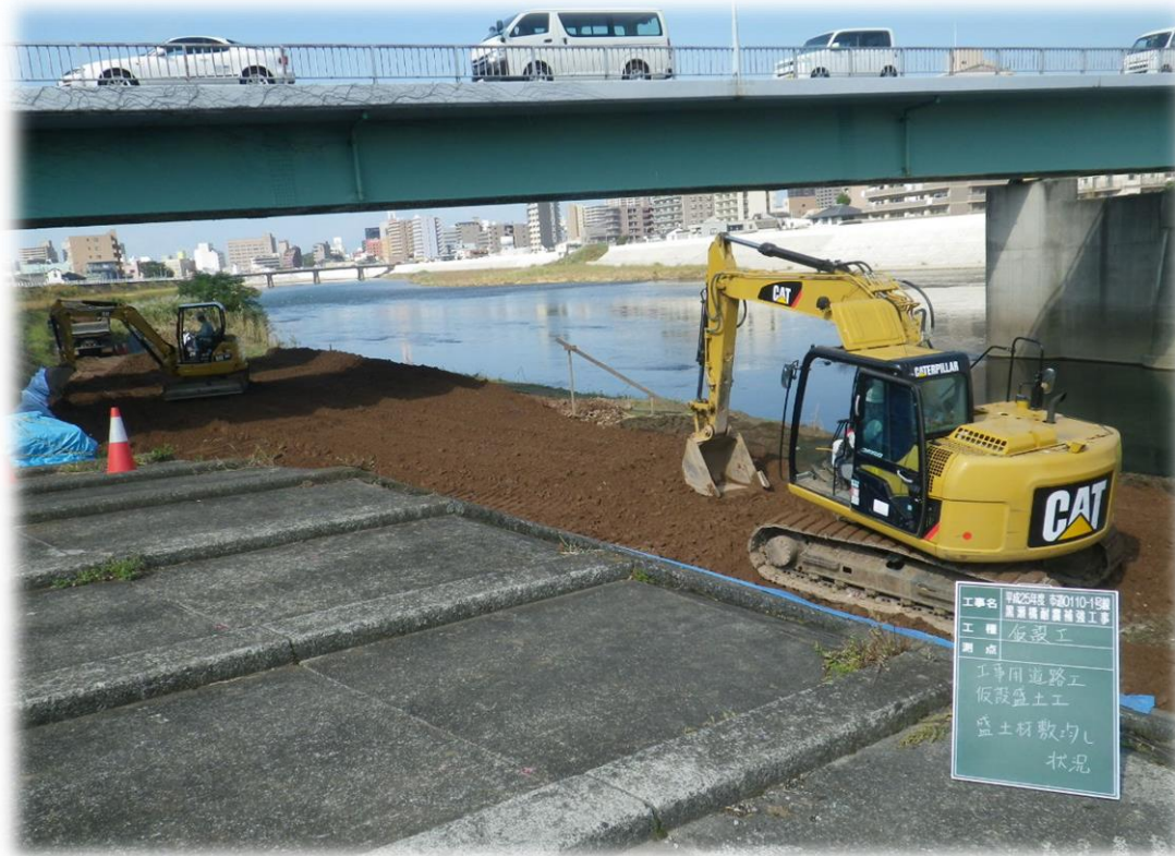
盛土状況 (購入土)
