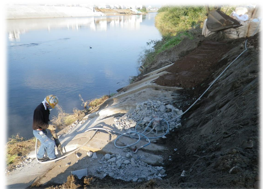
杭打ち箇所護岸研り状況
