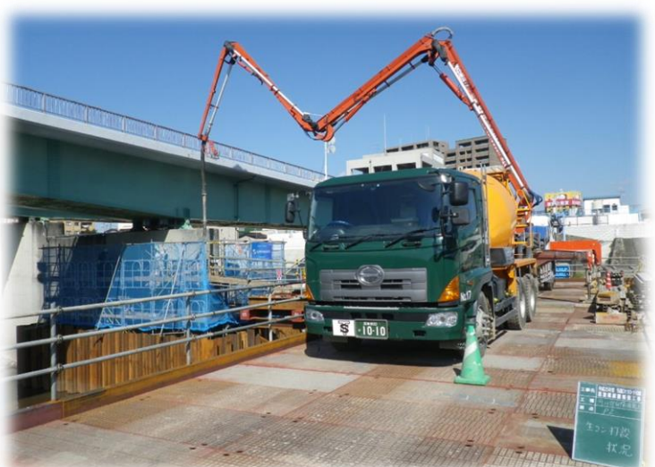
コンクリート打設状況
