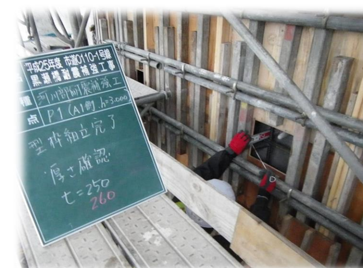
型枠完了 厚さ確認
