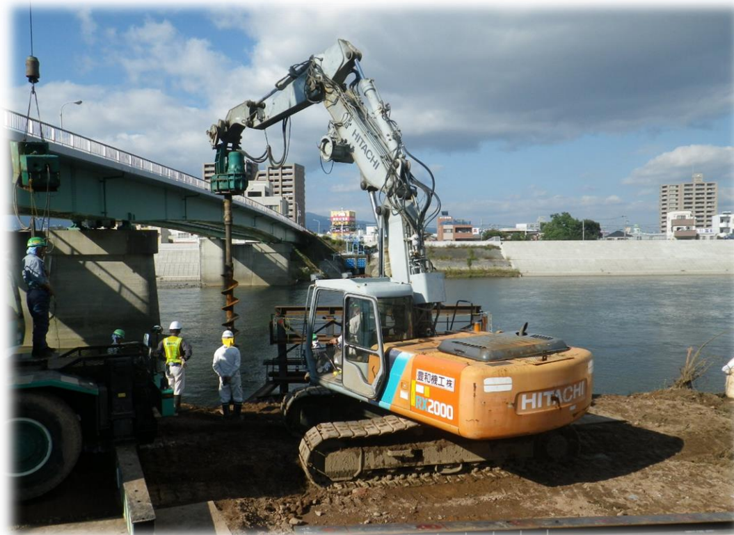
K1・K2は転石が多く アースオーガー併用で打設した。(創意工夫)
