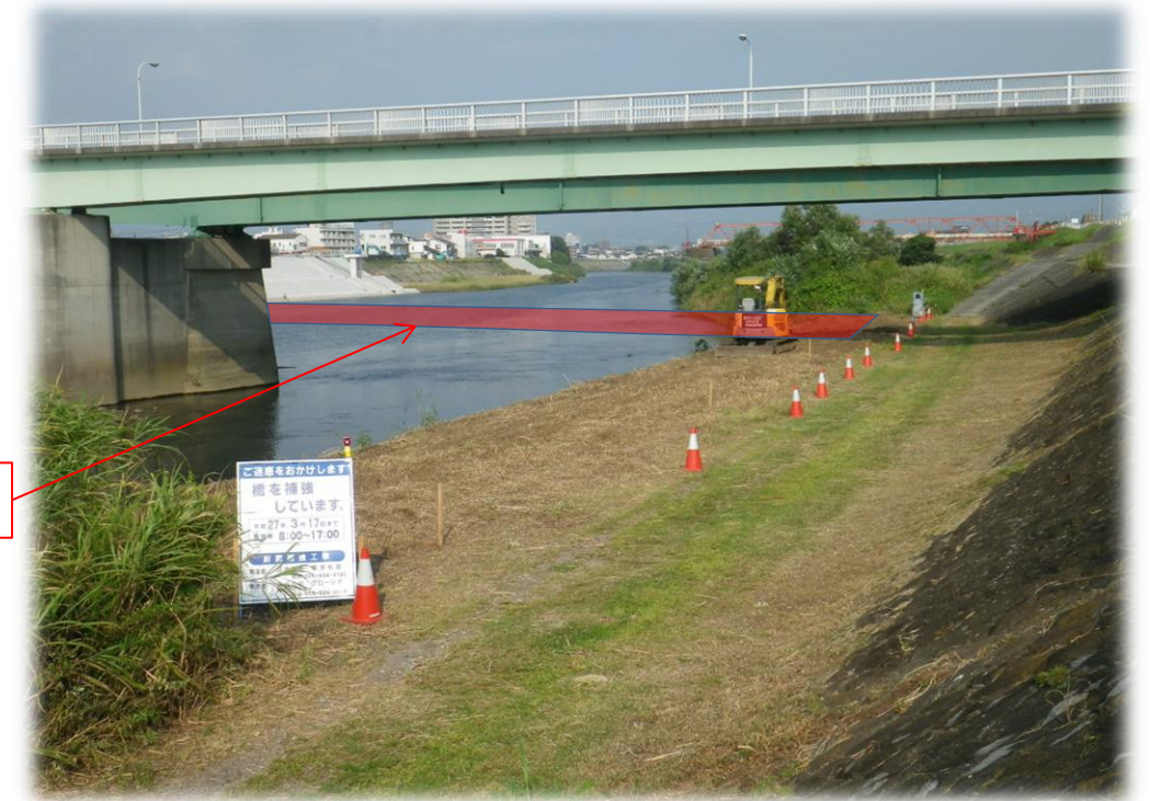
看板設置・草刈り完了
