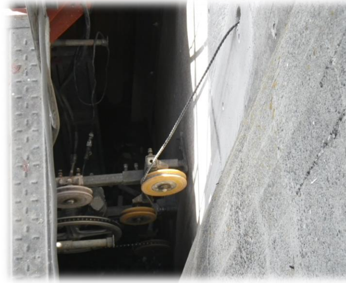
ワイヤーソーイング施工状況
