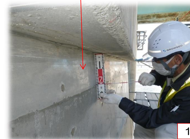
無収縮モルタル打設完了
