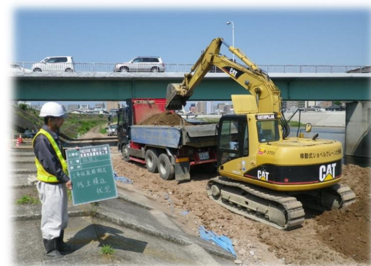
盛土材撤去状況
