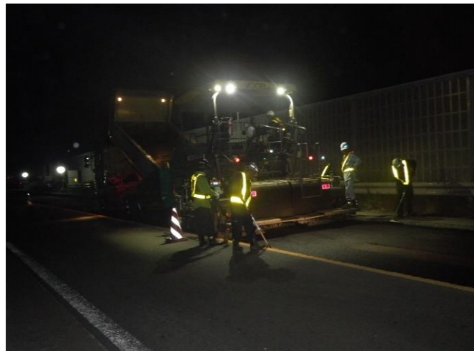
基層:敷設状況
