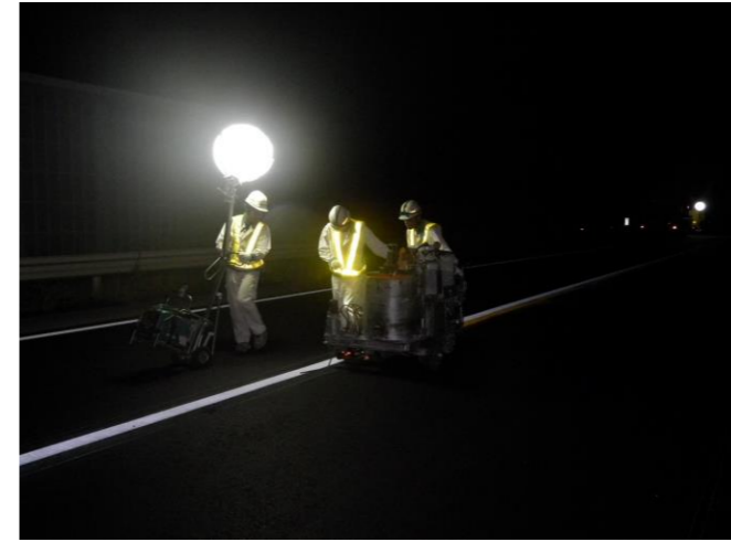
区画線:施工状況
