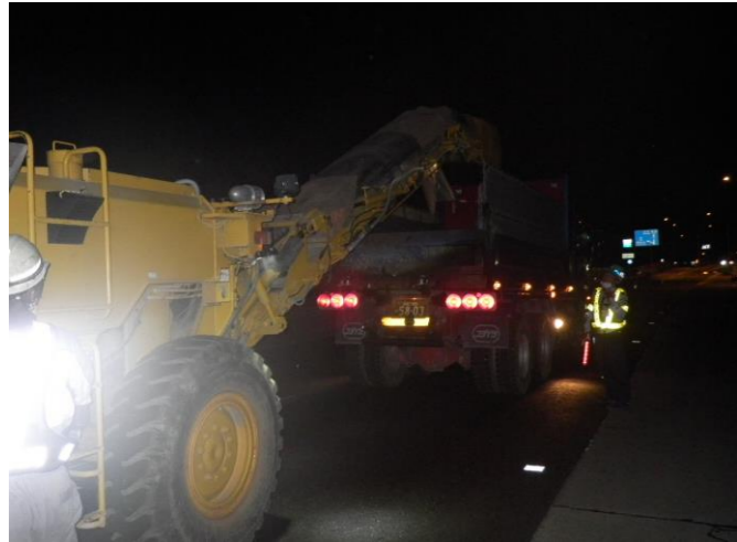
2次切削:施工状況
