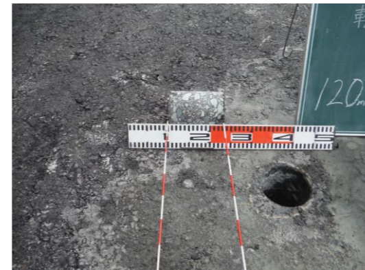
試験施工後の抜き取りコアによる密度測定
