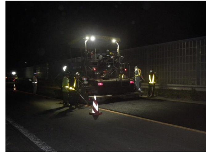
中間層:敷設状況
