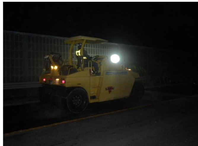
基層:転圧状況
