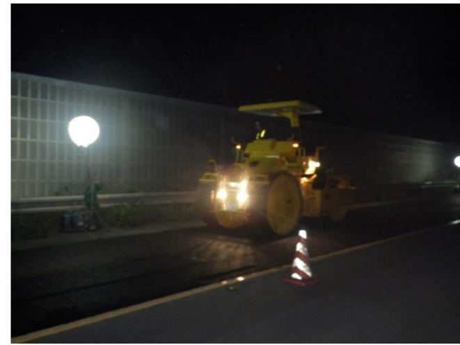
中間層:転圧状況
