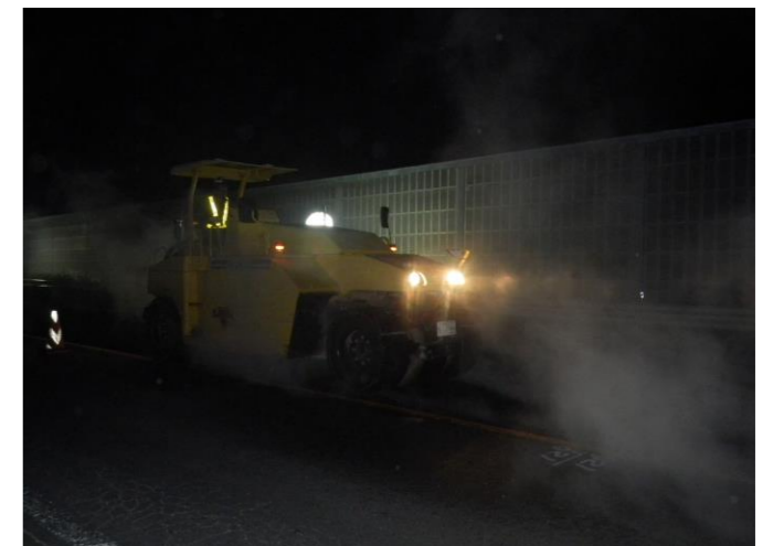
中間層:転圧状況
