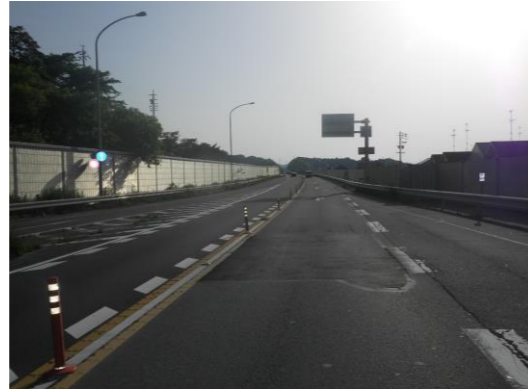
着手前(終点より起点を望む)
