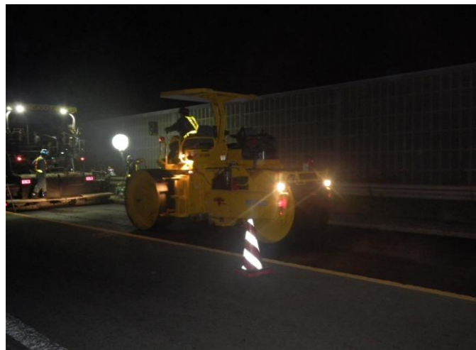
基層:転圧状況
