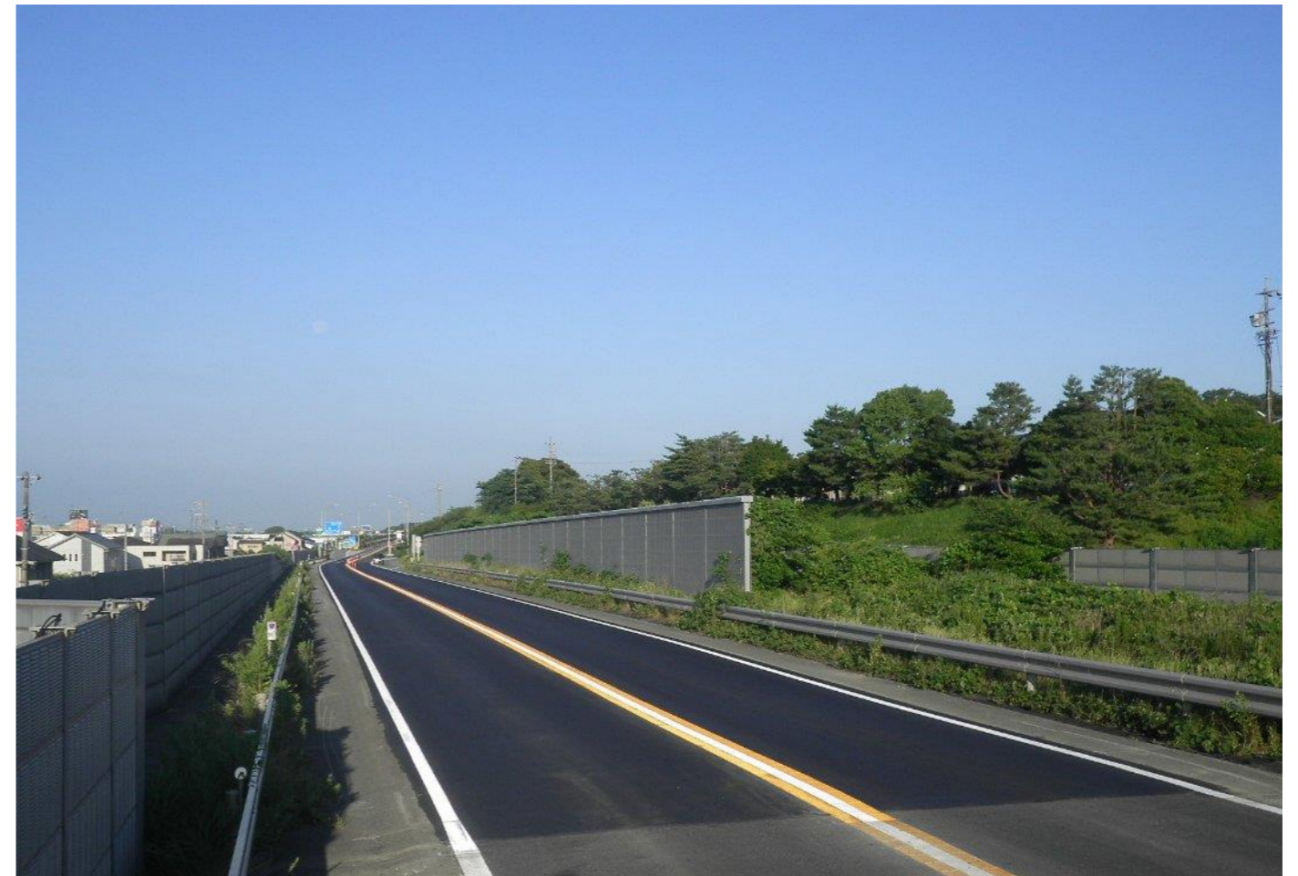
起点より終点を望む
