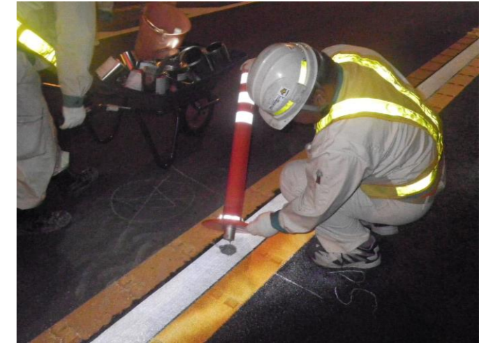
道路付属物:施工状況
