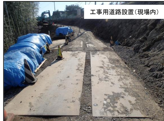
国道1号取付工事用道路 施工箇所
