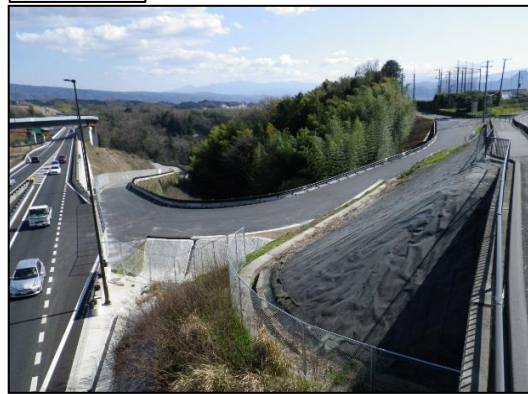
国道1号取付工事工区
