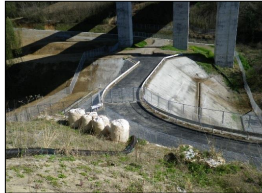
塚原付替道路工区
